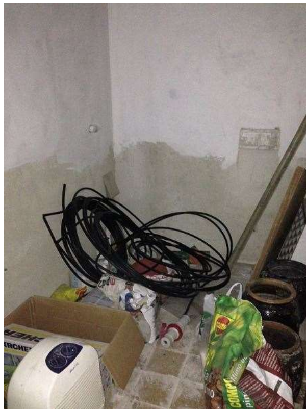
Foto n°30: LOCALE CON PREDISPOSIZIONE PER BAGNO
