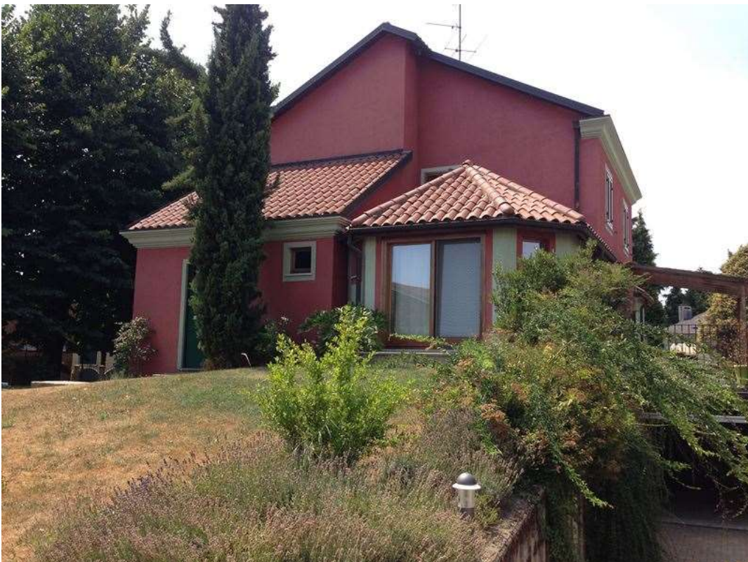
Foto n°14: VISTA DELL'IMMOBILE DALL'ESTERNO - EST
