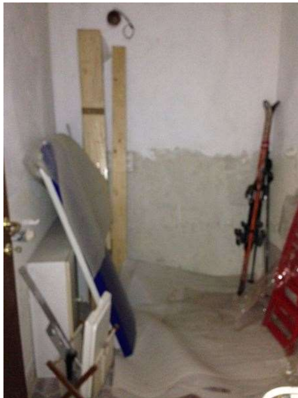
Foto n°46: LOCALE CON PREDISPOSIZIONE PER BAGNO
