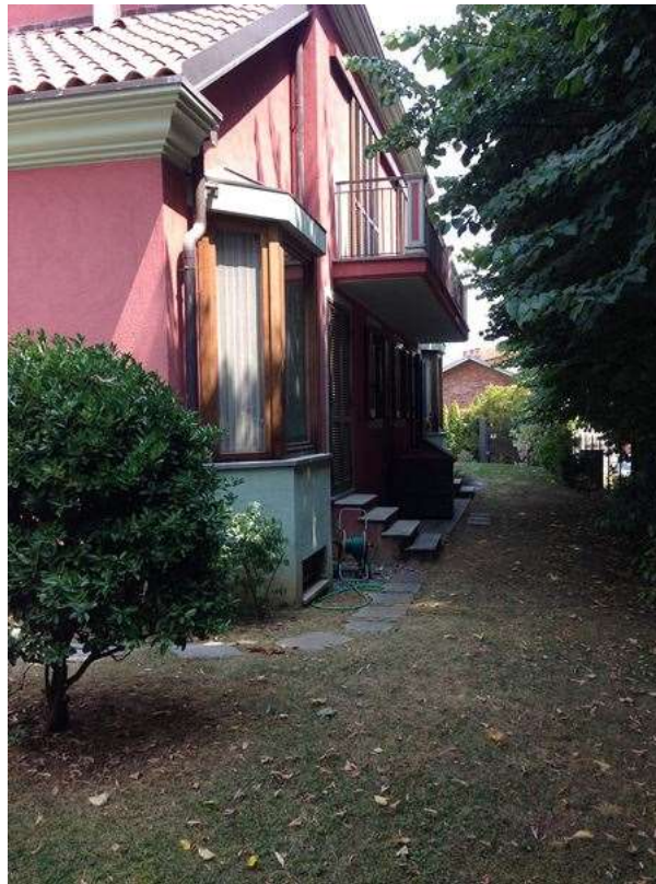
Foto n°16: VISTA DELL'IMMOBILE DALL'ESTERNO – SUD
