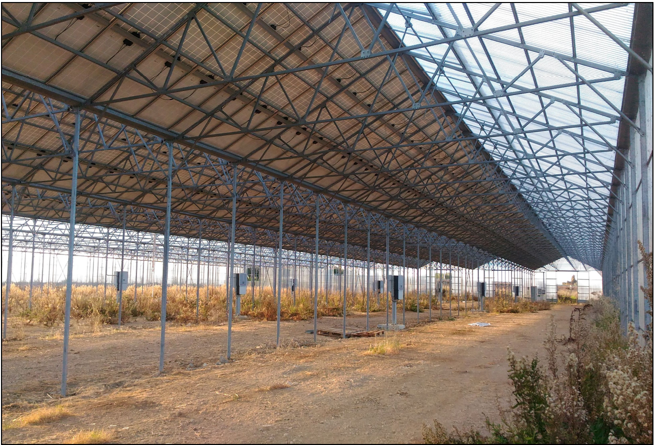
Vista interna – Serra multi tunnel con sovrastante impianto fotovoltaico (FV)
