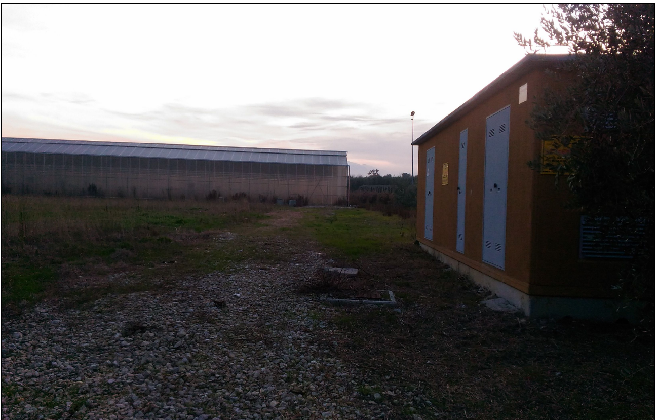
Vista esterna - Serra multi tunnel sullo sfondo e manufatto per locali tecnici sulla destra
