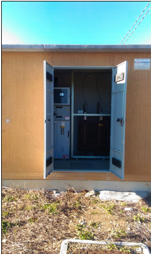
Vista esterna/interna – Box utente per gli Inverter e box per misure dell'impianto FV
