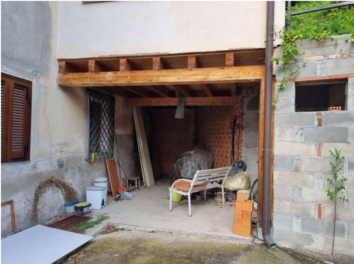
Vista passaggio coperto sotto ampliamento
