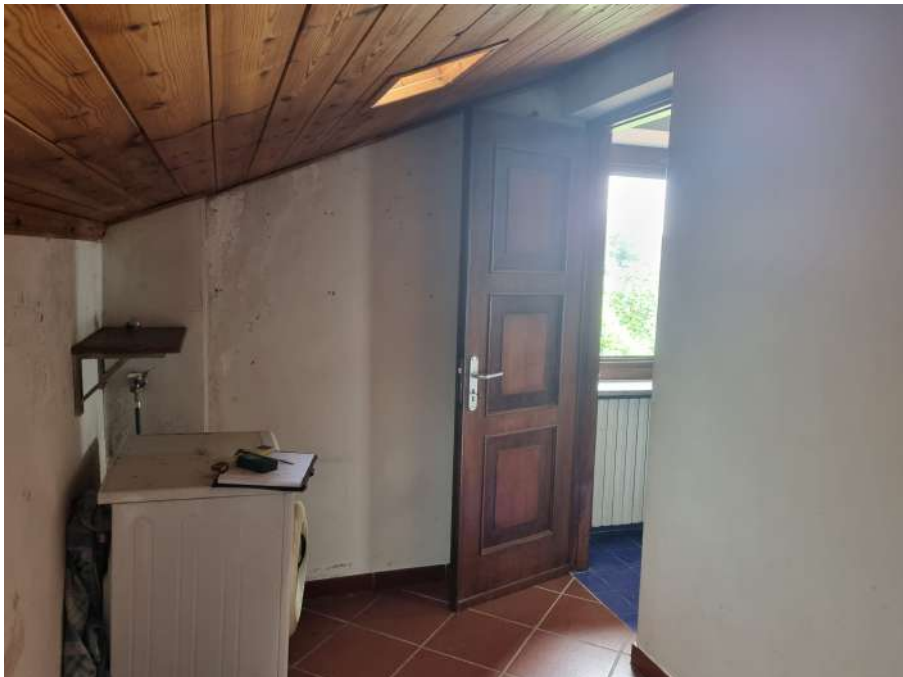
Ripostiglio piano secondo
