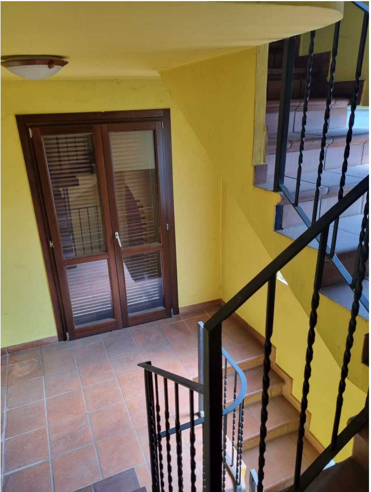
Vano scala piano primo
