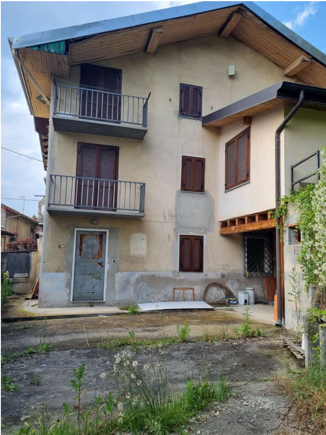
Prospetto da cortile
