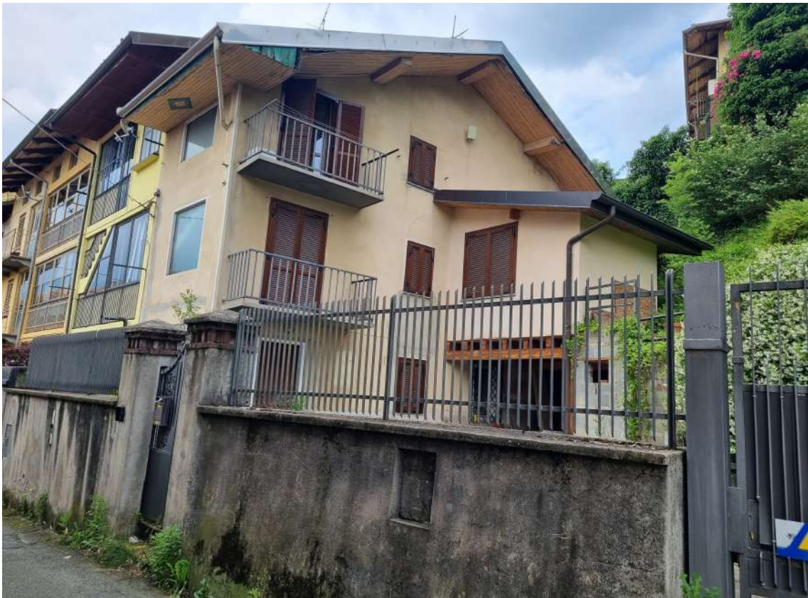
Facciata sud su via Maestra
