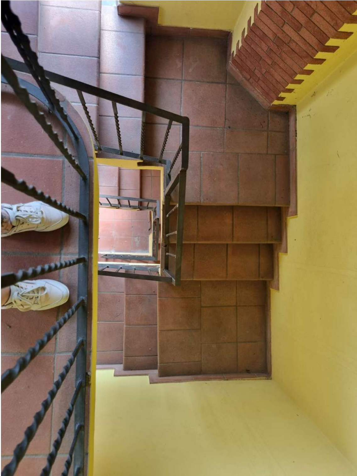
Vista dall'alto vano scala
