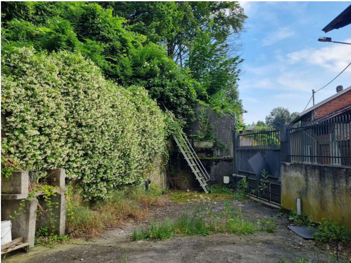
Vista cortile con scala accesso terrazzo
