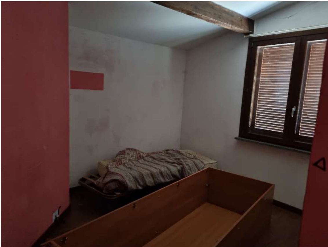
Camera al piano primo
