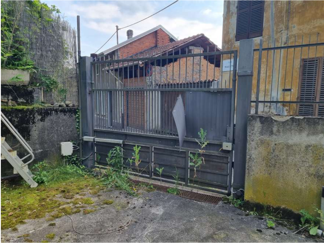
Vista interna accesso carraio
