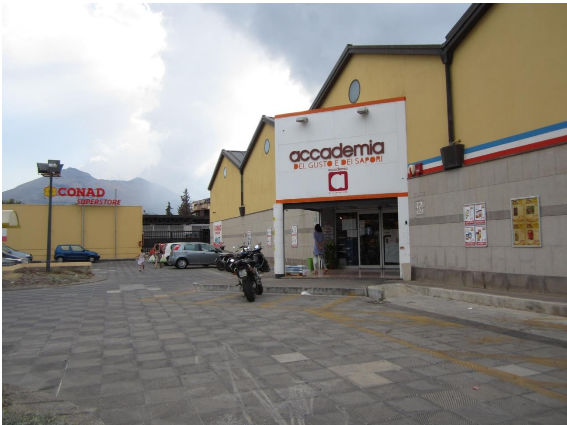
Foto 52: l'ingresso principale all'immobile denominato "Accademia"
