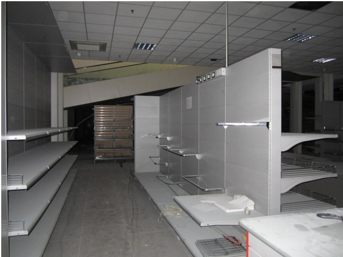
Foto 45: altra panoramica del piano cantinato
