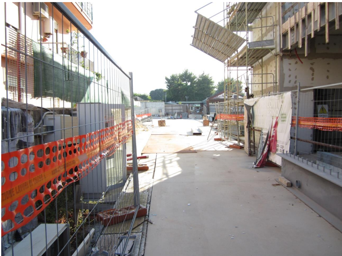
Foto 78: il varco, individuato dal civico 74/c della via Buzzanca, dal quale si accede al parcheggio a raso del multipiano parzialmente realizzato, attraversato il quale si raggiungono gli immobili che costituiscono il complesso denominato "Arredo & Verde"
