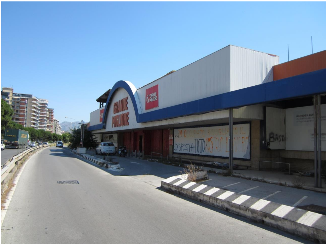
Foto 4: inquadratura, dal Viale Regione Siciliana, nella direzione di Messina/Catania, dell'immobile denominato "Grande Migliore", individuato toponomasticamente dal civico 4452 del Viale Regione Siciliana e catastalmente, nel foglio 39 di Palermo, dalla particella 1015 sub. 5
