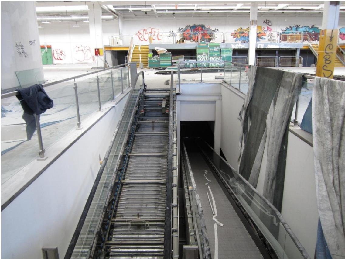
Foto 15: particolare del tappeto mobile di collegamento al piano cantinato, realizzato nella zona centrale dell'area di vendita
