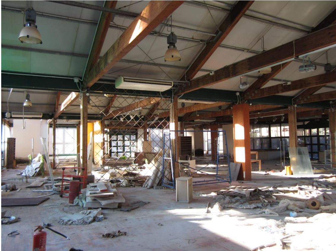
Foto 95: altra inquadratura dell'interno dei prefabbricati in struttura lamellare, destinati alla "esposizione", indicati con il n. 1 nella planimetria catastale
