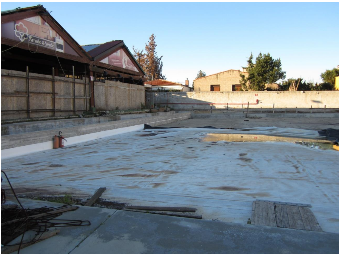
Foto 102: inquadratura, verso nord-ovest, del parcheggio a raso del multipiano parzialmente realizzato
