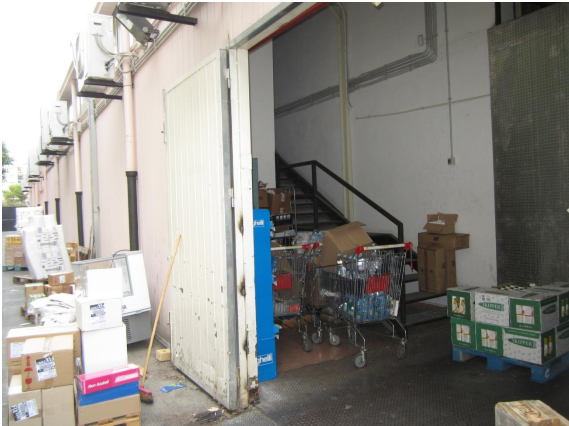
Foto 67: la scala che conduce al livello "ammezzato", destinato a "deposito"
