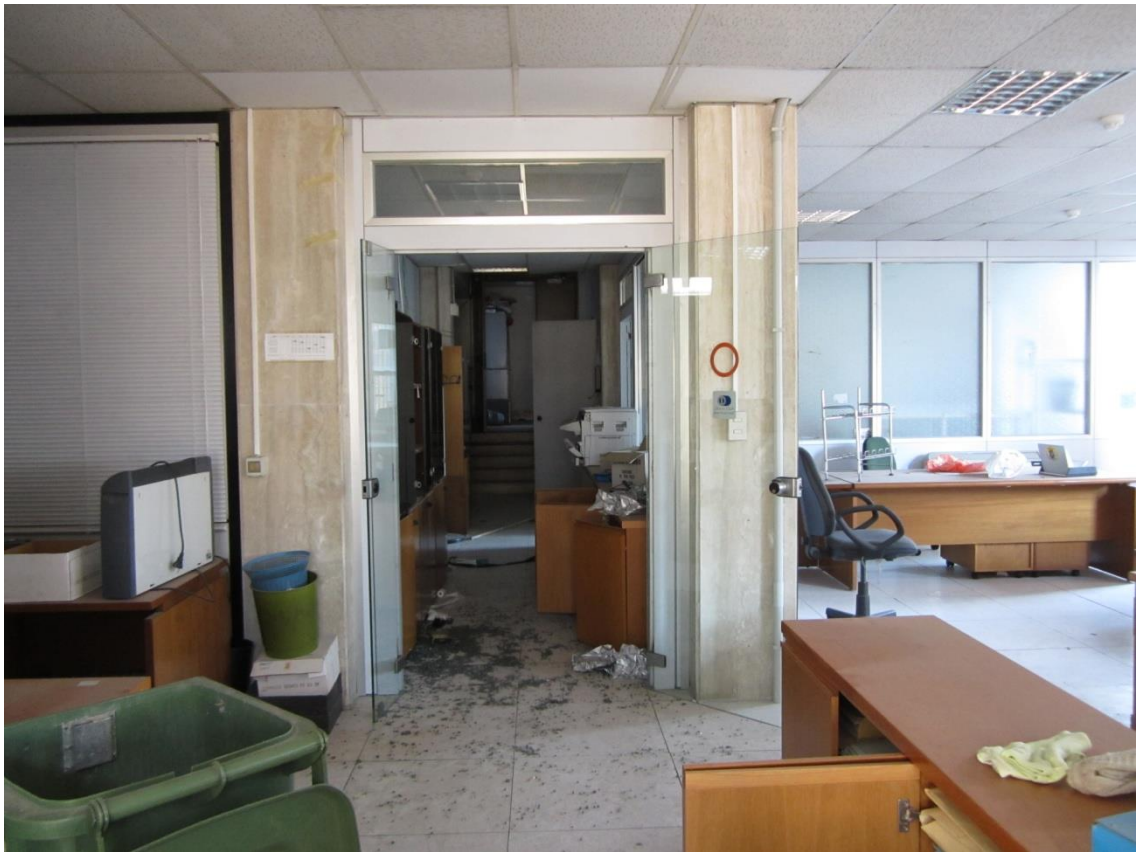
Foto 41: altro locale ricavato nell'area di servizio, a sud-est del piano cantinato
