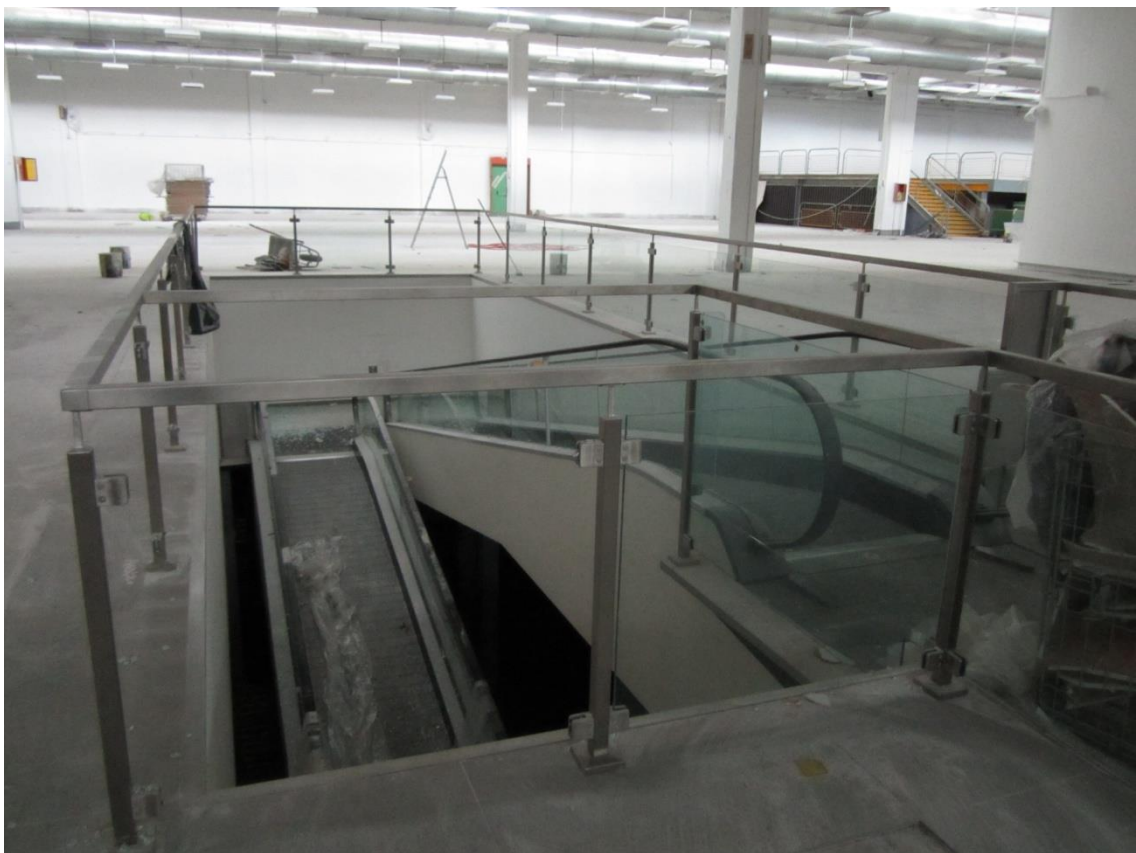
Foto 14: inquadratura del tappeto mobile di collegamento al piano cantinato, realizzato nella zona centrale dell'area di vendita
