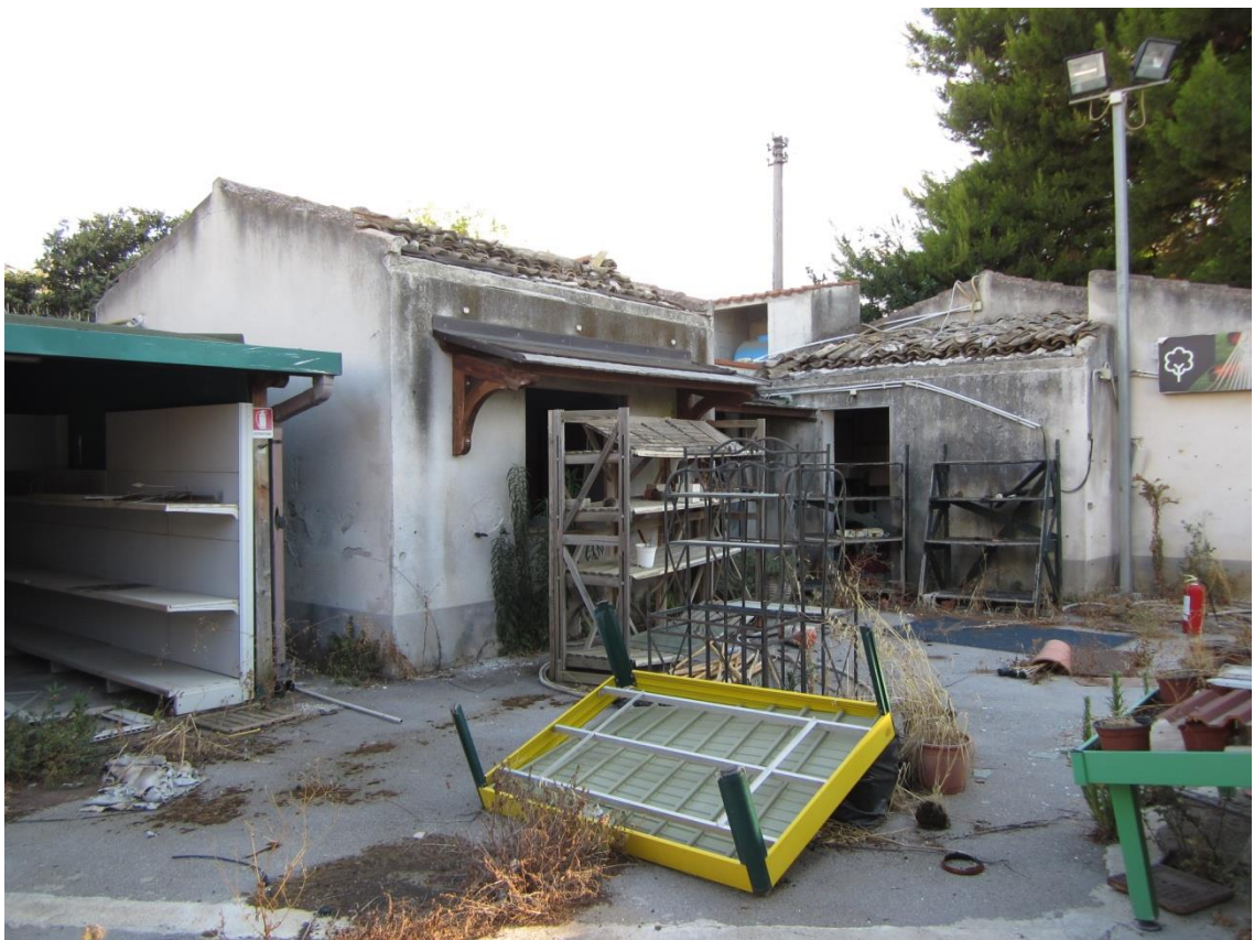
Foto 82: i manufatti in muratura, indicati nella planimetria catastale con i numeri 3 e 4, che ospitano i servizi, i magazzini e gli uffici del complesso denominato "Arredo & Verde"
