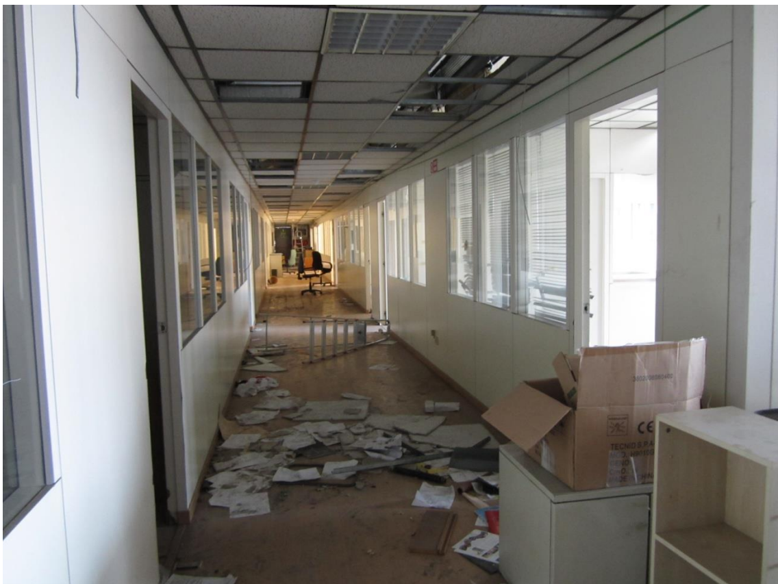
Foto 32: altra panoramica della batteria di uffici, disimpegnati da un corridoio centrale, ricavati nel soppalco
