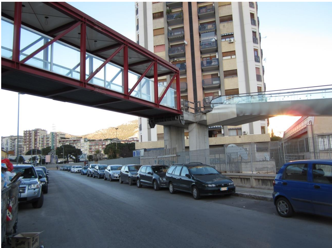
Foto 112: il nodo di attestamento tra la pensilina proveniente dal parcheggio e il sistema di tappeti mobili che sbarcano alla quota del piano terra della struttura "Grande Migliore"
