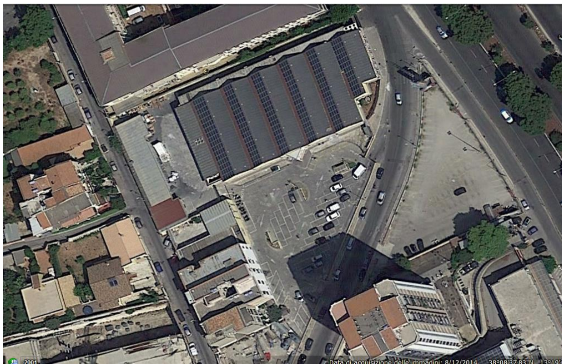
Foto 47: vista, dall'alto, dell'immobile denominato "Accademia", individuato toponomasticamente dai civici 38 e 40 della via Emanuele Mandalà Olivieri e catastalmente, nel foglio 39 di Palermo, dalla particella 1005 sub. 1
