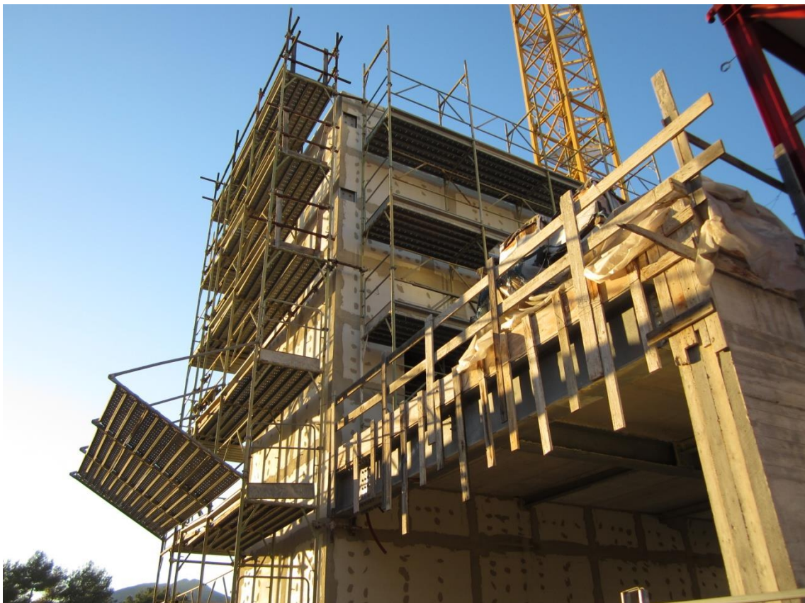
Foto 110: la struttura, che spicca dal parcheggio a raso, dalla quale si diparte la pensilina che attraversa la via Buzzanca e la via Emanuele Mandalà Oliveri, che prosegue con tappeti mobili che sbarcano alla quota del piano terra della struttura "Grande Migliore"
