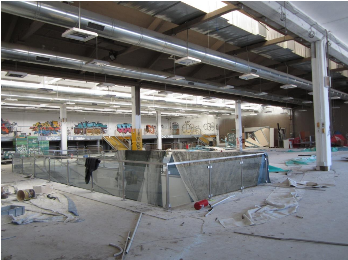
Foto 13: la zona centrale dell'area di vendita, nella quale sono stati realizzati i tappeti mobili di collegamento al piano cantinato
