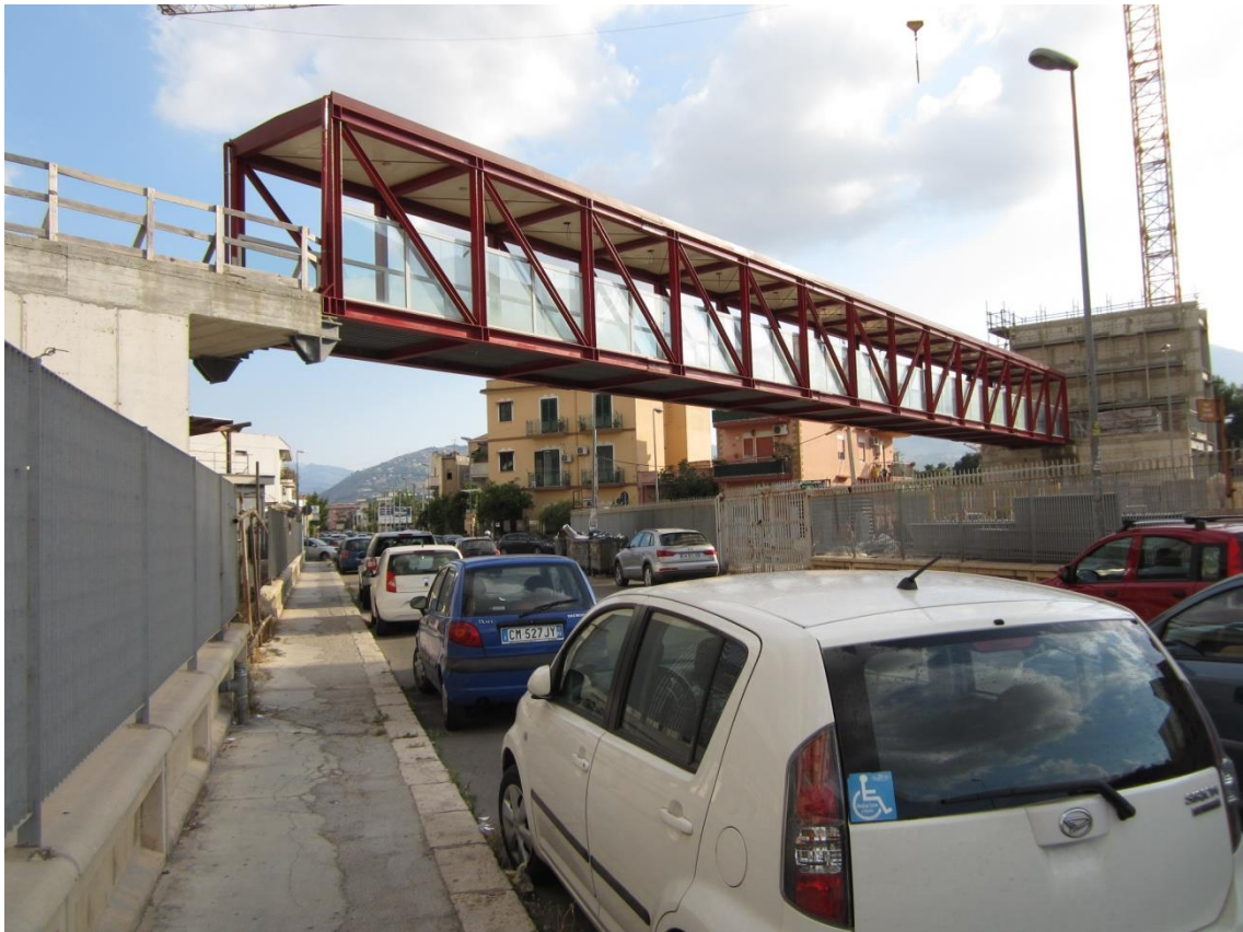
Foto 111: l'attraversamento, della pensilina, della via Emanuele Mandalà Oliveri
