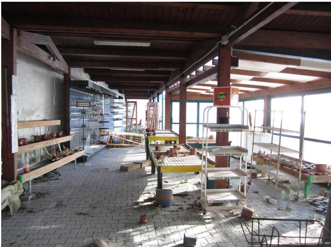
Foto 88: altra inquadratura della "fettoia" lungo il confine ovest, indicata con il n. 5 nella planimetria catastale; sul lato destro della foto una porzione di fettoia, chiusa perimetralmente con una struttura in metallo e vetro, non rappresentata né catastalmente né nei grafici della concessione in sanatoria
