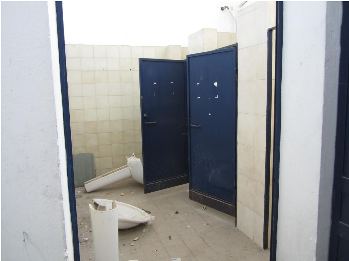
Foto 19: particolare dei servizi afferenti l'area destinata a deposito
