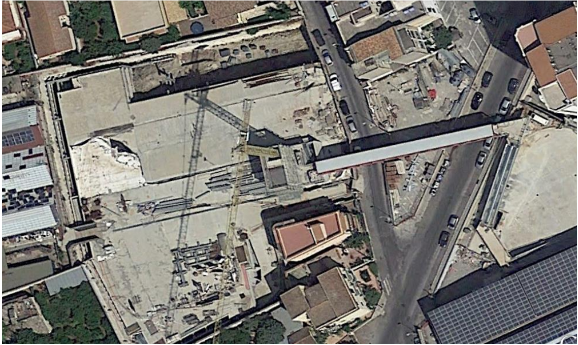
Foto 99: vista, dall'alto, del parcheggio interrato multipiano, di proprietà della Migliore Parcheggi e Servizi S.r.l., parzialmente realizzato, insistente sull'area identificata catastalmente, nel foglio 39 di Palermo, dalla particella 3700 sub. 3, cui si accede dal civico 74/c della via Buzzanca, e del sistema di passerelle aeree, e tappeti mobili, parzialmente realizzate, per il collegamento tra il parcheggio e la struttura denominata "Grande Migliore"
