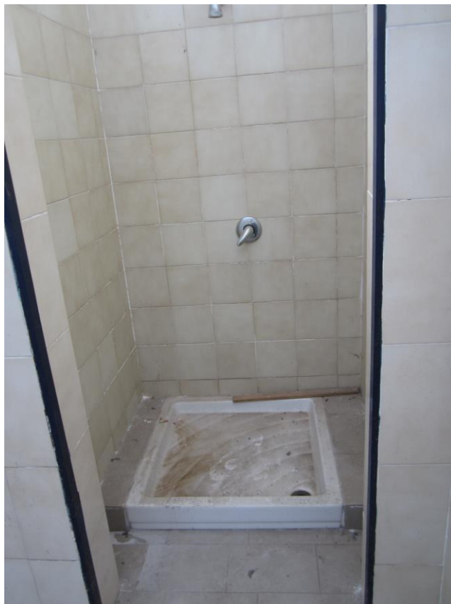
Foto 20: altro particolare dei servizi afferenti l'area destinata a deposito
