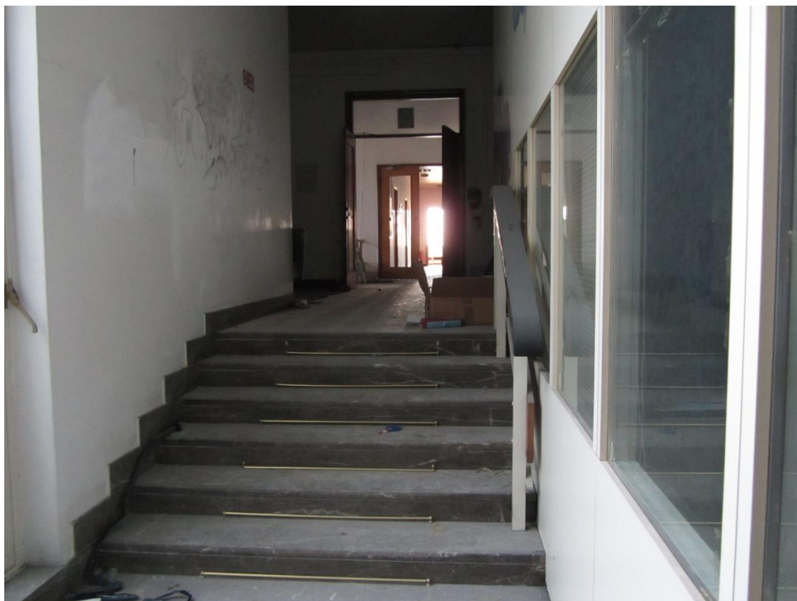
Foto 29: la scale, a destra dell'area ingresso, che conducono alla zona uffici e servizi
