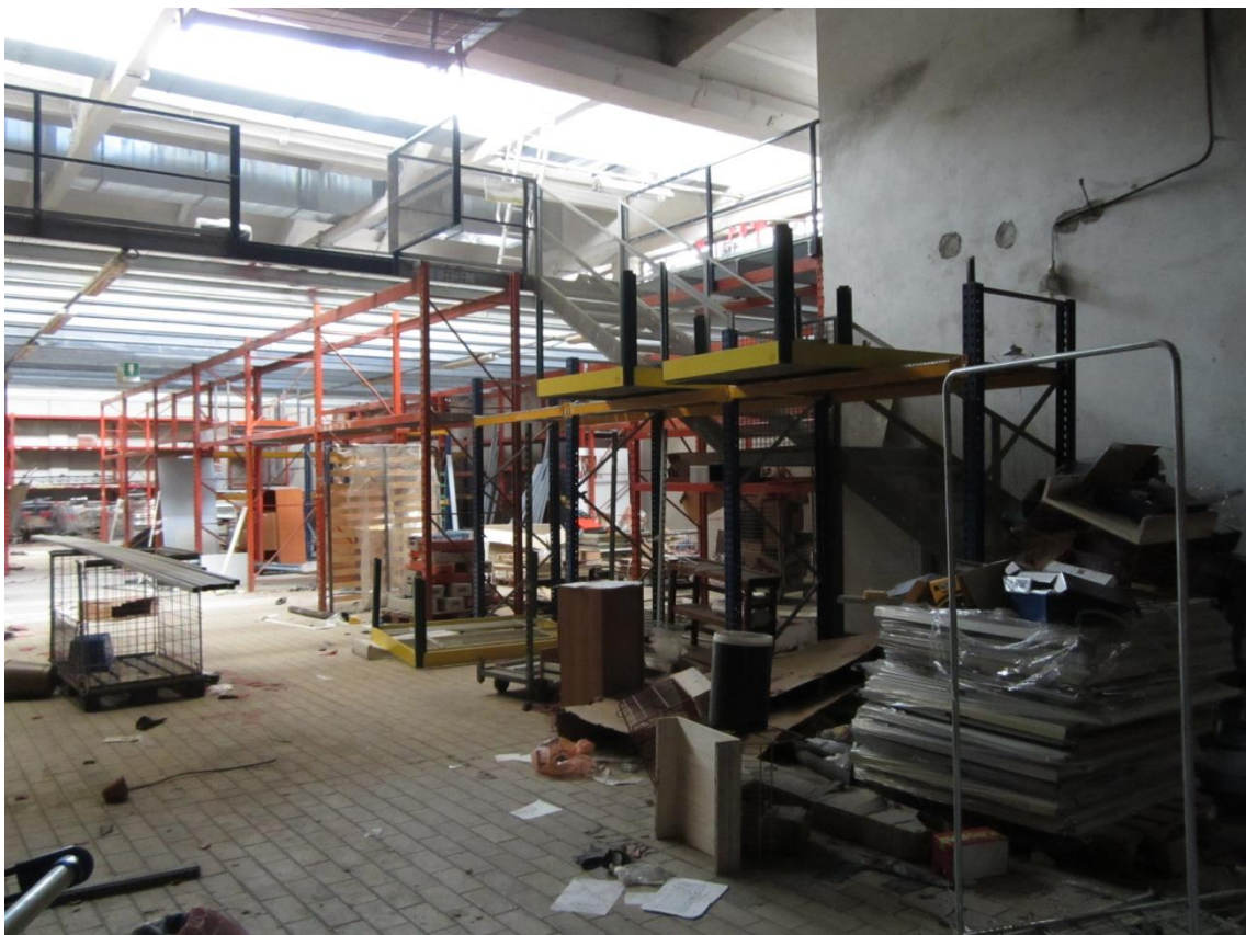
Foto 18: l'area destinata a deposito, che si trova nella porzione dell'immobile opposta all'ingresso; l'area è parzialmente soppalcata con una struttura non rappresentata catastalmente
