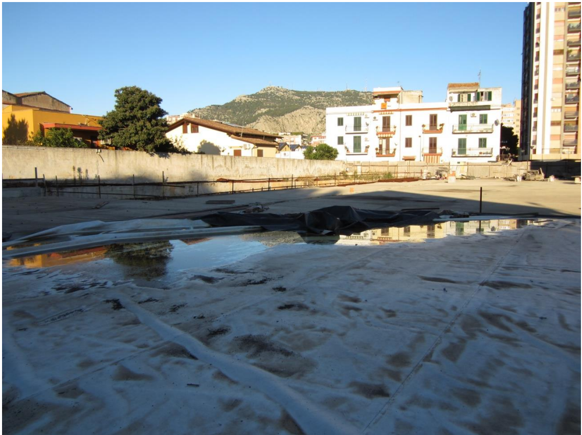
Foto 103: inquadratura, verso nord-est, del parcheggio a raso del multipiano parzialmente realizzato
