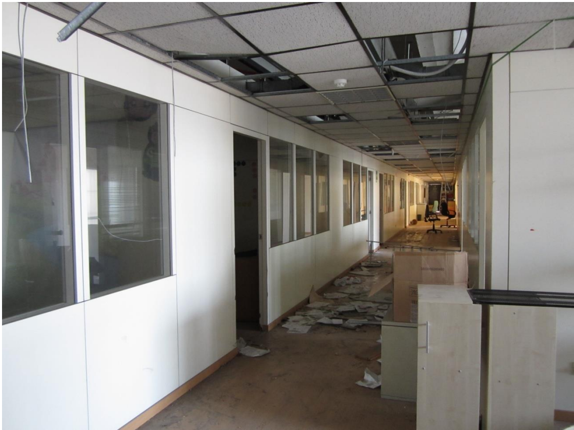
Foto 31: panoramica della batteria di uffici, disimpegnati da un corridoio centrale, ricavati nel soppalco, esteso oltre mq. 500
