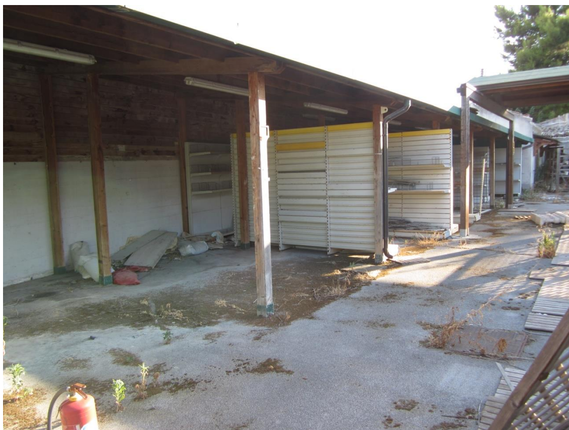
Foto 80: la "fettaia" lungo il confine sud, subito a sinistra entrando nell'area in cui insiste il complesso denominato "Arredo & Verde", indicata con il n. 6 nella planimetria catastale
