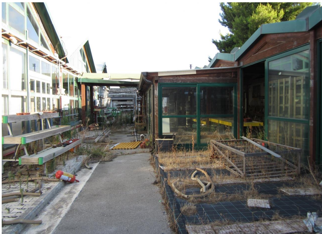
Foto 89: inquadratura, dal punto di vista opposto rispetto alla foto precedente, della "tettoia" lungo il confine ovest, indicata con il n. 5 nella planimetria catastale; al centro la porzione di tettoia, chiusa perimetralmente con una struttura in metallo e vetro, non rappresentata né catastalmente né nei grafici della concessione in sanatoria
