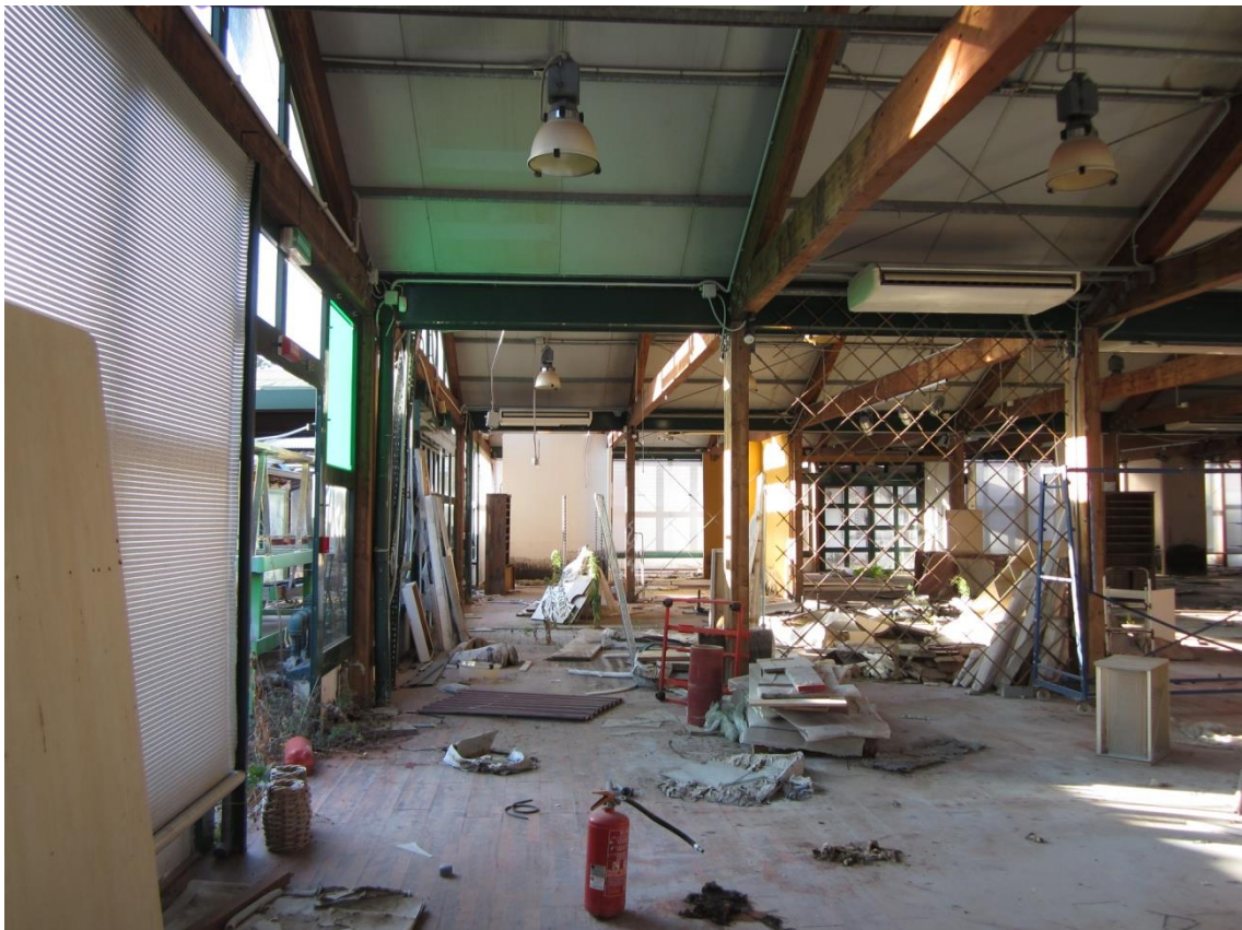
Foto 96: altra inquadratura dell'interno dei prefabbricati in struttura lamellare, destinati alla "esposizione", indicati con il n. 1 nella planimetria catastale
