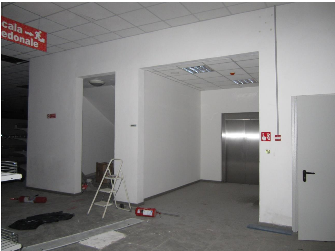
Foto 42: lo sbarco, al piano cantinato, della scala che collega verticalmente questo livello al soprastante piano terra
