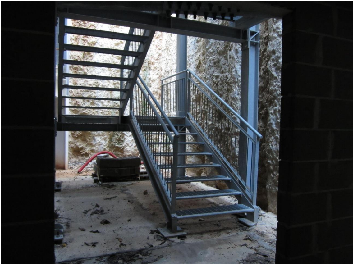
Foto 109: una delle scale metalliche che collegano verticalmente i tre livelli del multipiano
