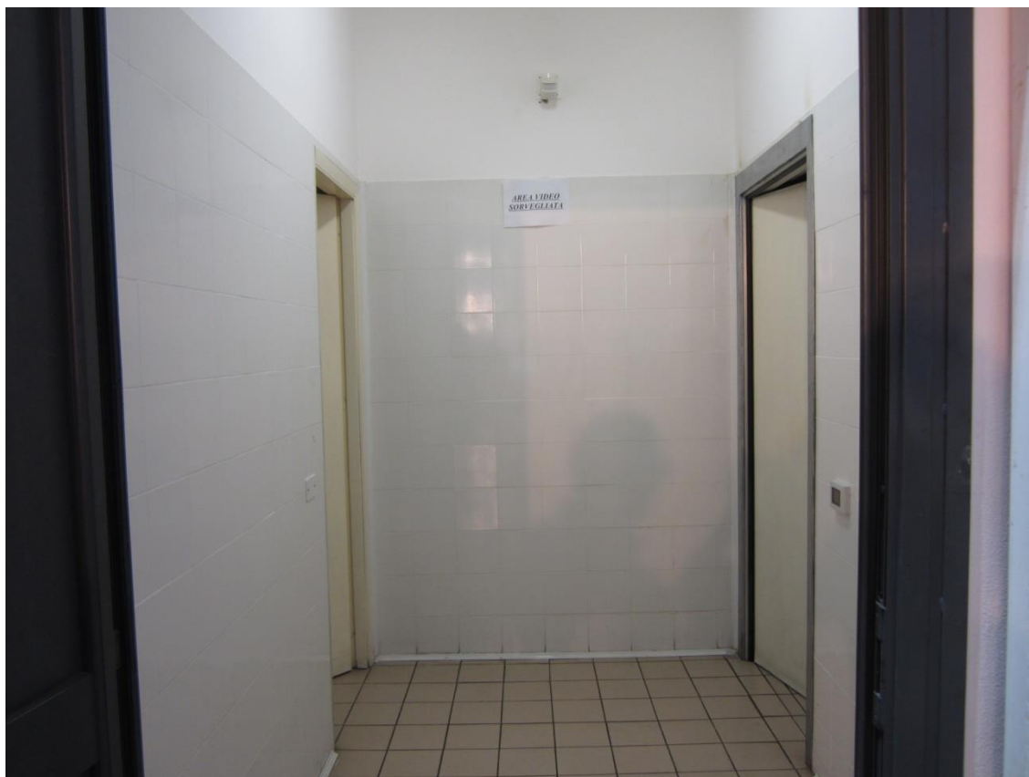
Foto 57: l'ingresso al blocco servizi del piano terra
