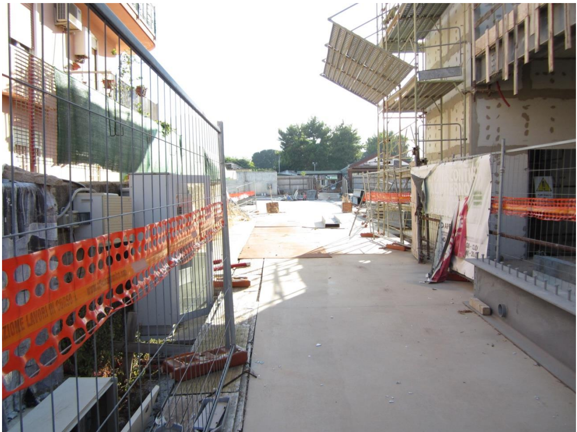
Foto 100: il civico 74/c della via Buzzanca, dal quale si accede al parcheggio a raso del multipiano parzialmente realizzato
