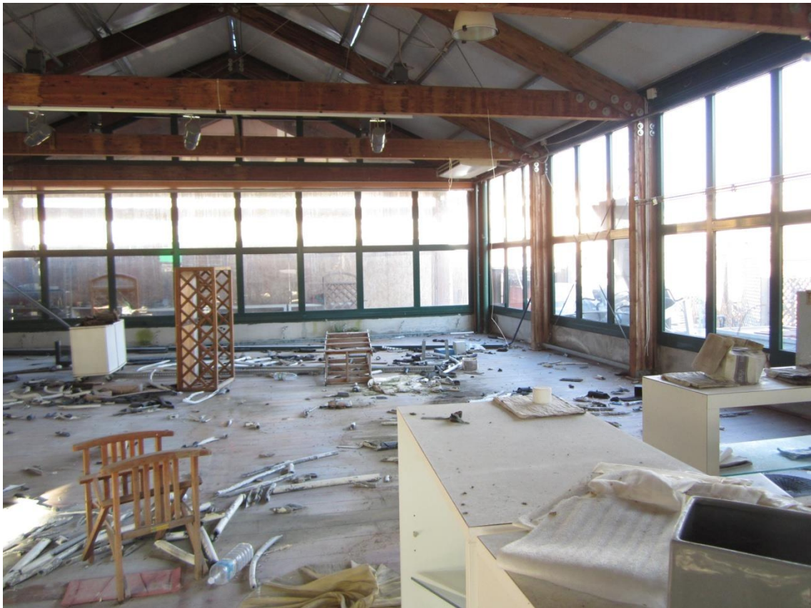
Foto 97: altra inquadratura dell'interno dei prefabbricati in struttura lamellare, destinati alla "esposizione", indicati con il n. 1 nella planimetria catastale
