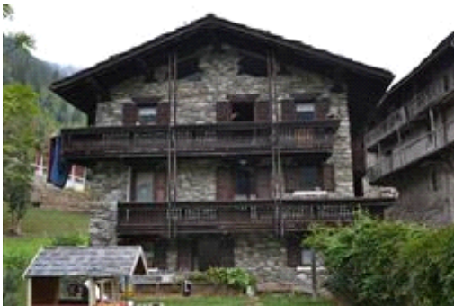
Facciata lato sud-ovest
