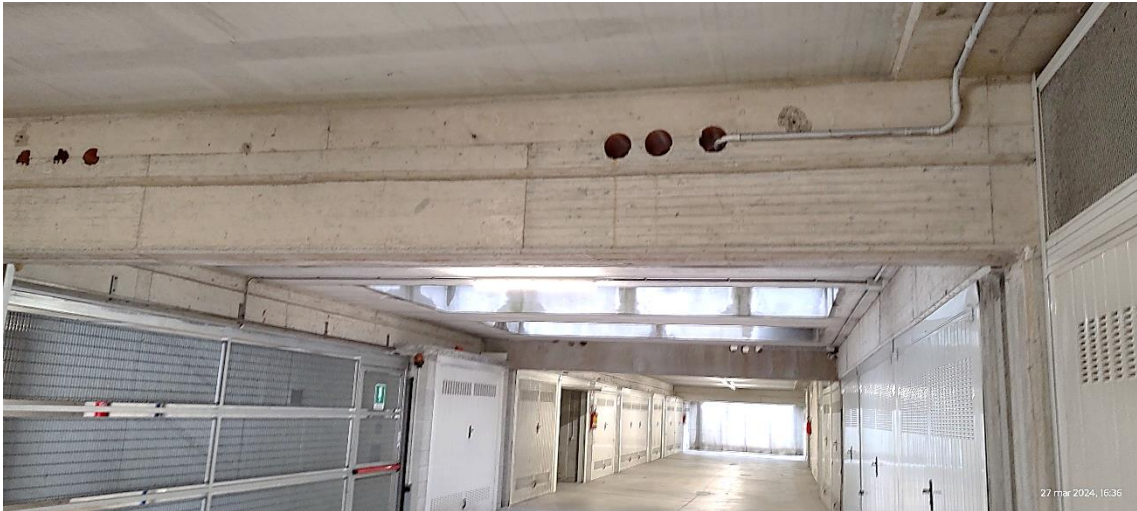
Veduta generale del corsello box
