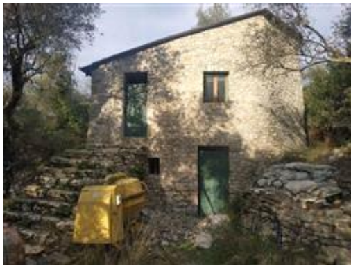
ESTERNO – vista ravvicinata del fabbricato dist. cat. Fig. 27 mapp. 496 (prospetti sud-ovest e sud-est); ripresa dalla corte esterna (graffata catastalmente al fabbricato); sulla sinistra è visibile il corpo scale in pietra a vista.
