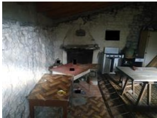
INTERNO – PIANO PRIMO (fabbricato dist. cat. Fig. 27 mapp. 496) - vista interna del LOCALE ABITATIVO ; sullo sfondo è visibile il camino domestico
