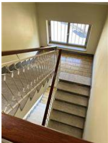
vista del vano scala
