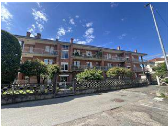
vista del prospetto nord del fabbricato
