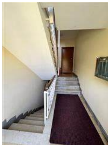
vista dell'ingresso al fabbricato
