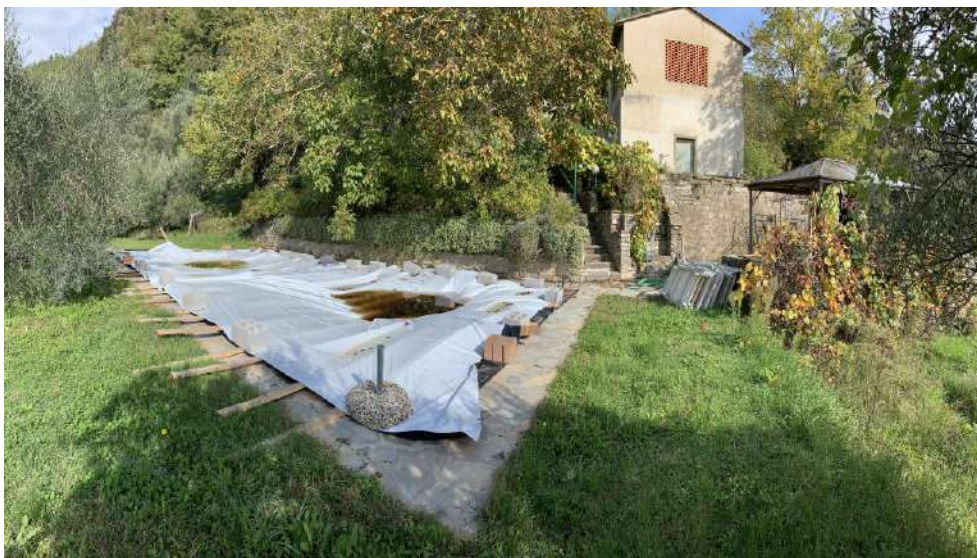
Foto n. 37 vista della piscina esterna “D”;
