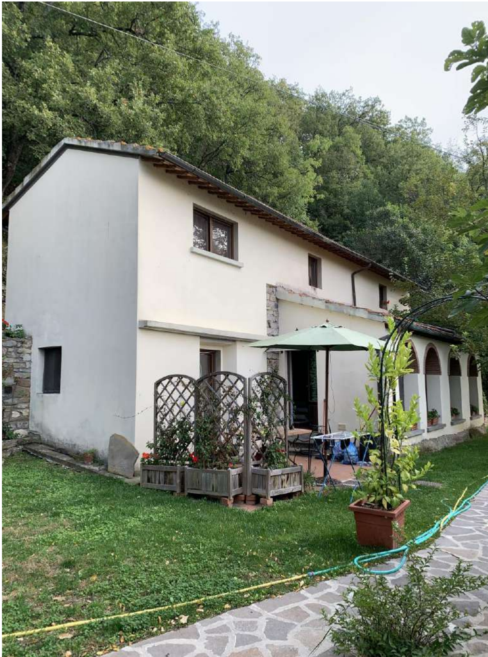
Foto n. 9 vista esterna del fabbricato “B” con accesso all’U.I. “B2”;
