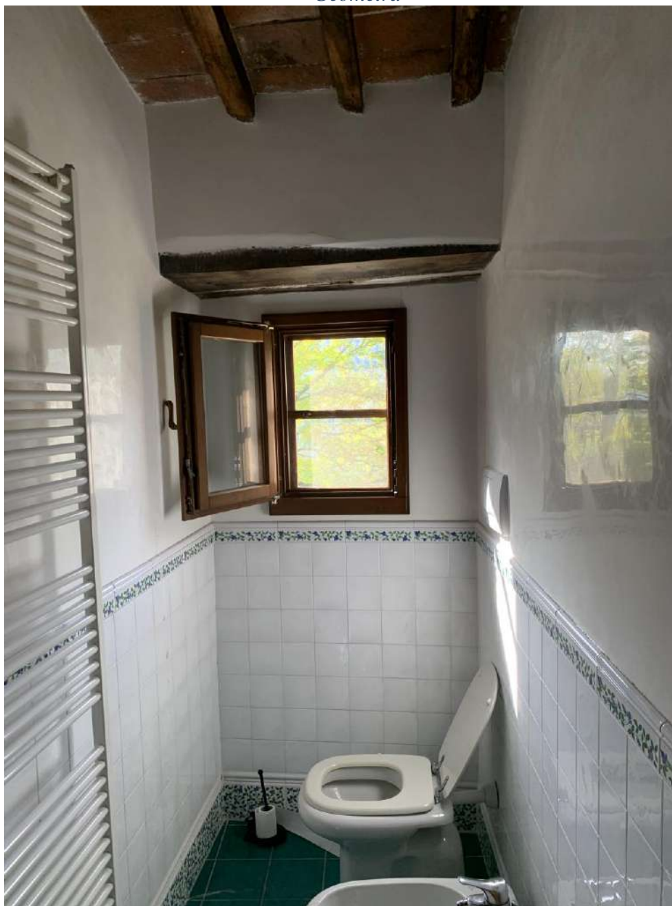
Foto n. 25 vista del wc in camera matrimoniale, dell'U.I. "A1";
