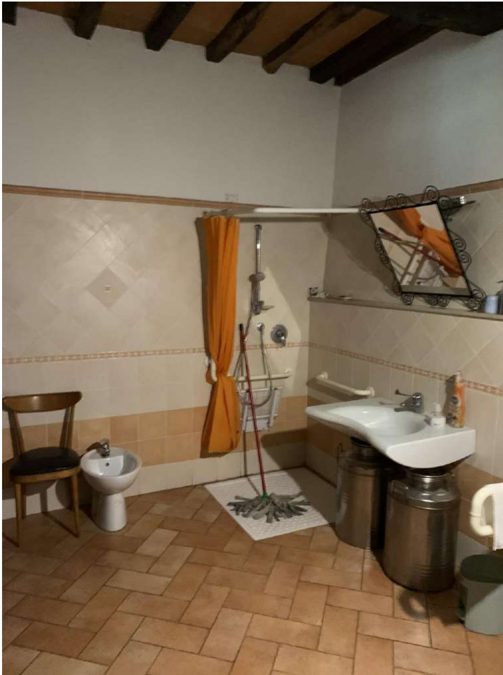
Foto n. 32 vista del bagno, dell'U.I. "A2"
