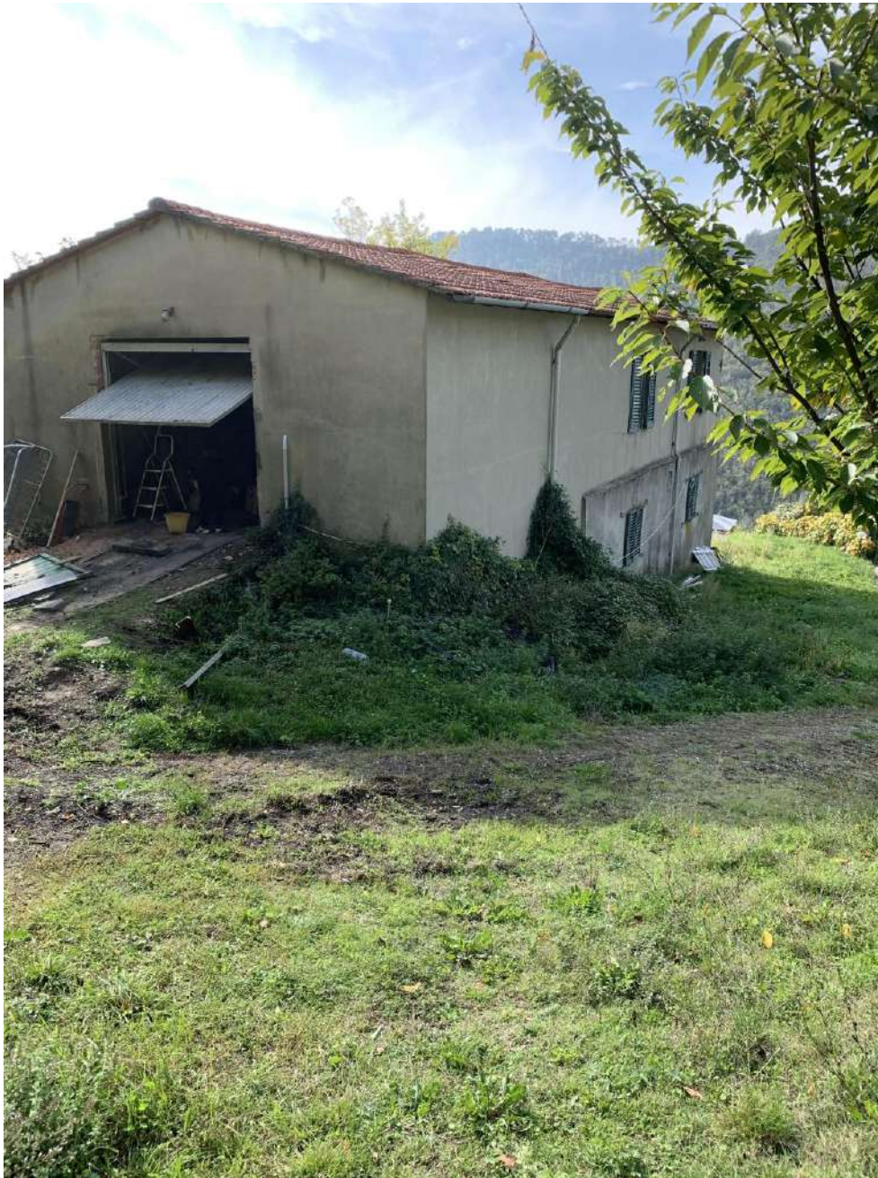
Foto n. 34 vista esterna del fabbricato "C" ;
