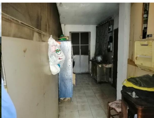
Vista Interna Deposito Dep 1 – Piano Terra
