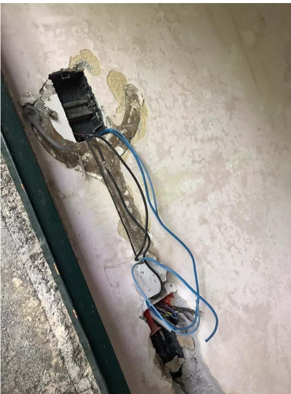
Foto 7 e foto 8 – impianto elettrico deteriorato e umidità sui muri interni
