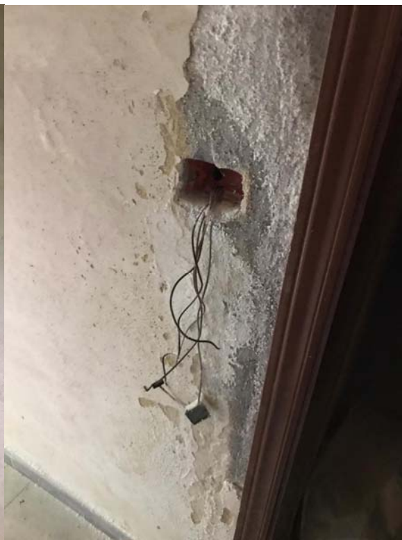
Foto 7 e foto 8 – impianto elettrico deteriorato e umidità sui muri interni
