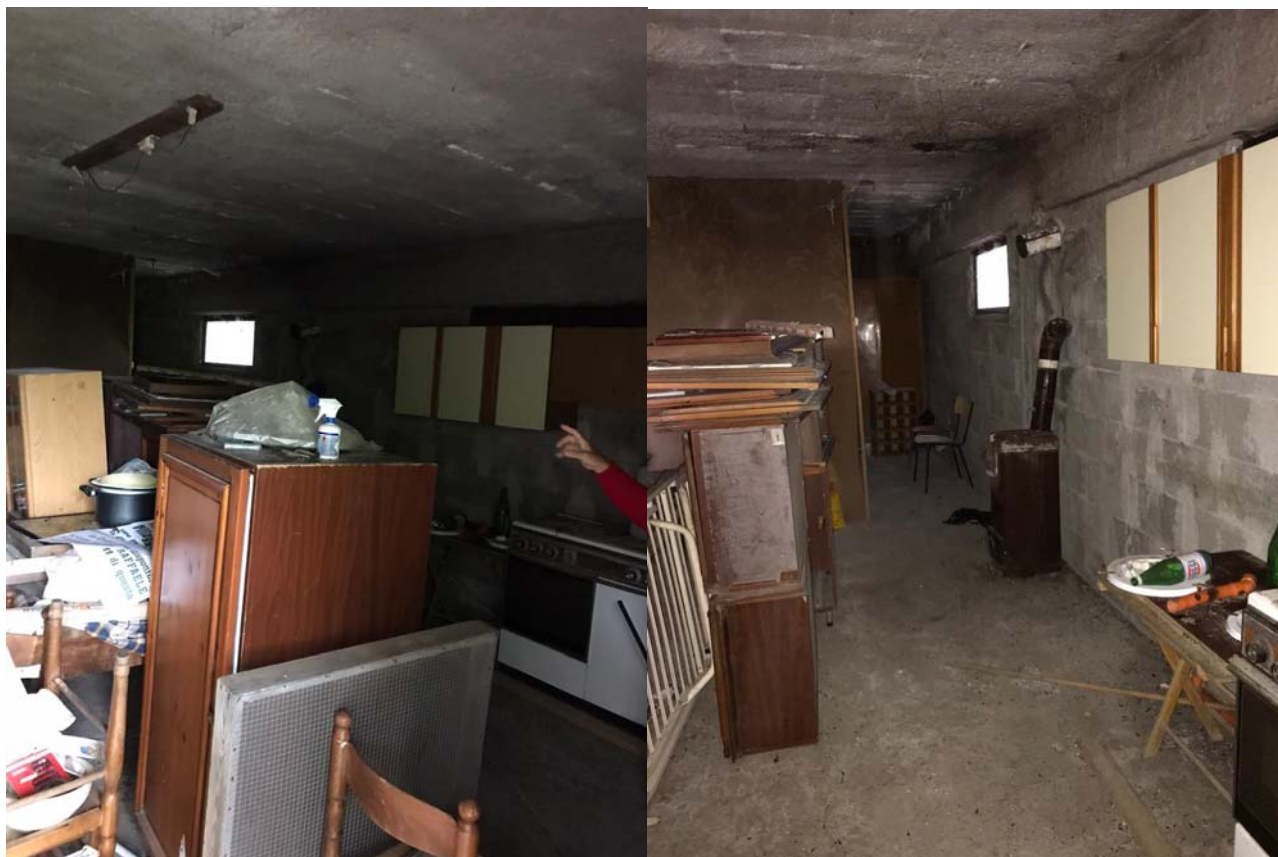
Foto n° 12 e Foto n° 13 – interno del piano cantinato non rifinito.
