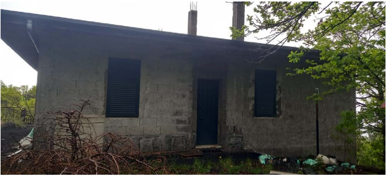
Foto n° 3 – foto della facciata principale d'ingresso prospiciente il cancello di accesso.
