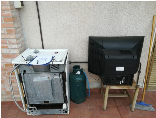
POSIZIONAMENTO BOMBOLA GAS (BALCONE)
