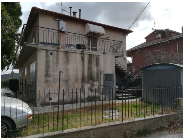
VISTA DA VIA MOLINO VECCHIO PRIVATA
