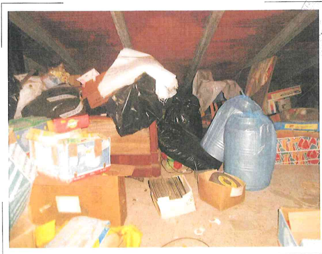
42) Particolare della superficie al piano secondo sottotetto adibita a soffitta
