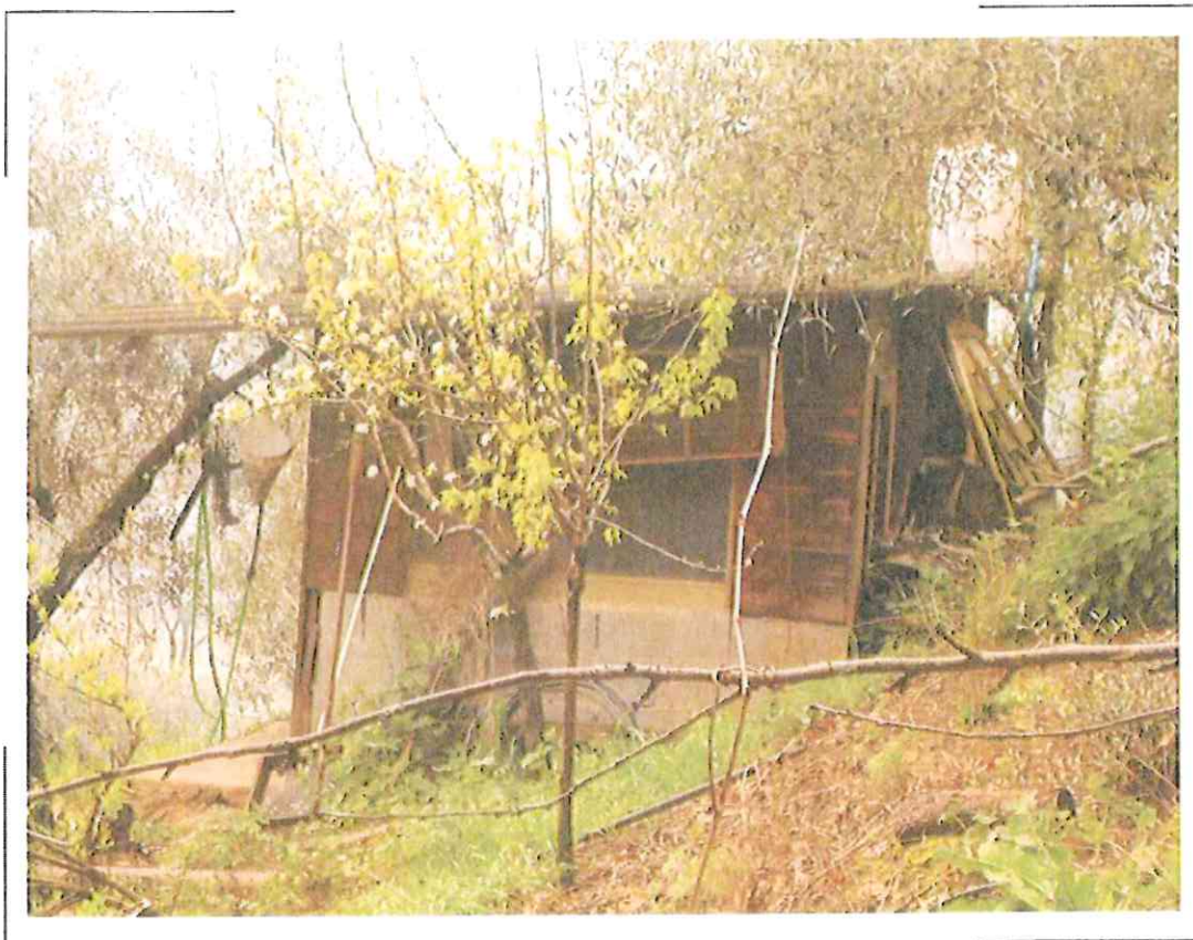
88) Particolare della fabbricato adibito a stalla/pollaio realizzato sulla corte esterna a servizio dei beni oggetto di stima identificata al NCEU al Fg.198 p.Ila 141
