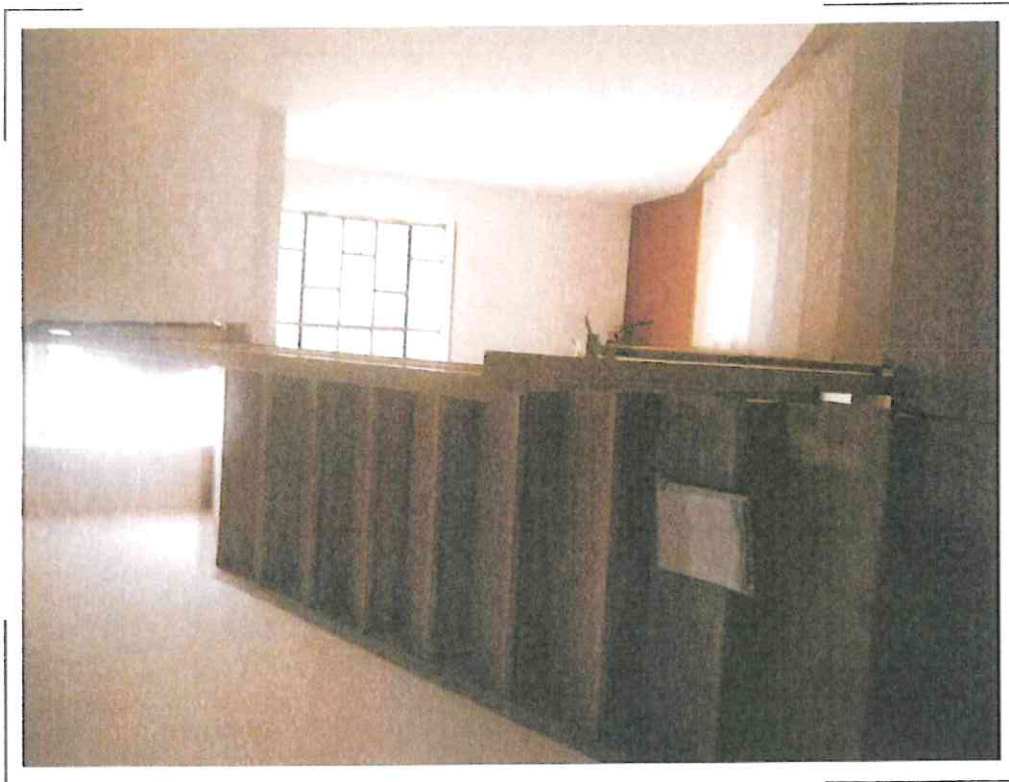
46) Particolare del vano scala che permette il raggiungimento della superficie ubicata al piano secondo sottotetto adibita a soffitta
