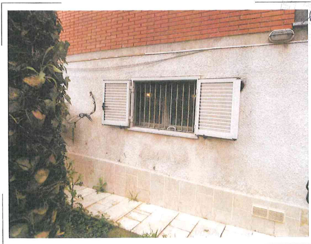
67) Particolare degli infissi esterni dei locali al piano terra
