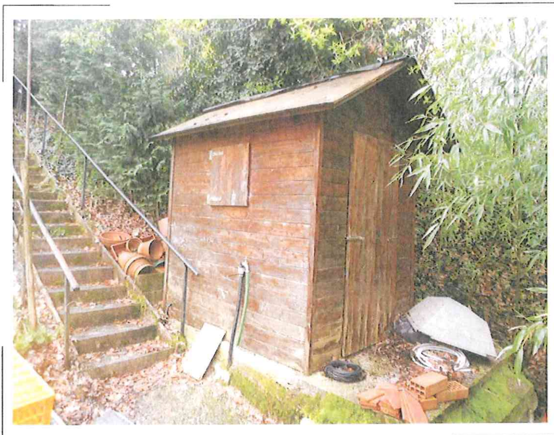
86) Particolare della casetta in legno realizzata sulla corte esterna a servizio dei beni oggetto di stima identificata al NCEU al Fg.198 p.Ila 141
