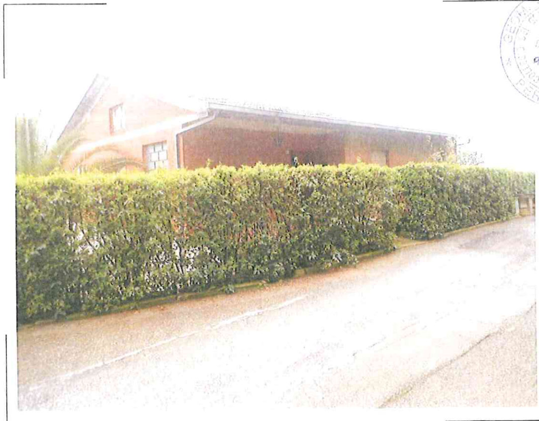
2) Vista generale del fabbricato oggetto di stima identificato al NCEU al Fg.97 p.IIa 143 che si affaccia sulla viabilità pubblica denominata strada Tiberina Nord
