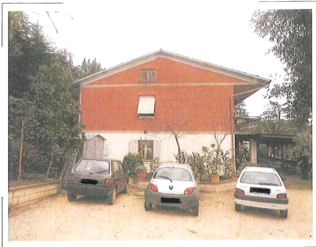
5) Vista generale del fabbricato oggetto di stima identificato al NCEU al Fg.97 p.lla 143
