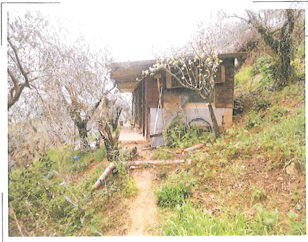
87) Particolare della fabbricato adibito a stalla/pollaio realizzato sulla corte esterna a servizio dei beni oggetto di stima identificata al NCEU al Fg.198 p.Ila 141
