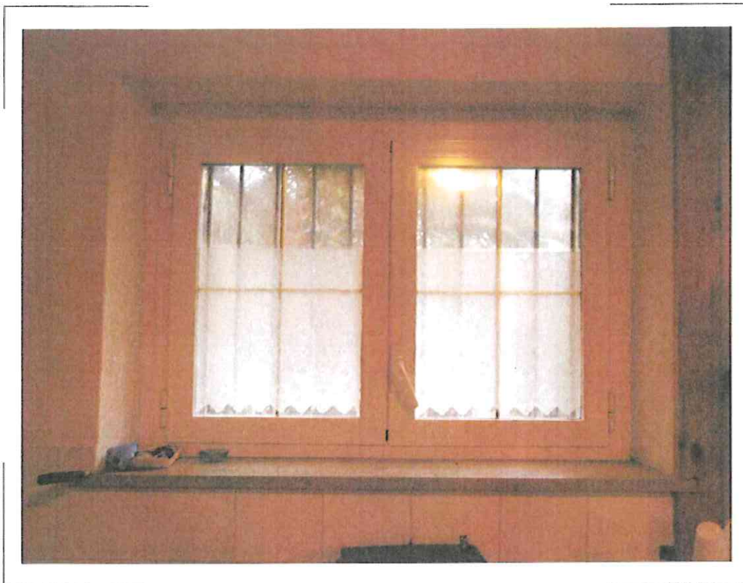
66) Particolare degli infissi esterni dei locali al piano terra
