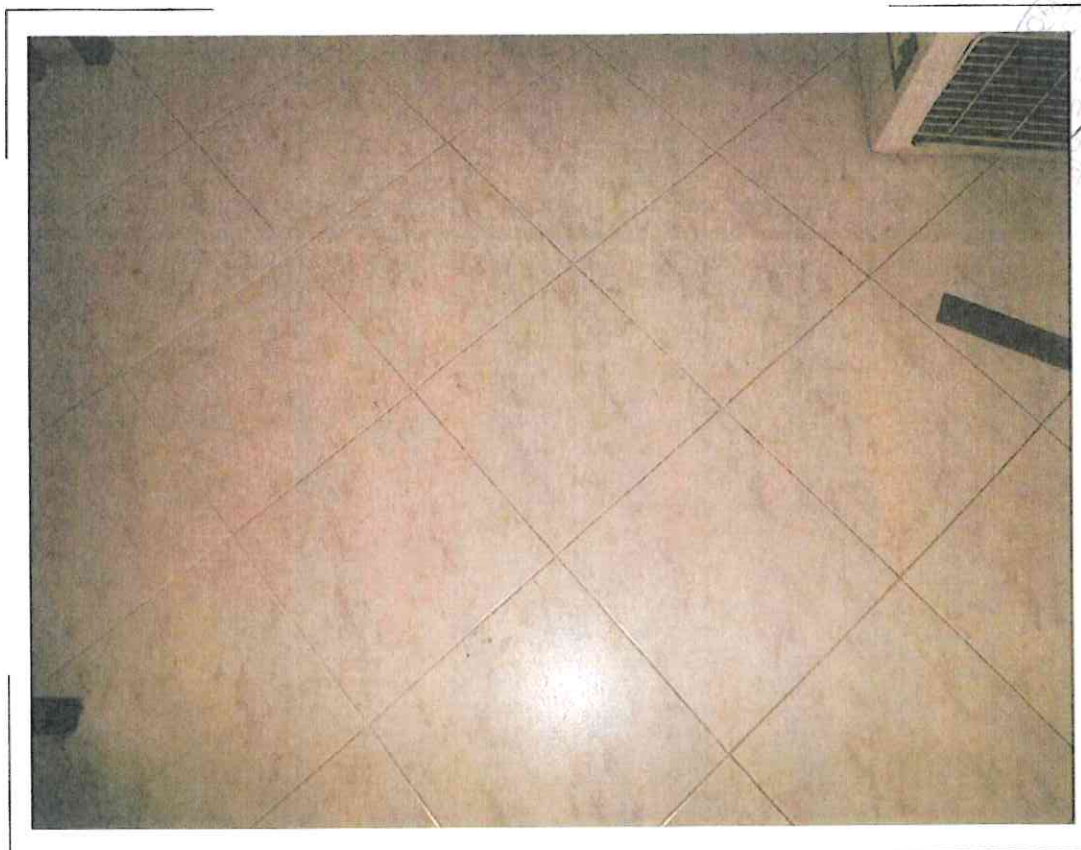
103) Particolare della pavimentazione all'interno del fabbricato adibito a rimessa attrezzi/fondo/magazzino
