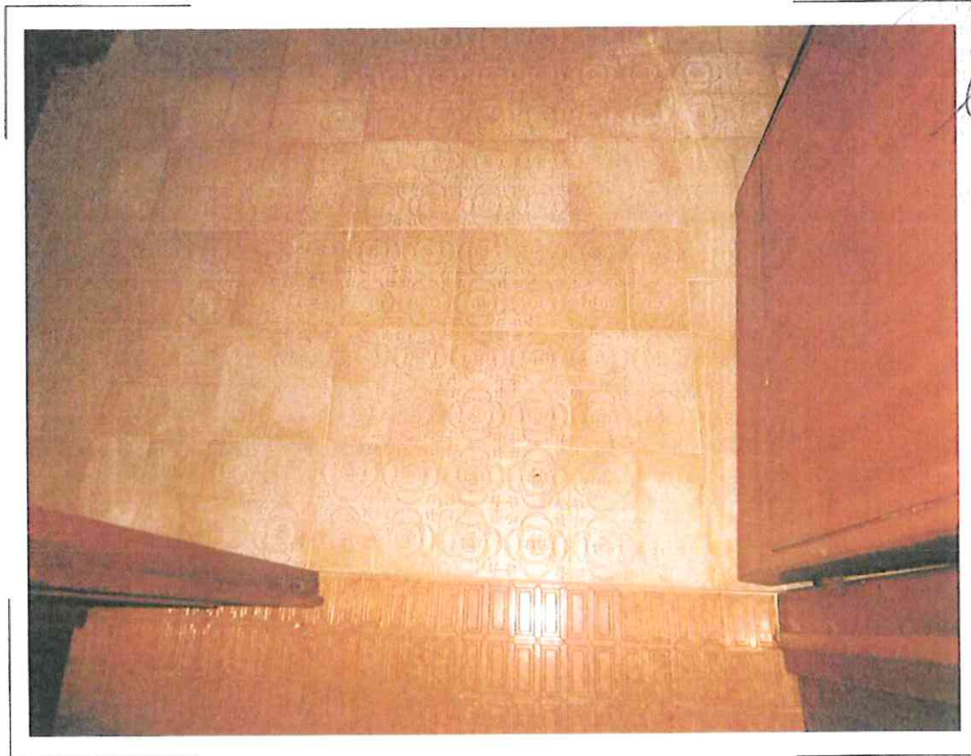
27) Particolare della pavimentazione del disimpegno della zona giorno e del reparto notte al piano primo
