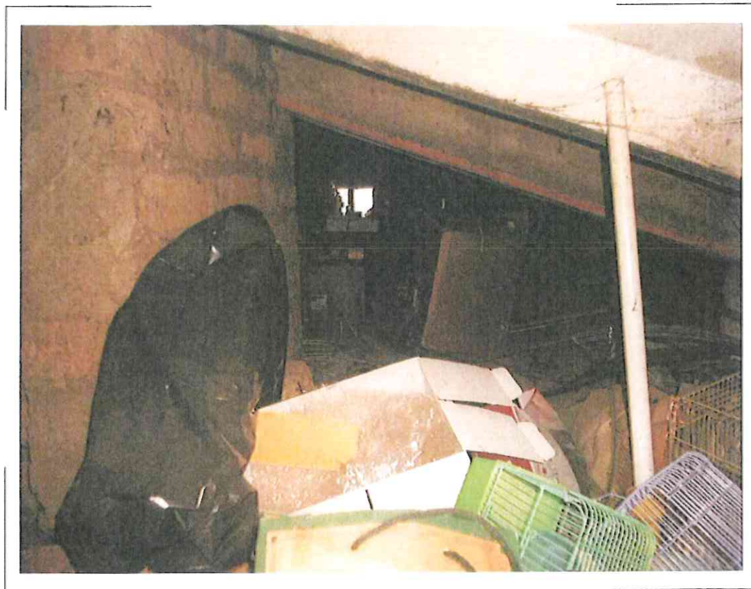
43) Particolare della superficie al piano secondo sottotetto adibita a soffitta
