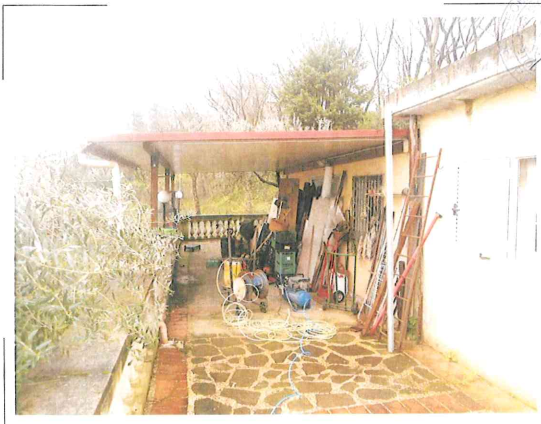
91) Particolare del fabbricato adibito a rimessa attrezzi/fondo/magazzino realizzato sulla corte esterna a servizio dei beni oggetto di stima identificata al NCEU al Fg.198 p.IIa 141
