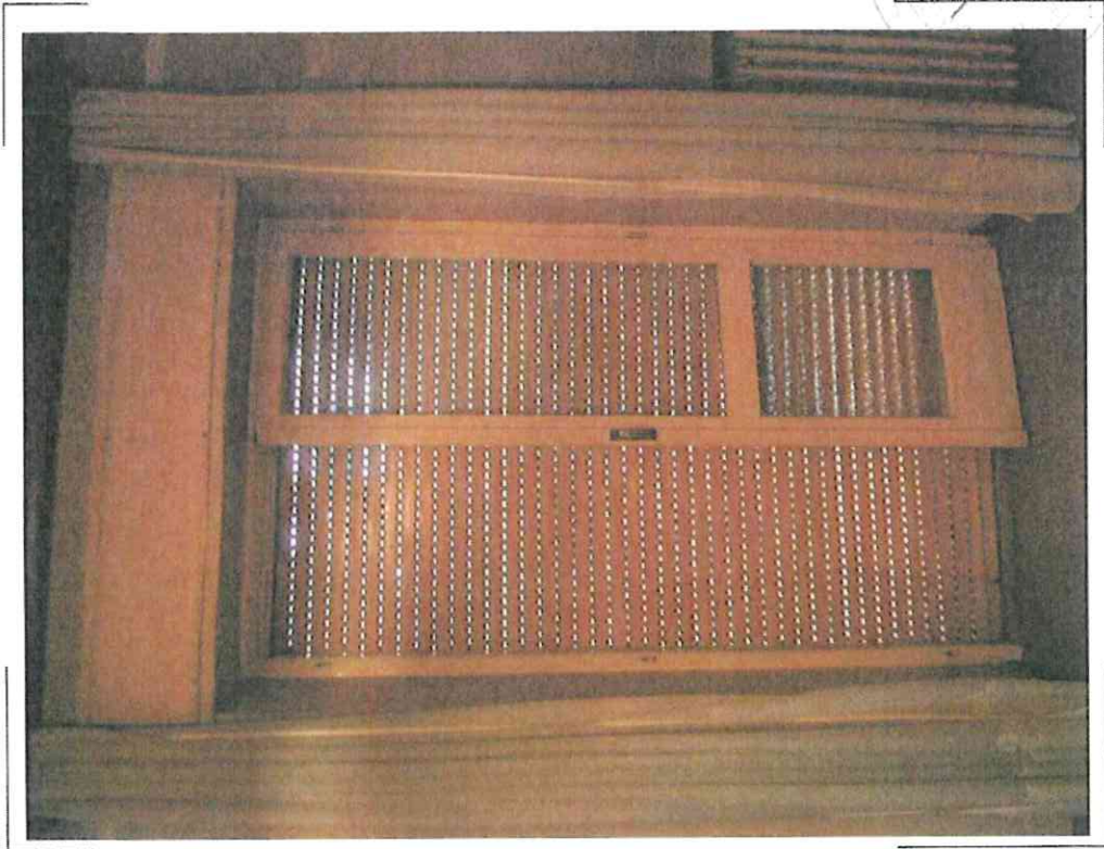
31) Particolare degli infissi esterni a servizio della porzione di abitazione al piano primo
