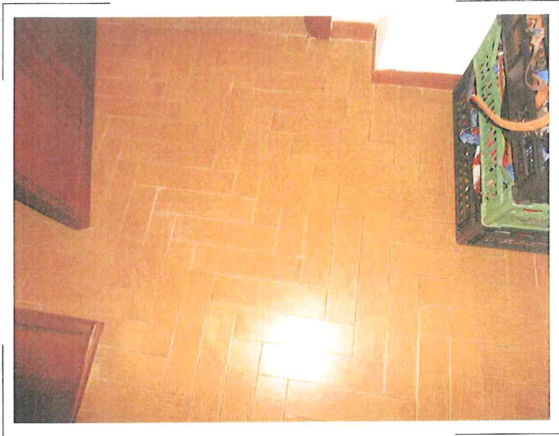
26) Particolare della pavimentazione delle camere da letto al piano primo
