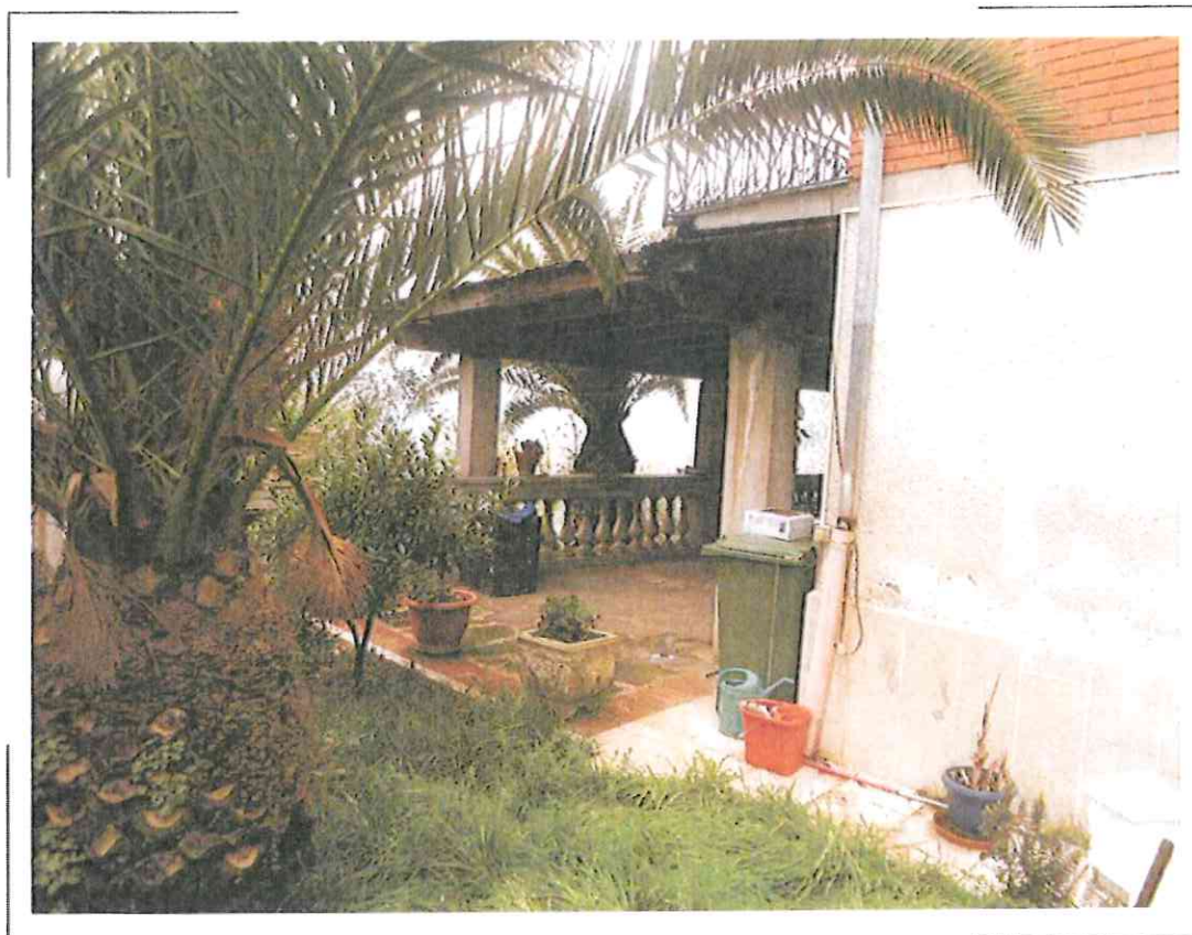
78) Particolare del portico in c.a. a servizio dei beni oggetto di stima censita al NCEU al Fg.198 p.lla 143 sub. 1 e 2
