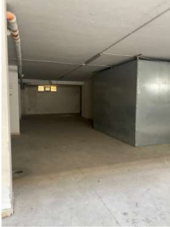
Foto n.64 F.2 P.Ila 1652 Sub.12
