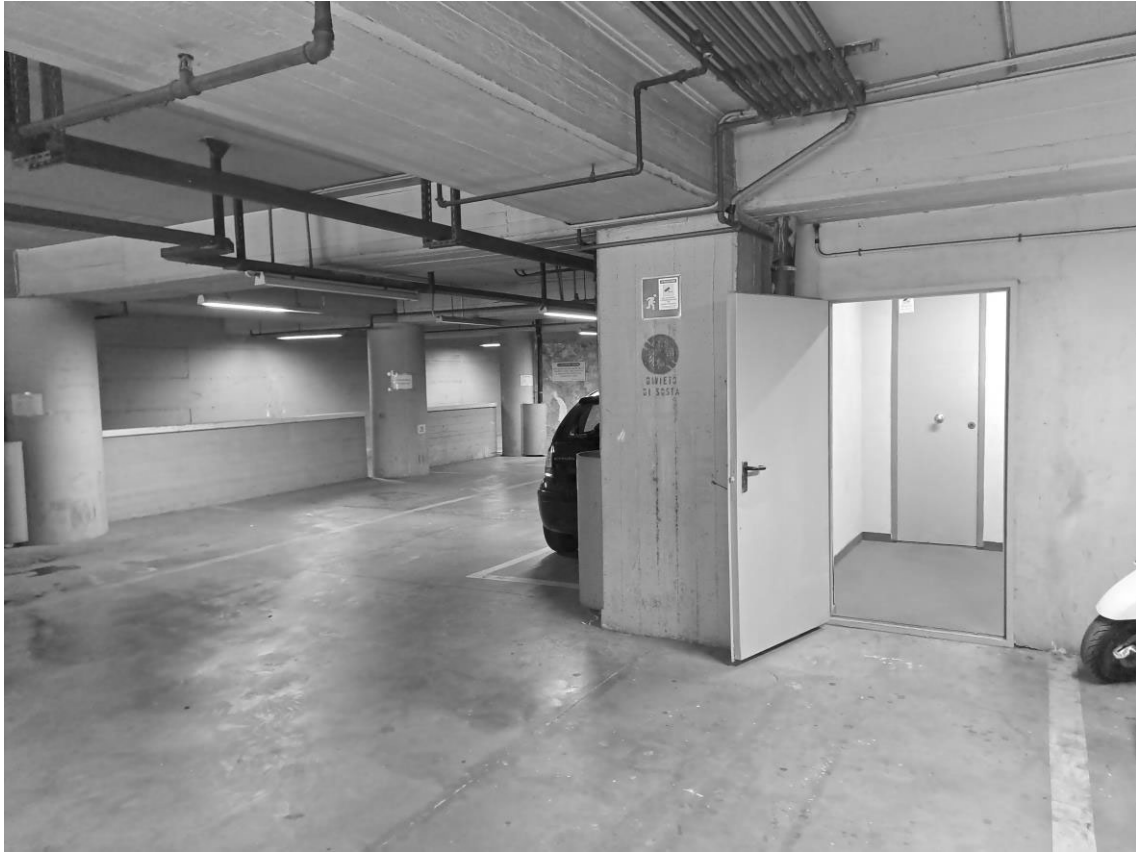
FOTO N. 10: la ripresa mostra il collegamento il vano scala del fabbricato ed il posto auto oggetto di procedura.
