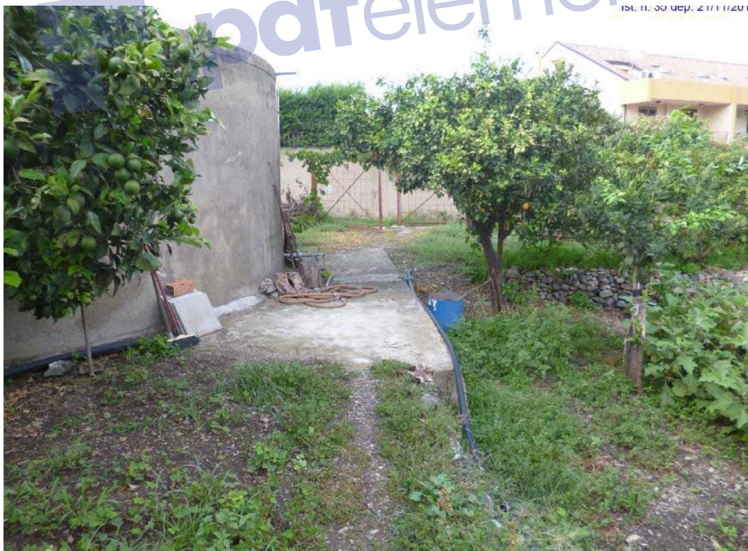
Figura 11 – Vista dell'immobile – (alla data del sopralluogo)
