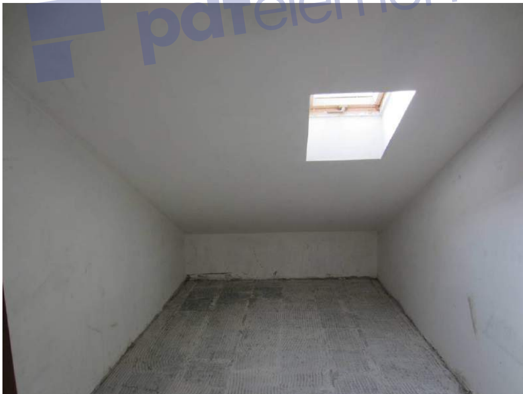
Figura 6 – Interno dell’immobile – (libero alla data del concordato)
