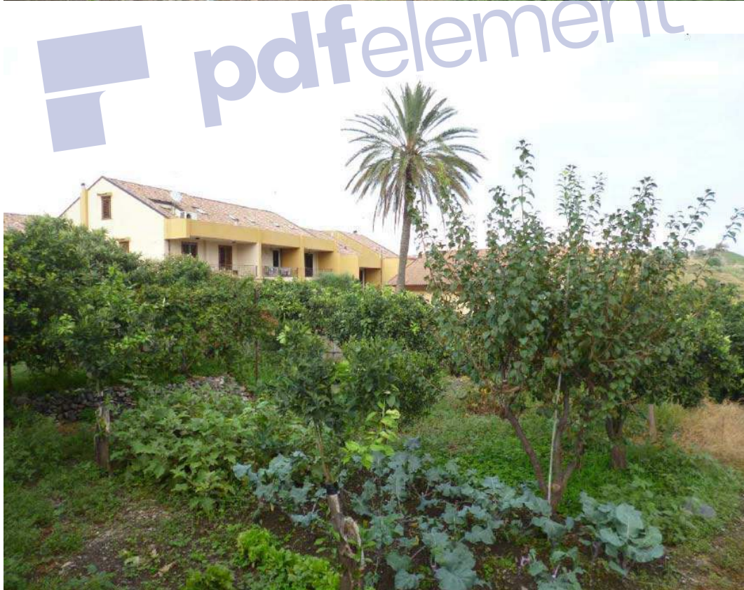
Figura 9 – Vista dell’immobile – (alla data del sopralluogo)
