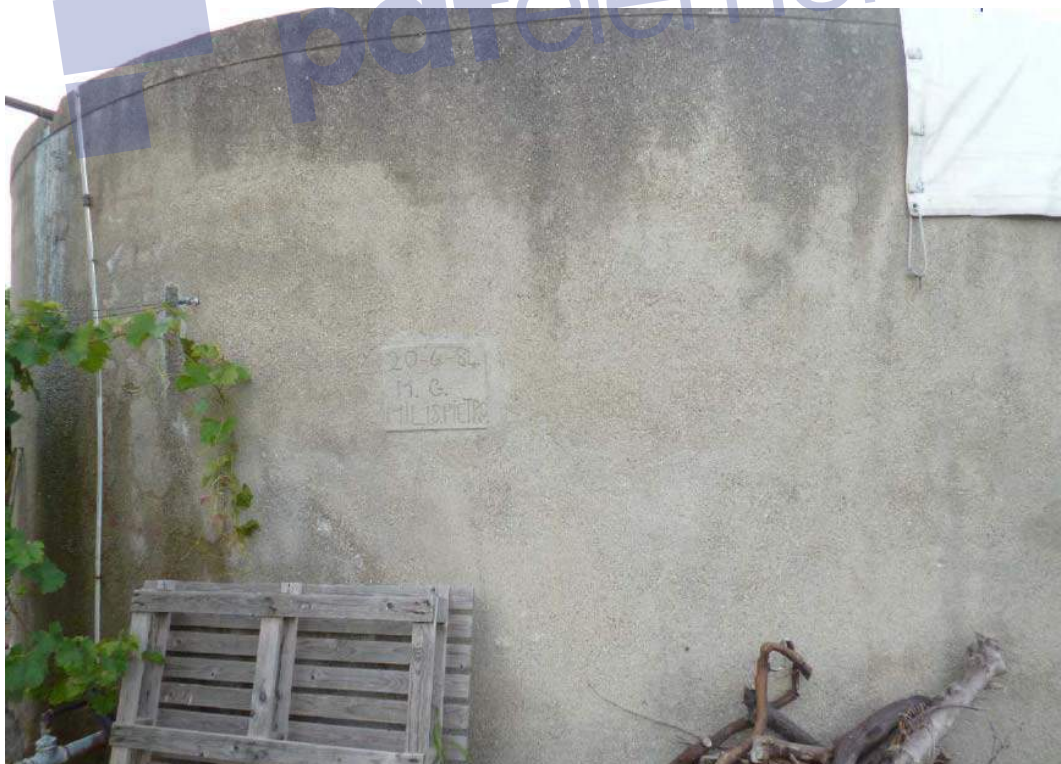
Figura 8 – Vista dell’immobile – (alla data del sopralluogo)
