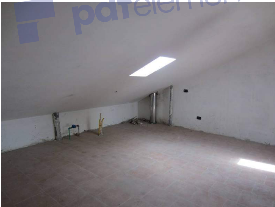
Figura 6 – Interno dell’immobile – (libero alla data del concordato)
