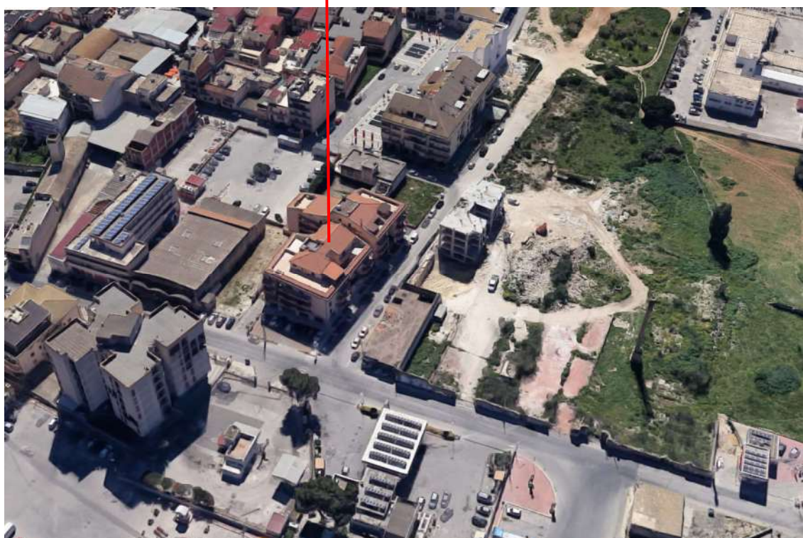
Figura n. 2.5 : Foto satellitare dell'unità immobiliare oggetto di stima
