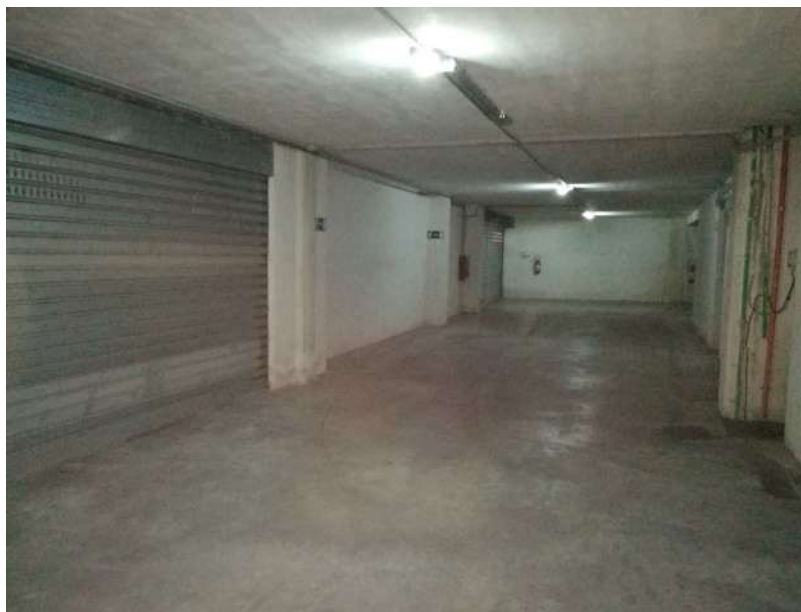
Foto n. n. 2.20: Corsia box auto al Secondo Livello interrato
