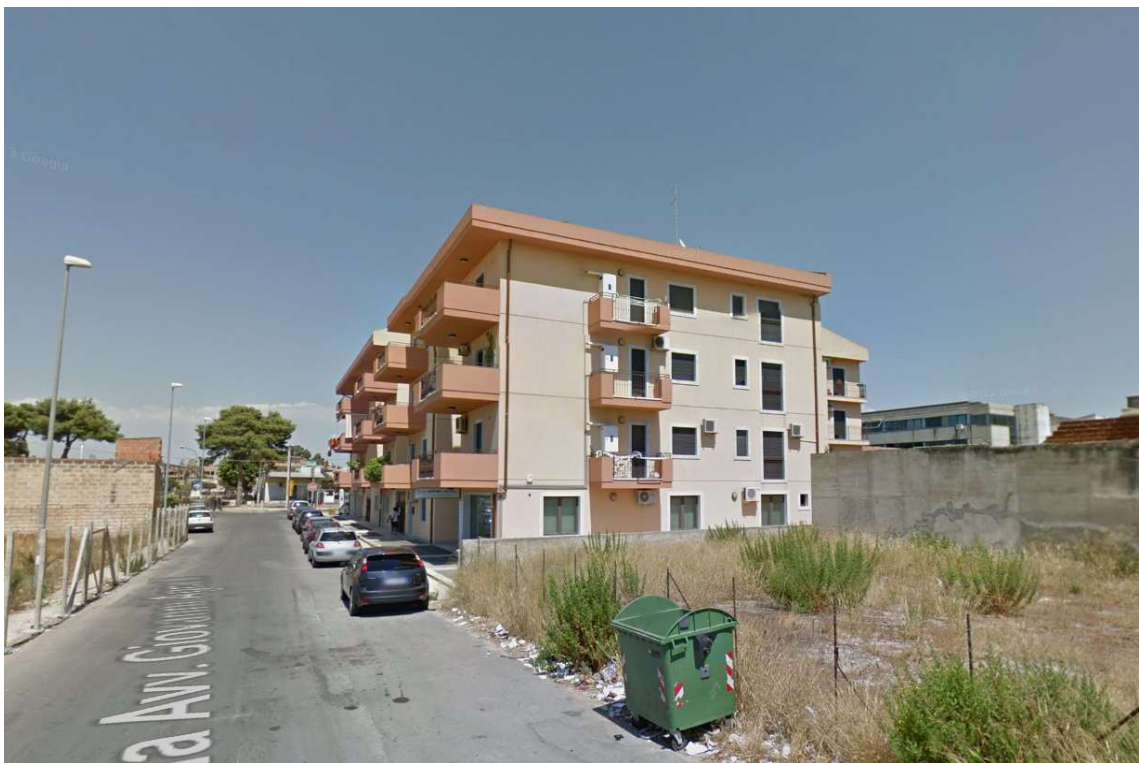
Figura n. 2.8 : Foto dell'unità immobiliare su Via avv. Giovanni Agnelli
