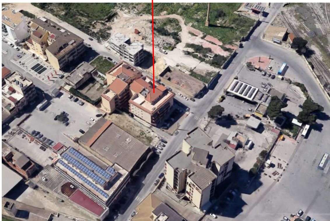
Figura n. 2.6 : Foto satellitare dell'unità immobiliare oggetto di stima
