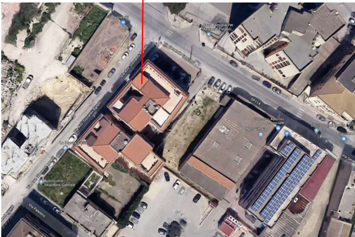
Figura n. 2.4 : Foto satellitare dell'unità immobiliare oggetto di stima
