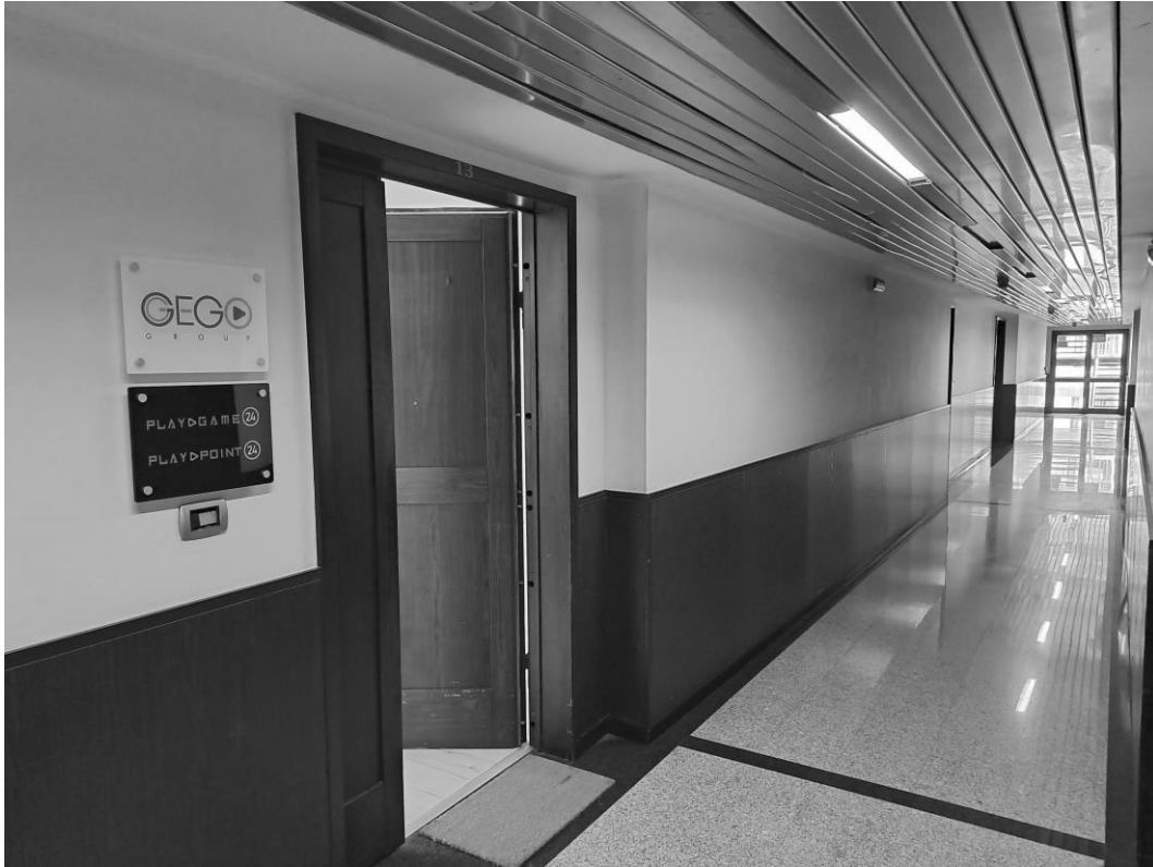
FOTO N. 4 (lotto n.1): la ripresa mostra l'ingresso all'immobile n.1 dal ballatoio comune.
