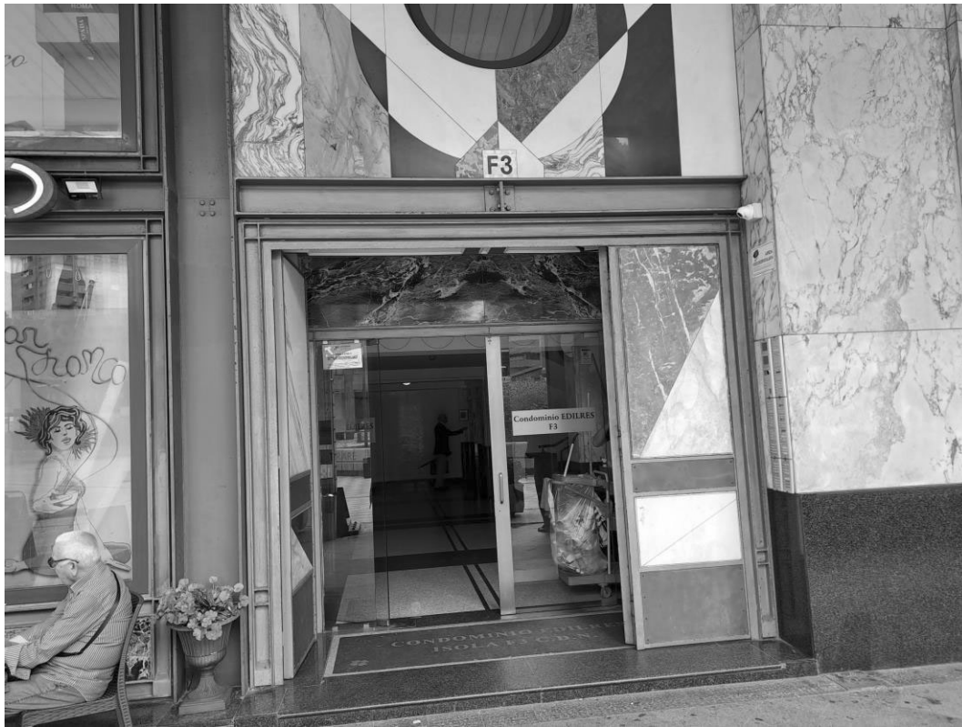
FOTO N. 2: la ripresa mostra il portone d'ingresso al fabbricato dalla facciata principale.
