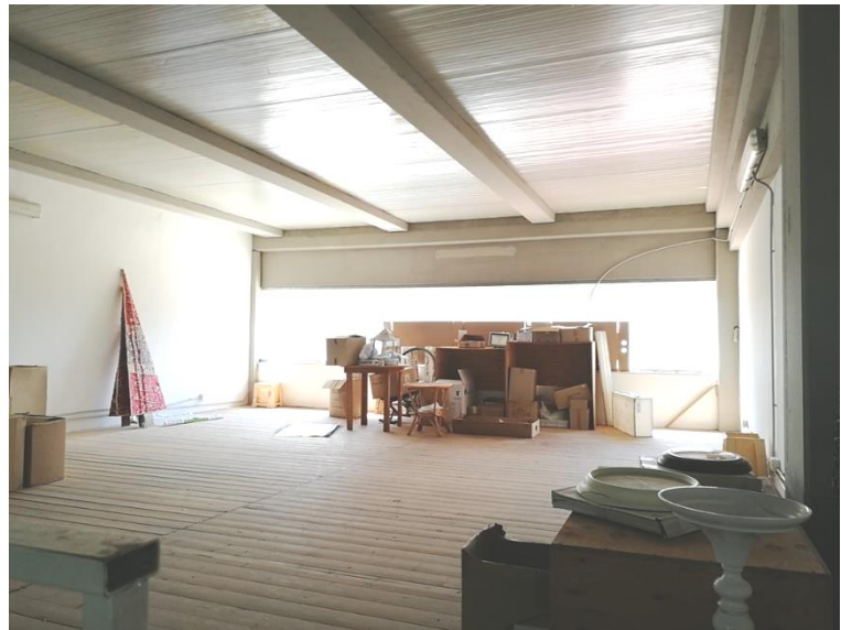
Foto n. 1.43: Fabbricato B – Magazzino C – Soppalco
