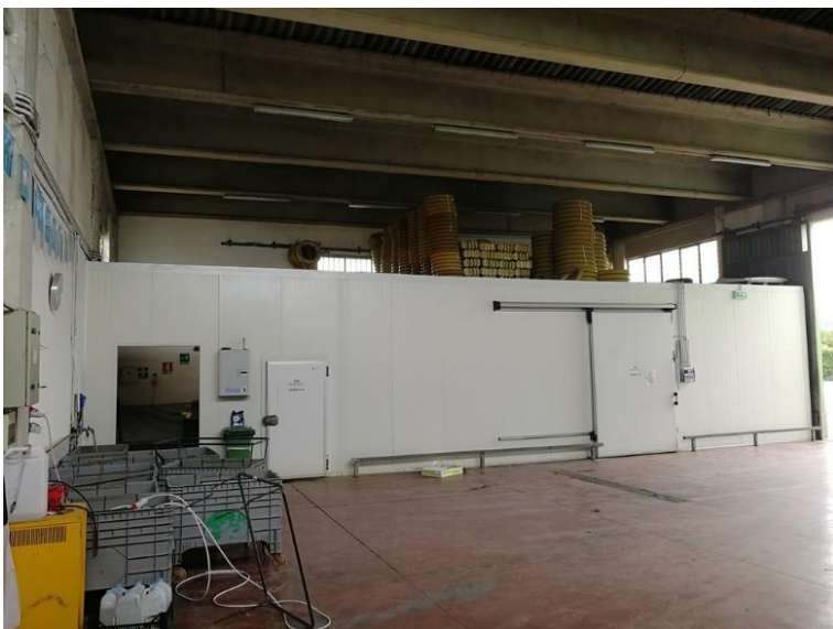
Foto n. 1.15 : Fabbricato A - Magazzino
