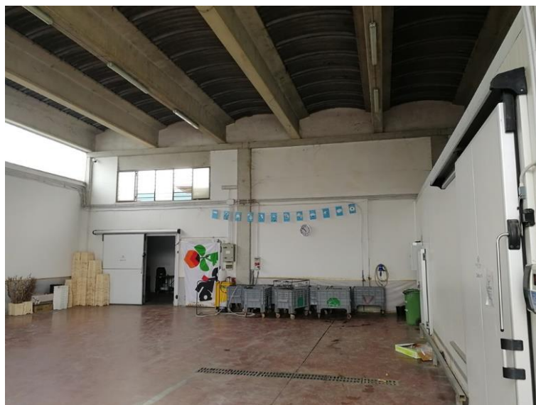
Foto n. 1.12 : Fabbricato A - Magazzino
