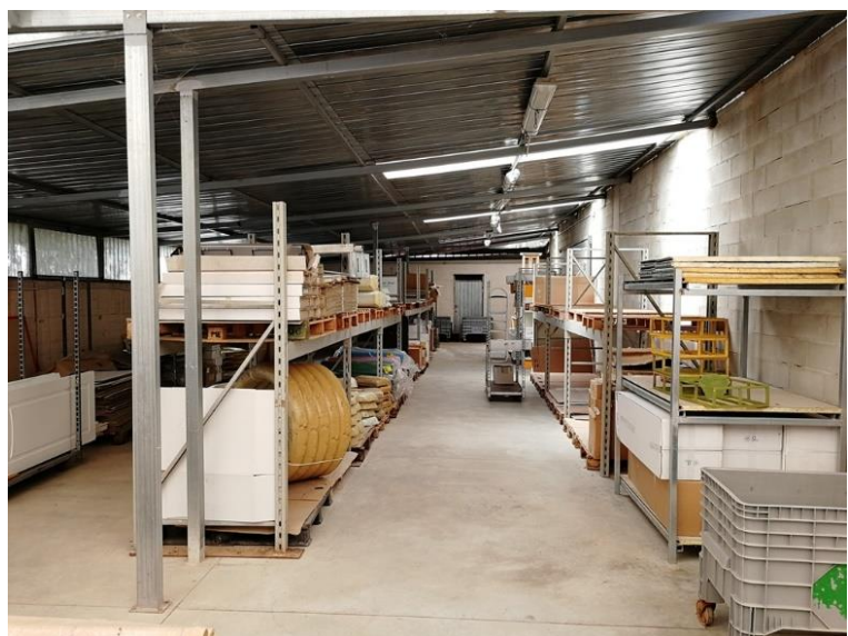
Foto n. 1.45: Tettoia in Ferro
