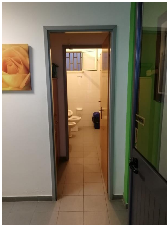
Foto n. 1.25: Fabbricato A – Anti Bagno
