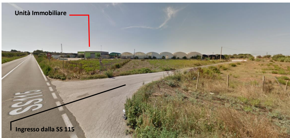
Figura n. 1.6 : Foto dell'unità immobiliare oggetto di stima - vista SS 115 direzione Gela - Vittoria
