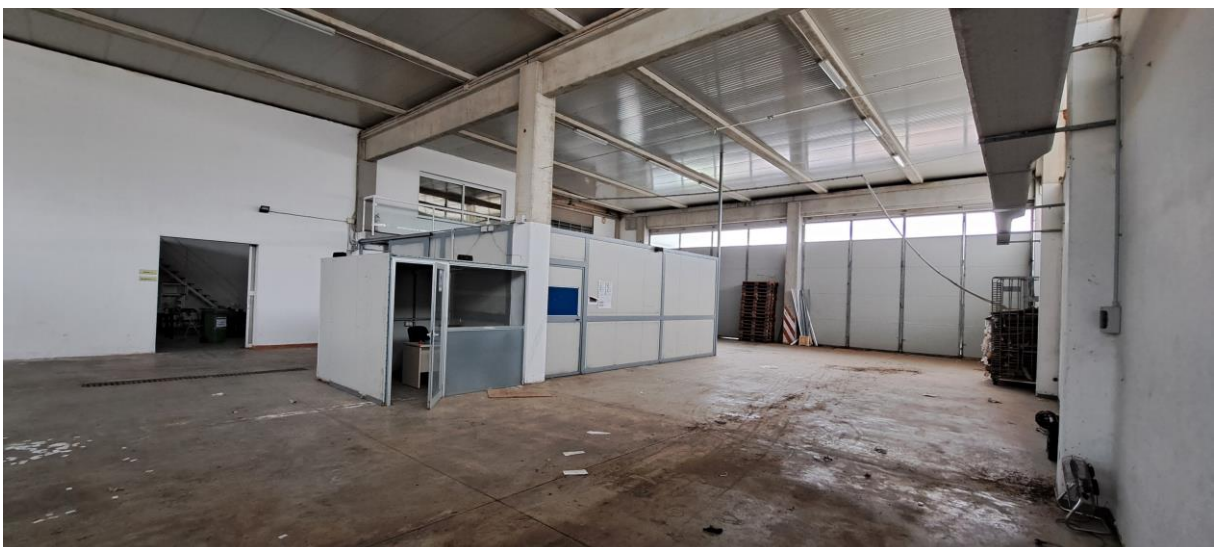
Foto n. 1.35 : Fabbricato B – Magazzino A (Foto anno 2024)
