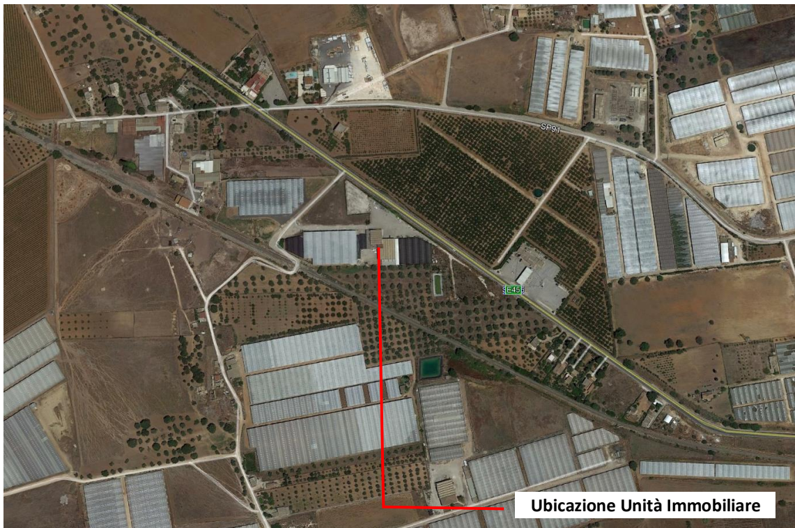
Figura n. 1.3 : Foto satellitare dell'unità immobiliare oggetto di stima
