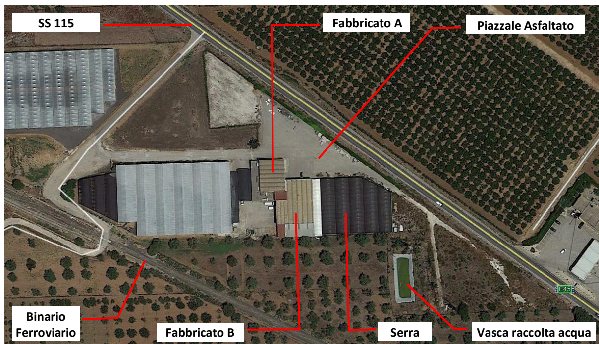
Figura n. 1.8 : Foto satellitare dell'unità immobiliare oggetto di stima
