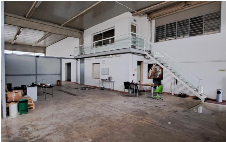
Foto n. 1.33 : Fabbricato B – Magazzino A (Foto anno 2024)
