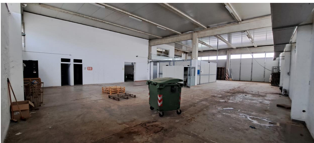
Foto n. 1.37 : Fabbricato B – Magazzino B (Foto anno 2024)
