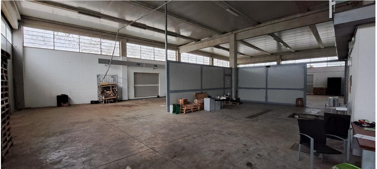
Foto n. 1.32 : Fabbricato B – Magazzino A (Foto anno 2024)
