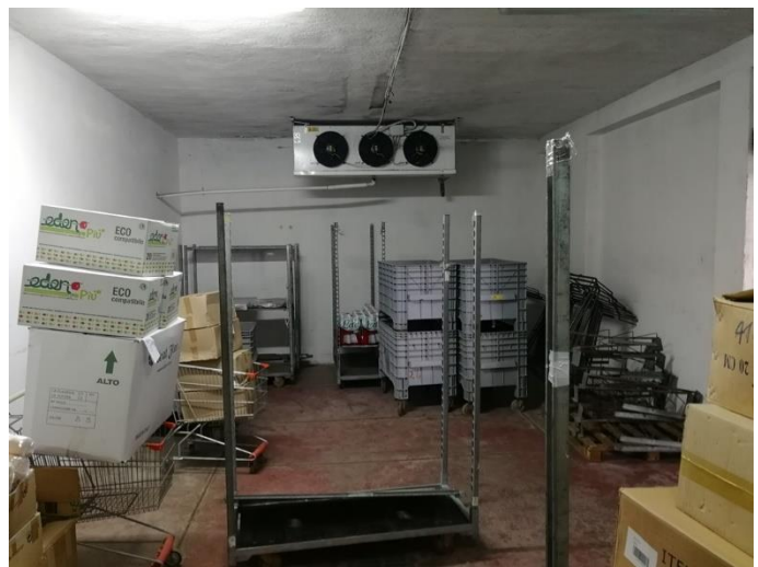
Foto n. 1.21 : Fabbricato A – Cella Frigo 2
