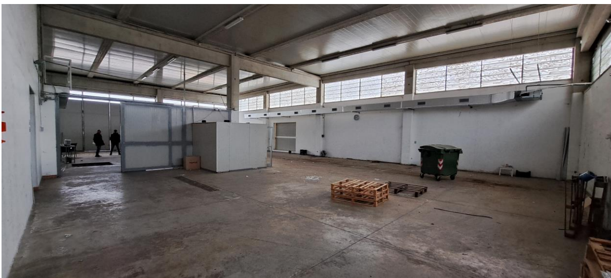
Foto n. 1.38 : Fabbricato B – Magazzino B (Foto anno 2024)
