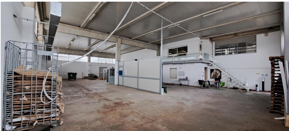
Foto n. 1.36 : Fabbricato B – Magazzino B (Foto anno 2024)
