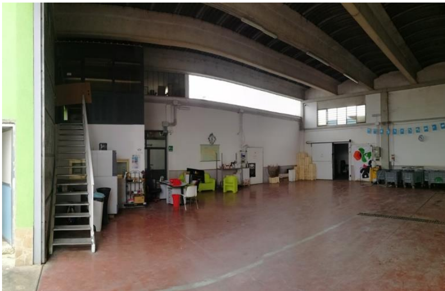
Foto n. 1.11 : Fabbricato A - Magazzino
