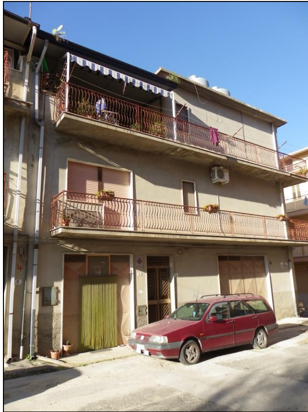
Fig.2 - Vista del fabbricato di cui al Fg.5 Part.385 Sub. 2-3-4, dalla via Fratelli Rosselli in Mirabella Imbaccari
