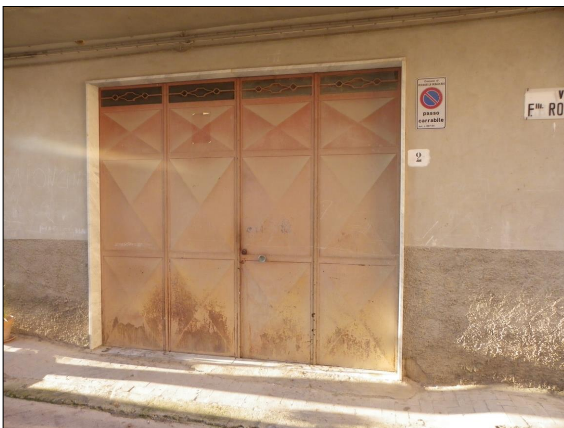
Fig.23 - Portone di ingresso al Box di cui al Fg.5 Part.385 Sub. 2, via Fratelli Rosselli n.2 in Mirabella Imbaccari
