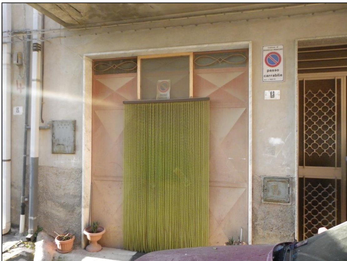
Fig.21 - Portone di ingresso esterno al deposito di cui al Fg.5 Part.385 Sub. 4, via Fratelli Rosselli n.6 in Mirabella Imbaccari
