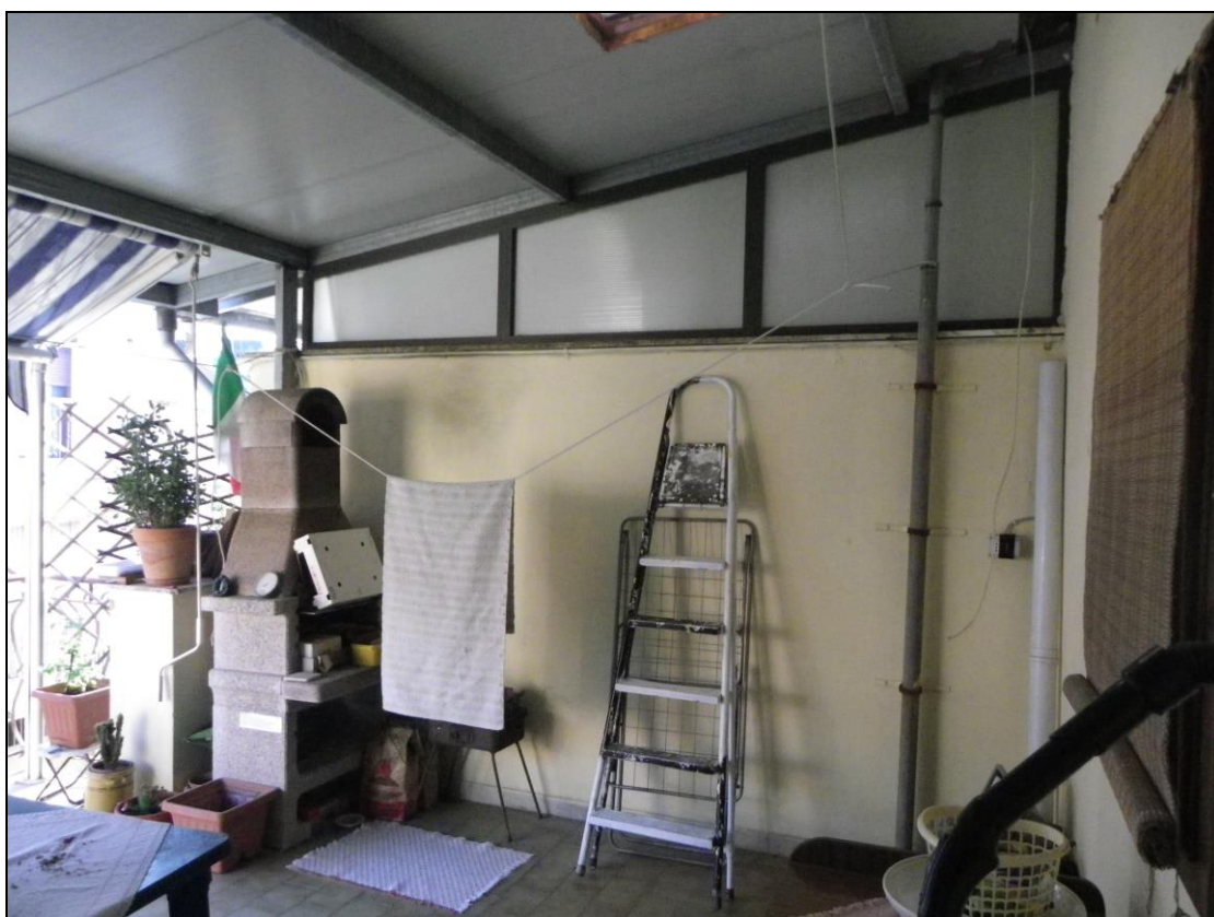
Fig.17 -Terrazza a livello coperta da tettoia al secondo piano dell'abitazione di via Fratelli Rosselli n.4 in Mirabella Imbaccari
