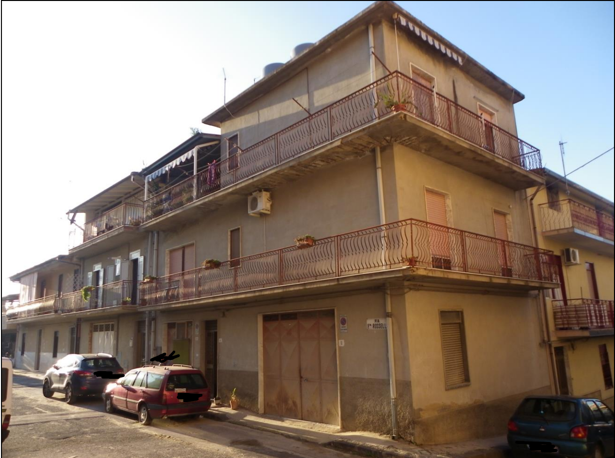
Fig.1 - Vista del fabbricato di cui al Fg.5 Part.385 Sub. 2-3-4, angolo tra via Palermo e via Fratelli Rosselli in Mirabella Imbaccari
