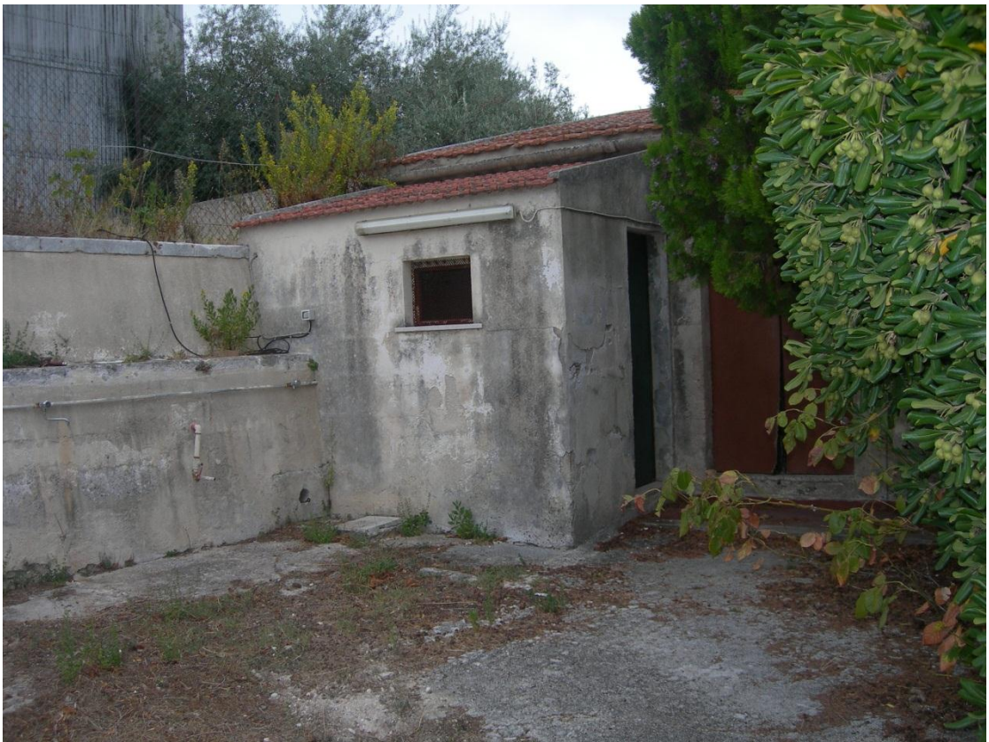
FOTO 4 – Vista servizio igienico.
