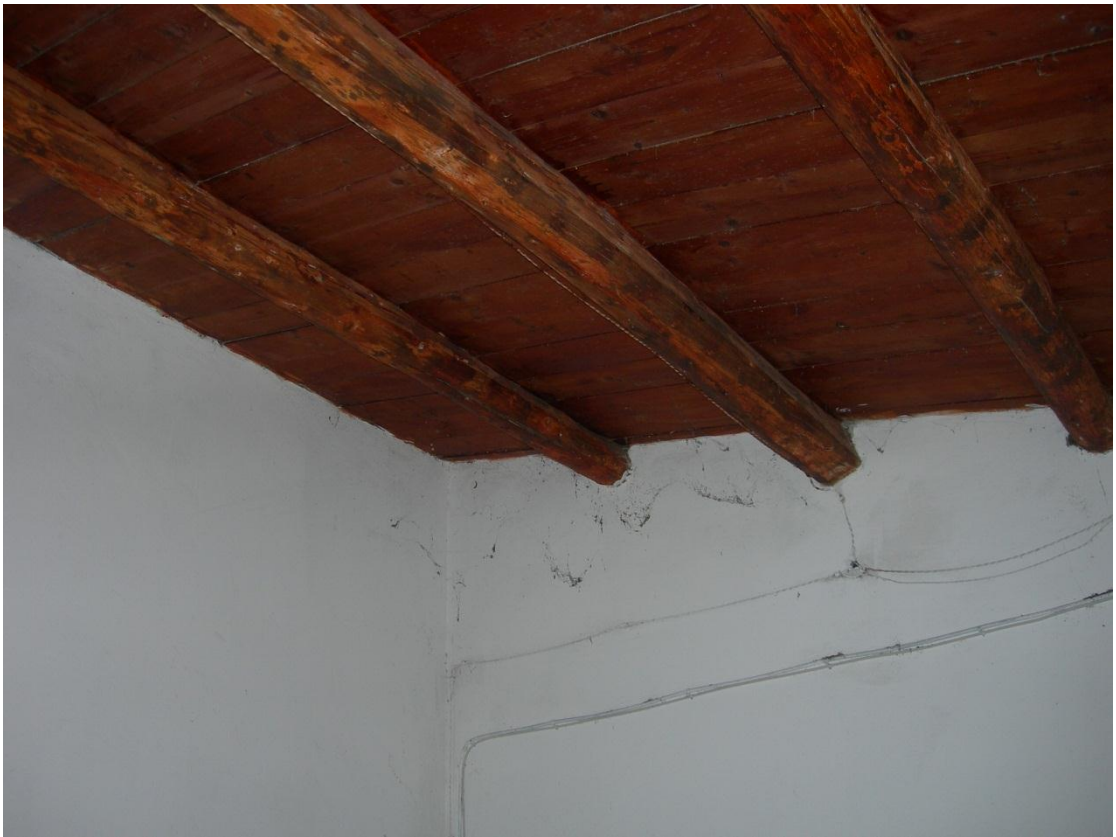
FOTO 5 – Vista interna magazzino.
