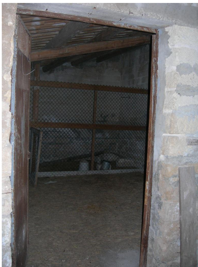
FOTO 6 – Vista interna deposito.
