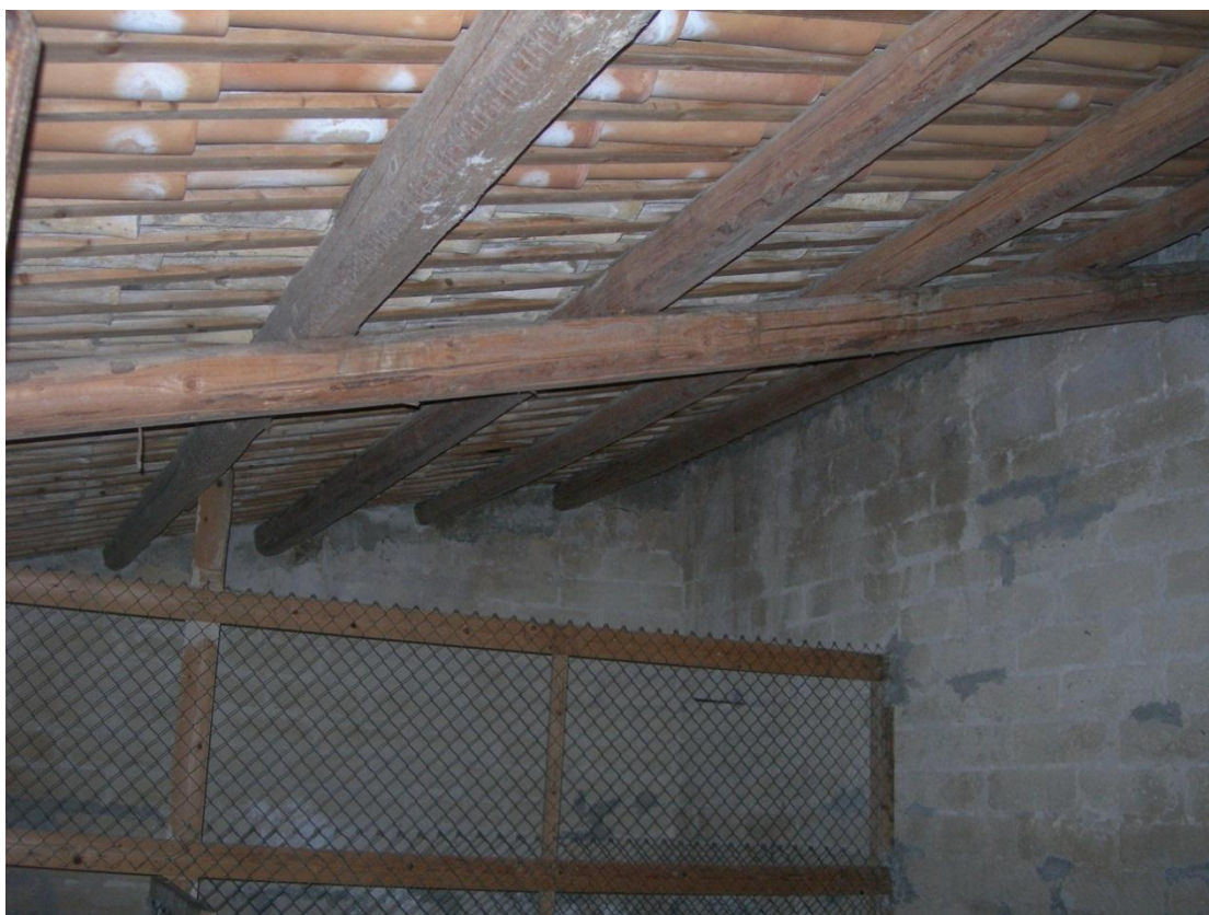
FOTO 5 – Vista interna deposito.
