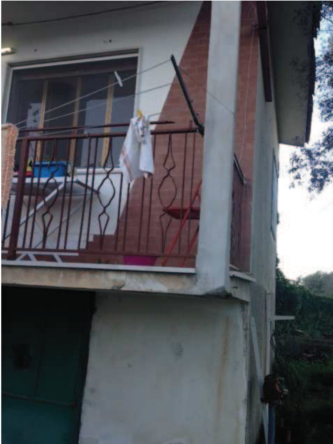
ESTERNO FABBRICATO ABITAZIONE USO UFFICIO
