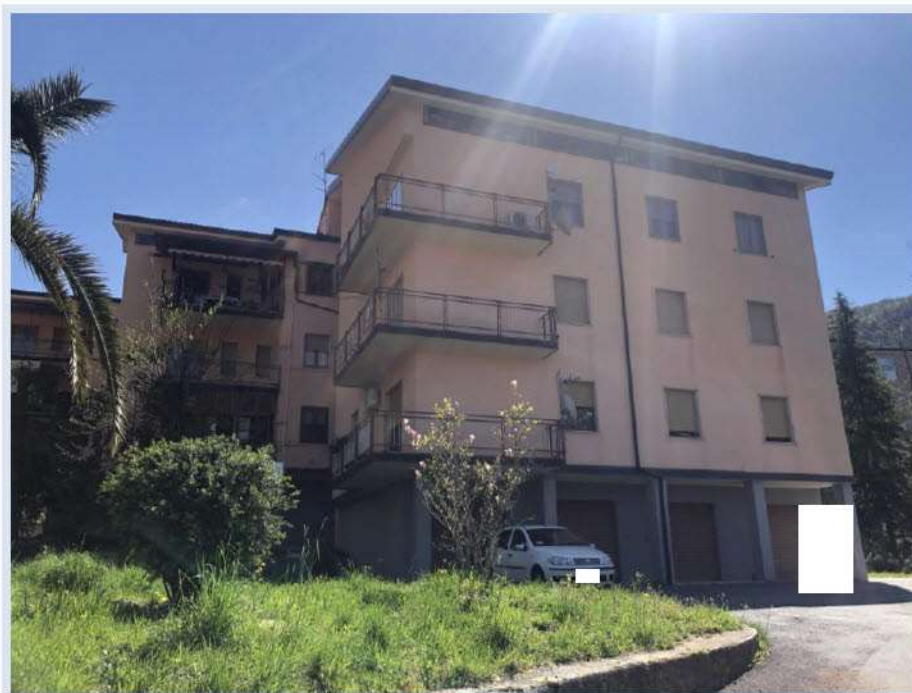
Fig. 15 – Fabb.to in via XXV Aprile Prospetto laterale-ingresso
