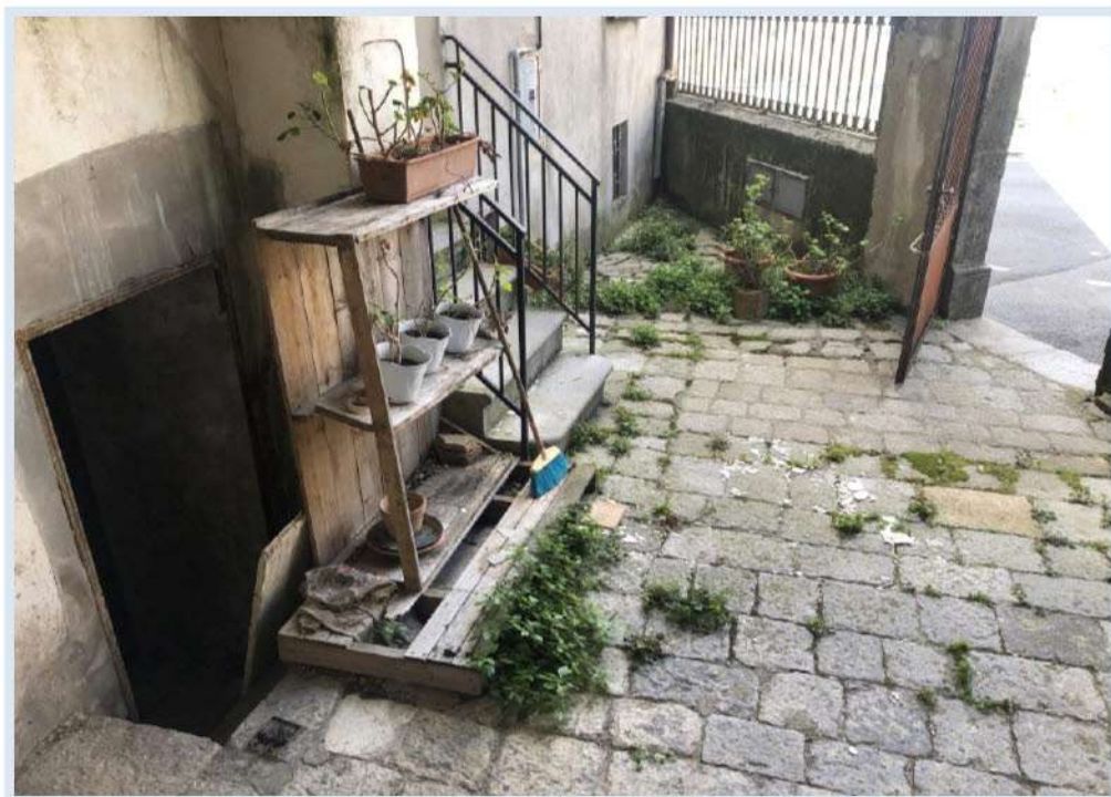
Fig. 21 - Ingresso da area comune
