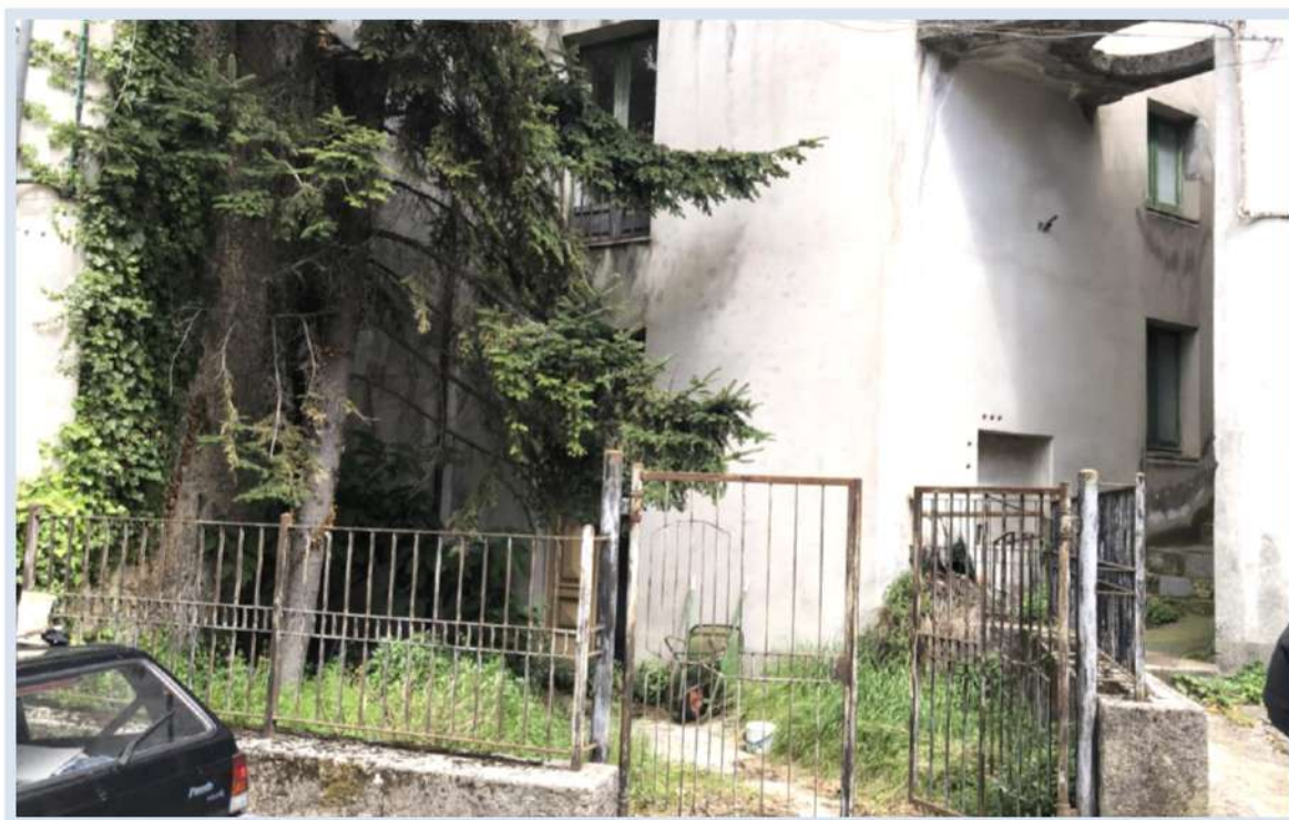
Fig. 24- Ingresso da via Cafaro Coperto
