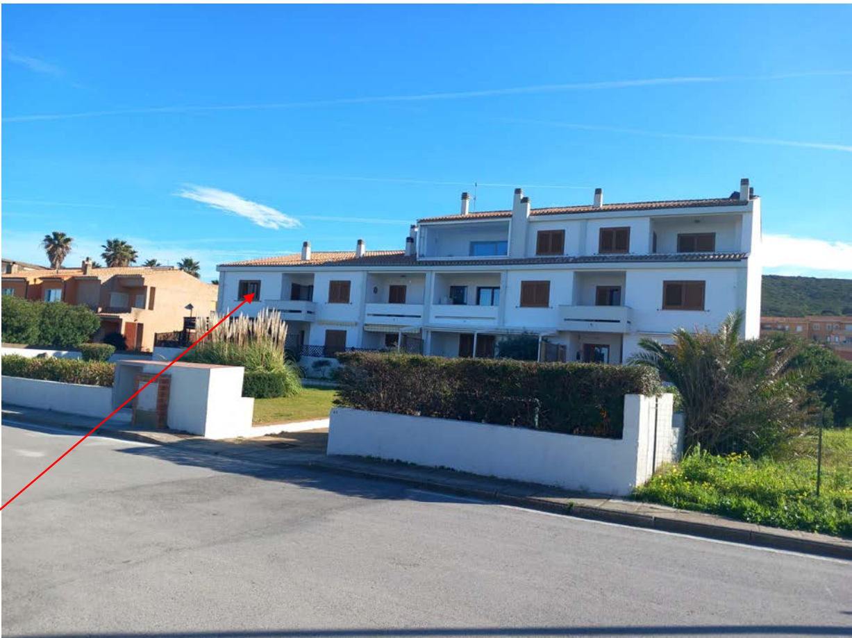
Foto 2 - L' edificio condominio "l'Isolotto" facciata prospiciente la Via di Riva dei Lestrigoni;
