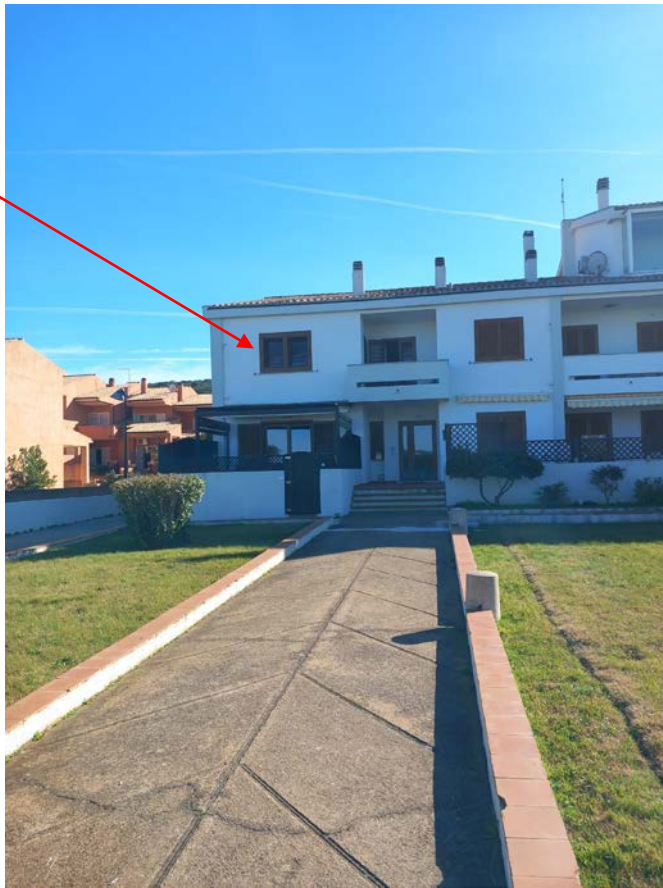
Foto 3 Particolare della vista dell' ingresso principale
