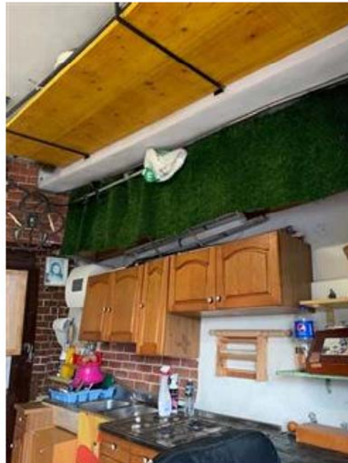
Magazzino : interno parziale.
