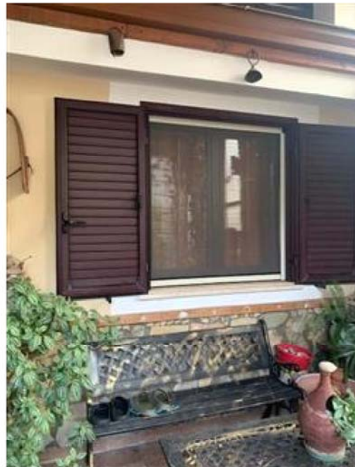
Facciata anteriore parziale.
