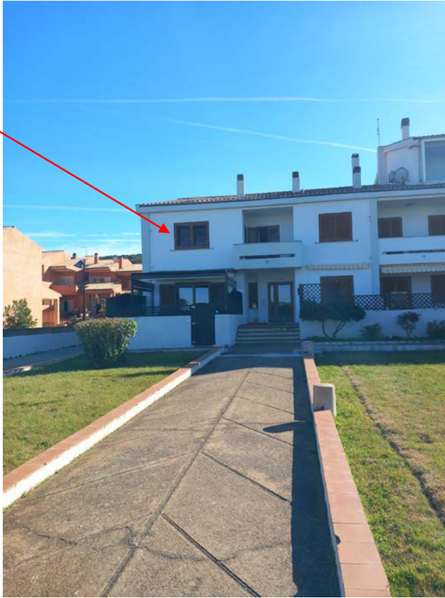
Foto 3 Particolare della vista dell' ingresso principale
