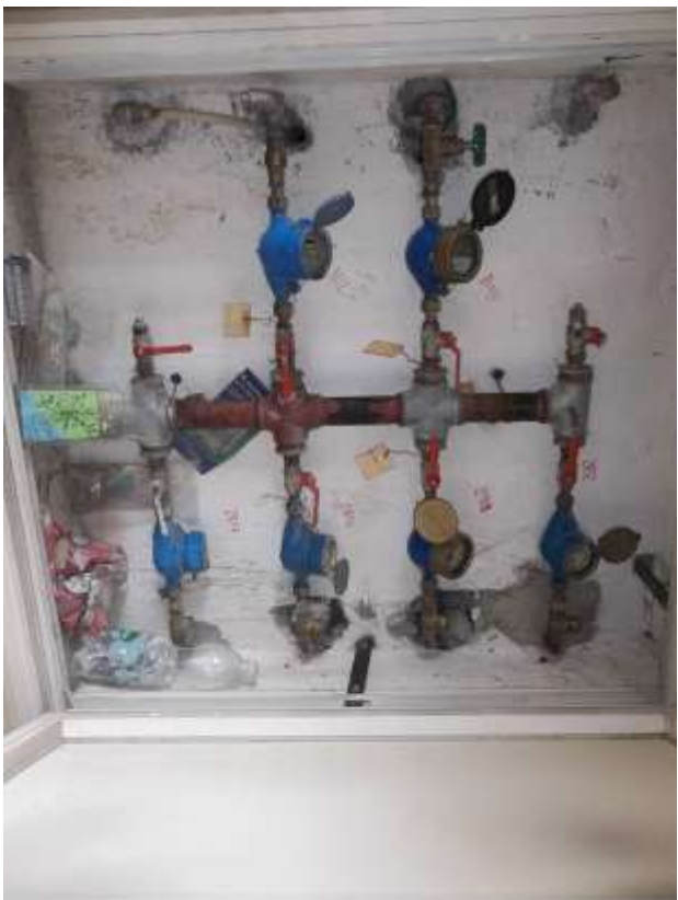
Foto 17 – contatore acqua potabile
