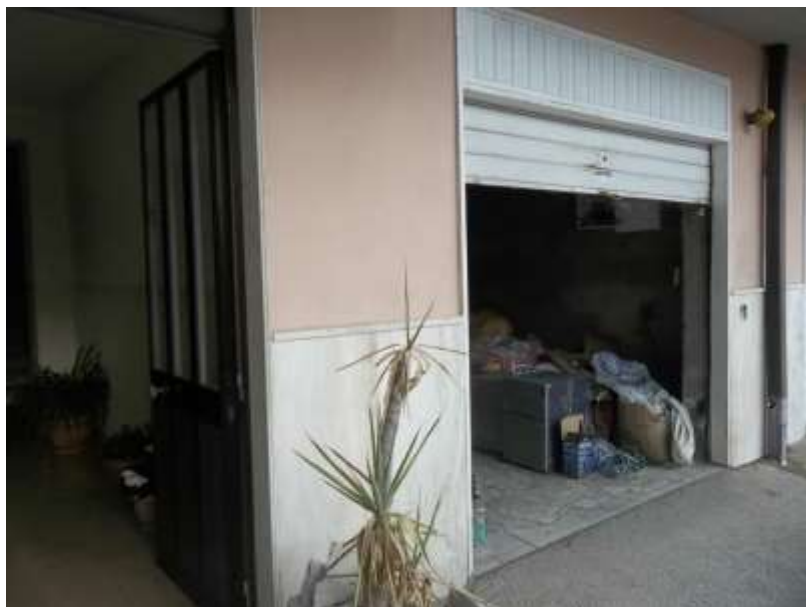
Foto 3 – Porta di accesso all'autorimessa sub14 dal piazzale esterno (abuso edilizio)
