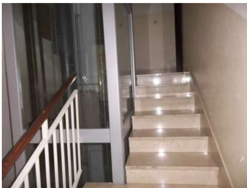
Foto 2 – particolare vano scala condominiale e ascensore
