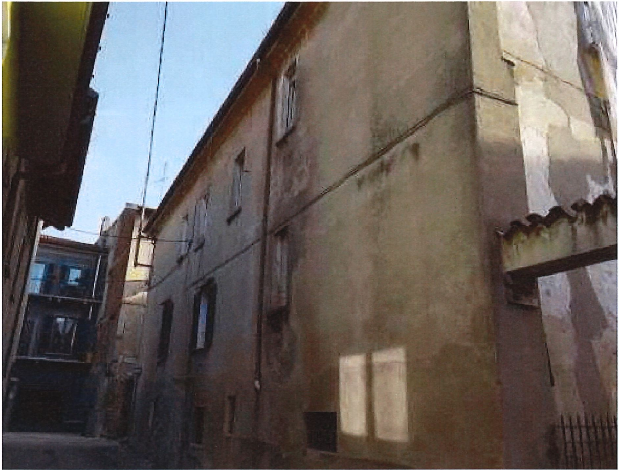
Vista del fronte sulla Via Comi
