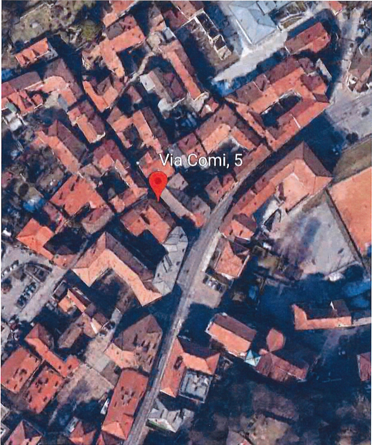
Vista del fabbricato dall' alto
