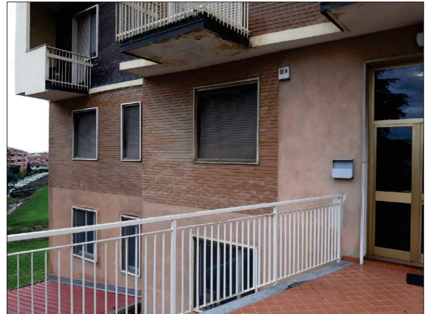
Particolare facciata Nord alloggio
