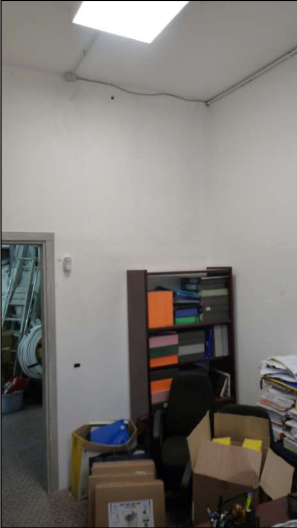
Vista interna del locale lato est accesso – Fotografia 13
