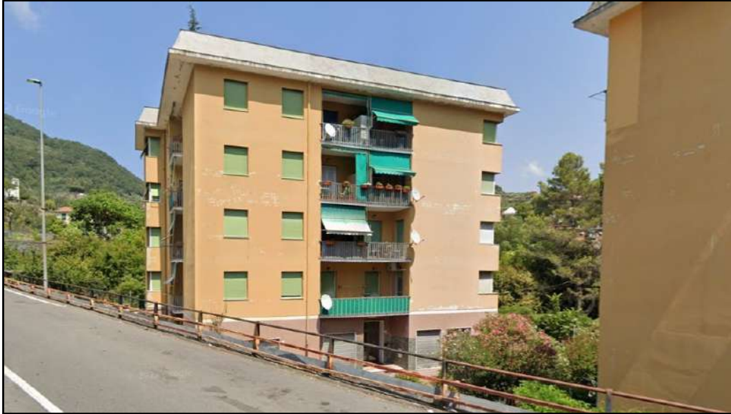
Vista Facciata sud da Via di Creto - Fotografia 1
