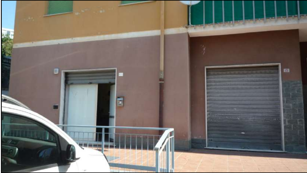
Altra vista con particolare varchi di accesso all'immobile - Fotografia 3
