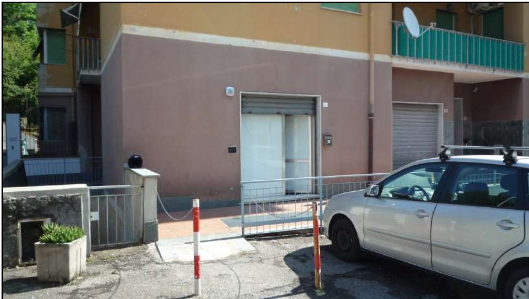
Porzione di facciata sud con vista varchi di accesso all'immobile- Fotografia 2
