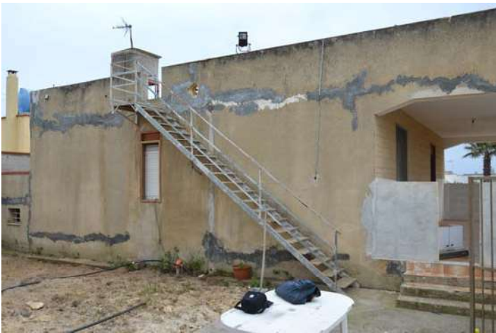
accesso al fabbricato dal terreno comune
