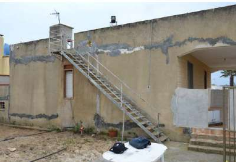
accesso al fabbricato dal terreno comune
