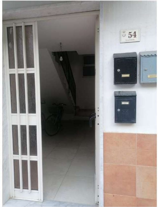
Ingresso al vano scala
