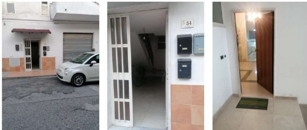
Appartamento posto al piano terra Via La Valletta n. 54
