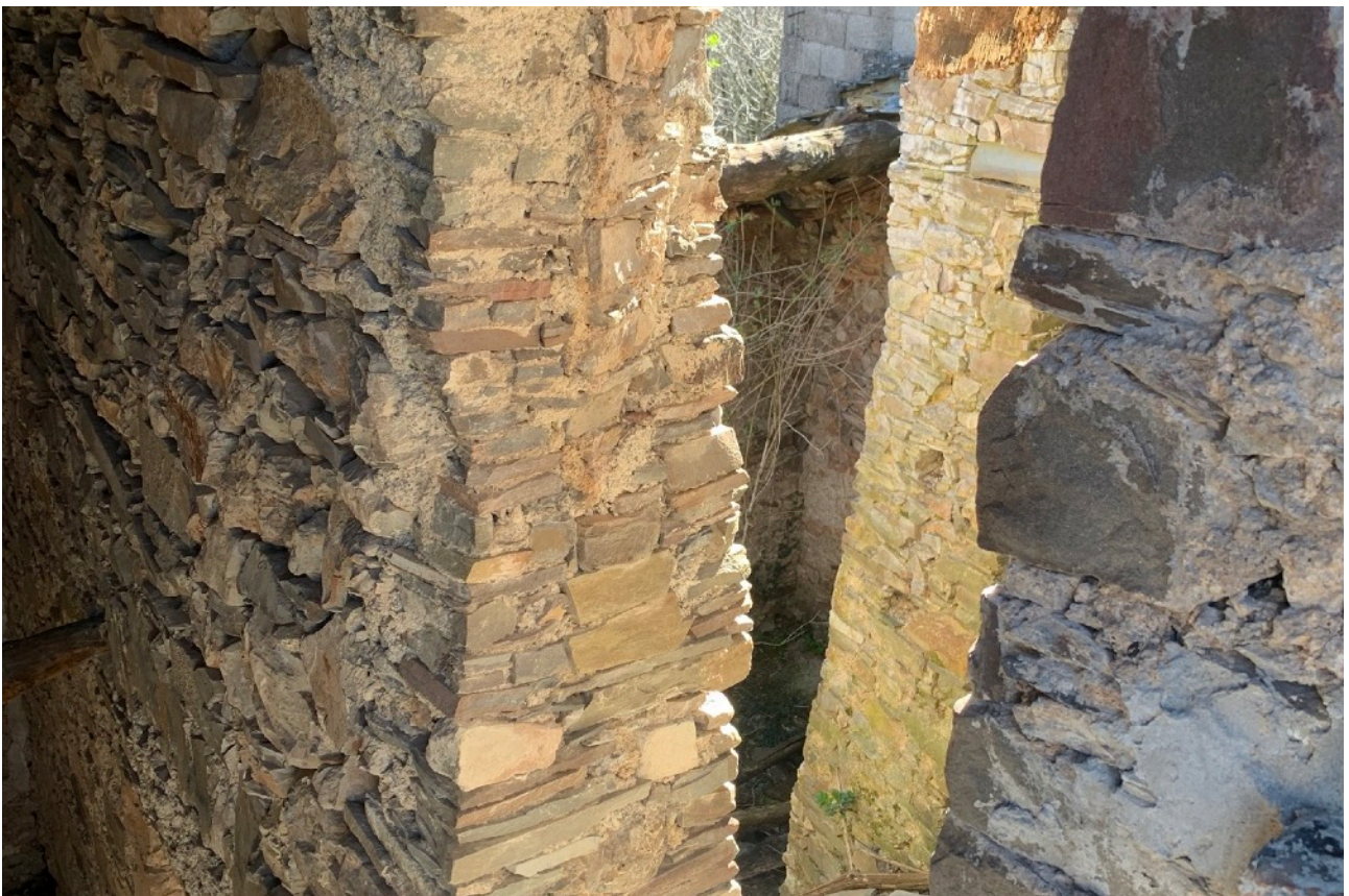
FOTO 4_ dettaglio interno Fabb. Rurale part.84
