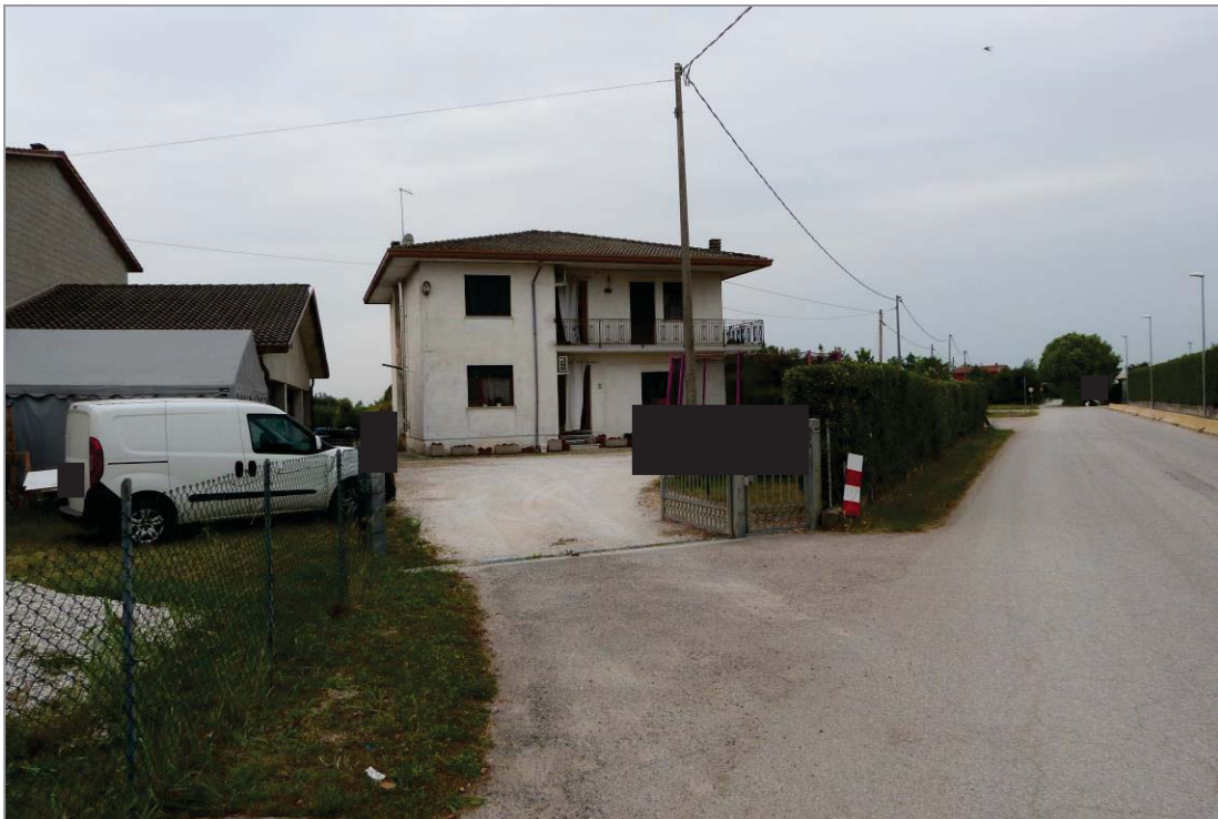
1 Vista da via La Piccola dei beni oggetto di stima e degli accessi pedonale e carroia.
