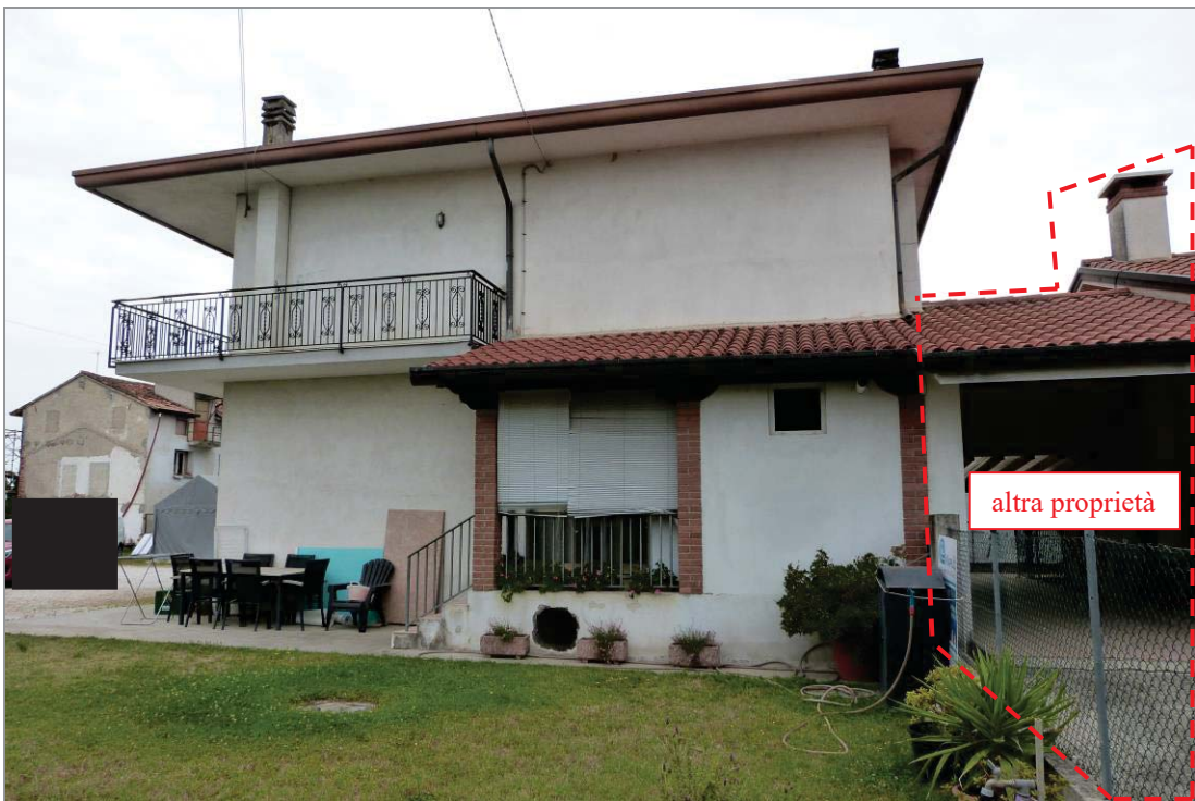
4 Vista del prospetto ovest e di parte dell'area scoperta.
