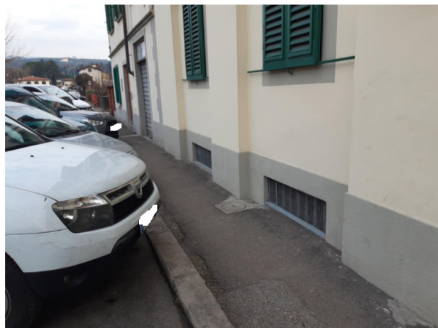
FOTO 20 - finestra della cantina
