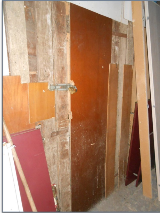
Foto 17 porta ingresso solaio
