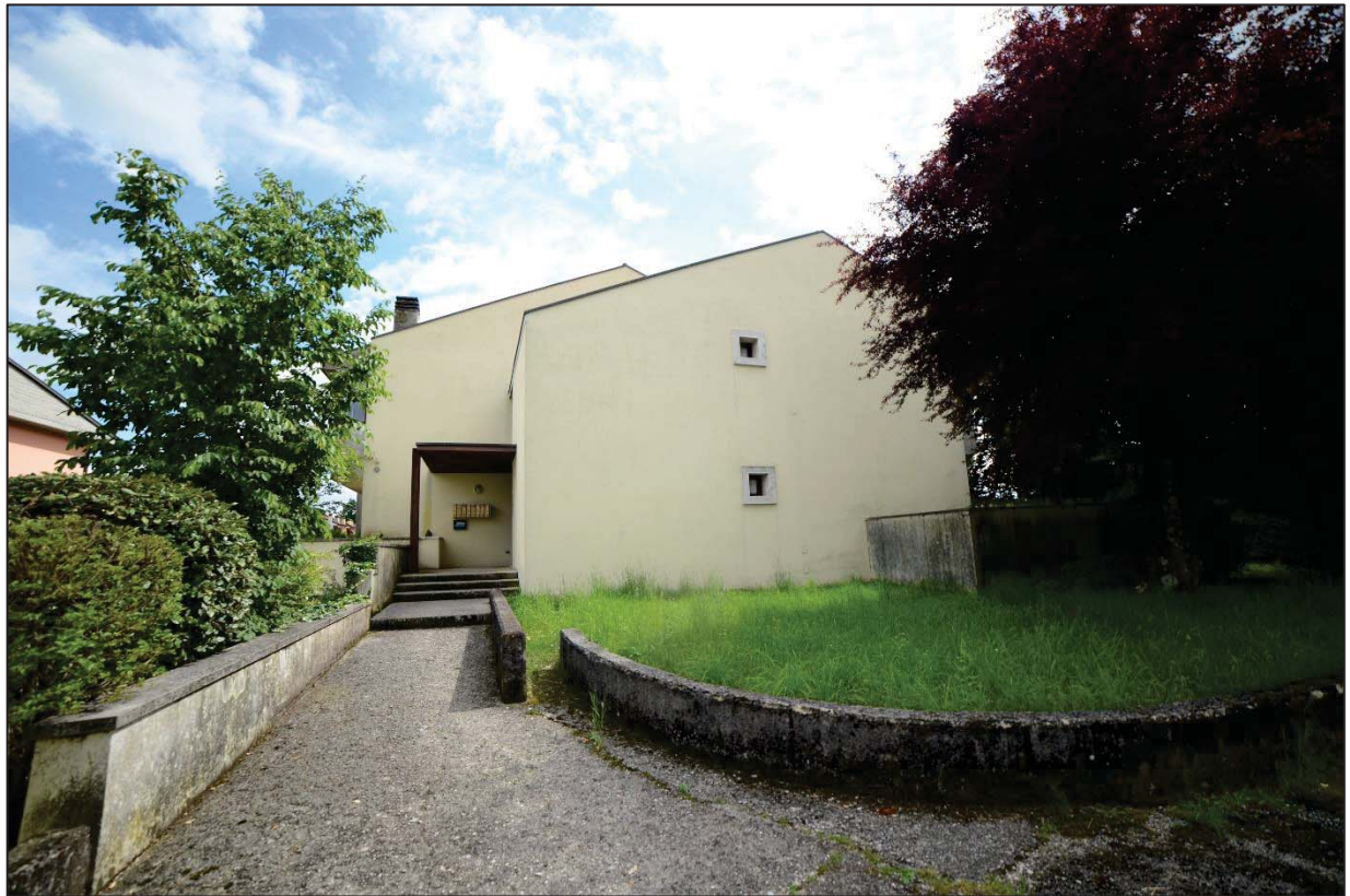
Foto 3 – Accesso pedonale da Via Salvioni
