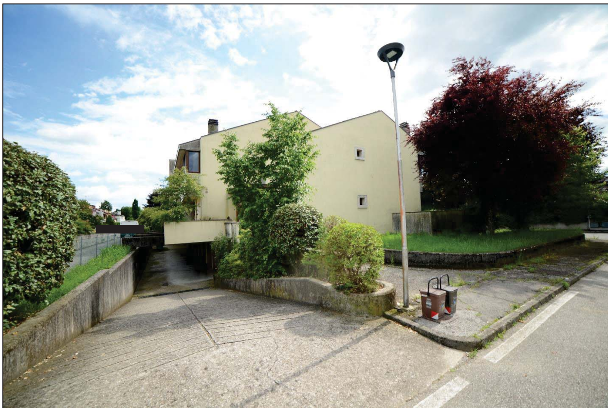
Foto 2 – Accesso rampa ed autorimesse
