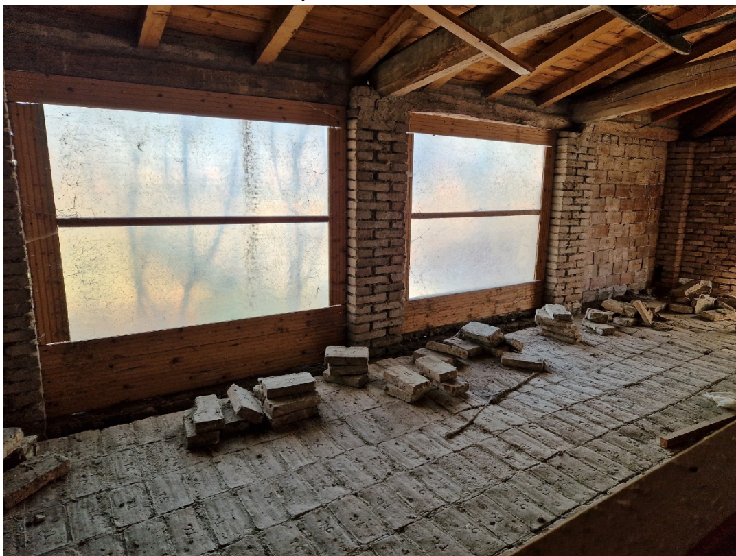
13. Interno del fabbricato accessorio – Piano primo
