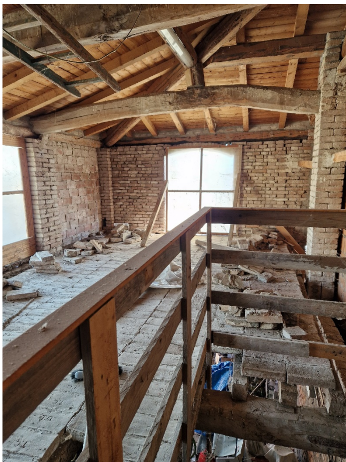
14. Interno del fabbricato accessorio – Piano primo
