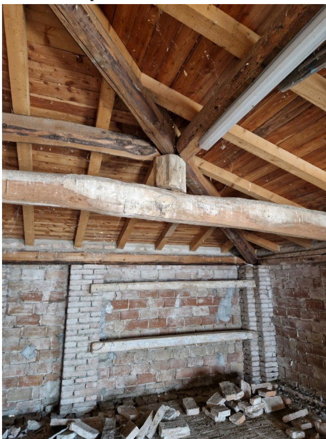
15. Il fabbricato accessorio – particolare del tetto a vista
