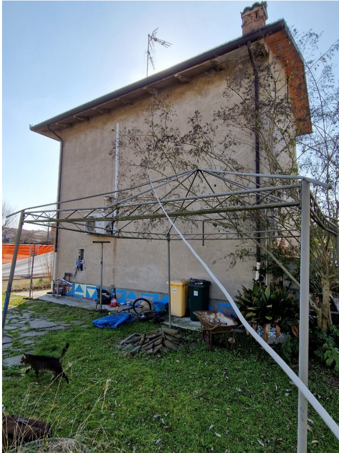
2. Il retro del fabbricato abitativo
