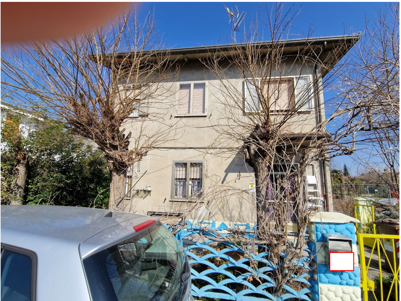
1. Il fronte principale del fabbricato abitativo su via Calcina Vecchia
