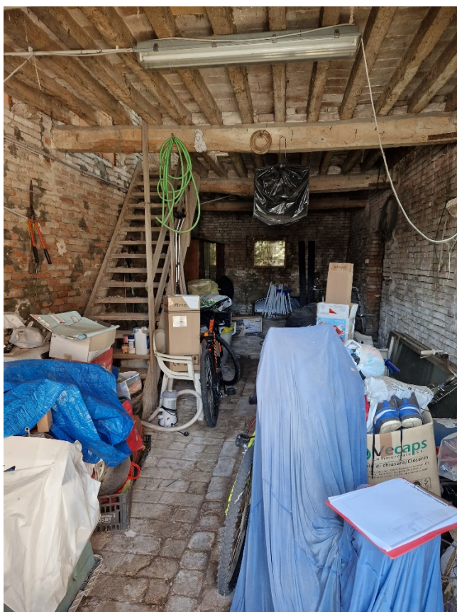
12. Il fabbricato accessorio al piano terra
