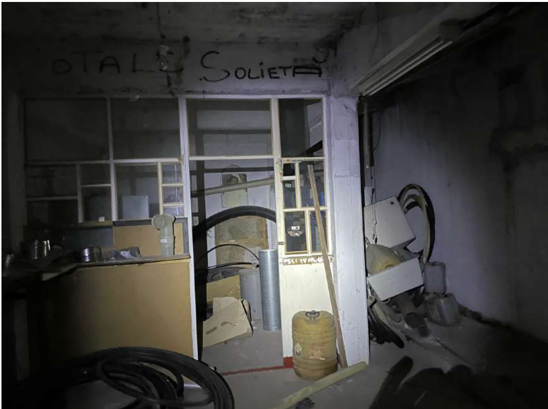
FOTO 20 – vista intelaiatura lignea provvisoria
