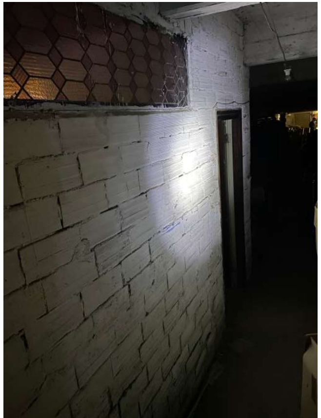
FOTO 16 – tramezze deposito interno
