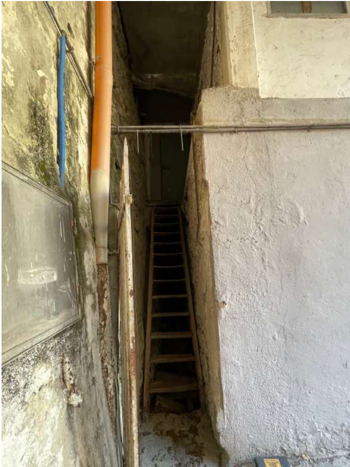
FOTO 5 – scala di accesso al magazzino
