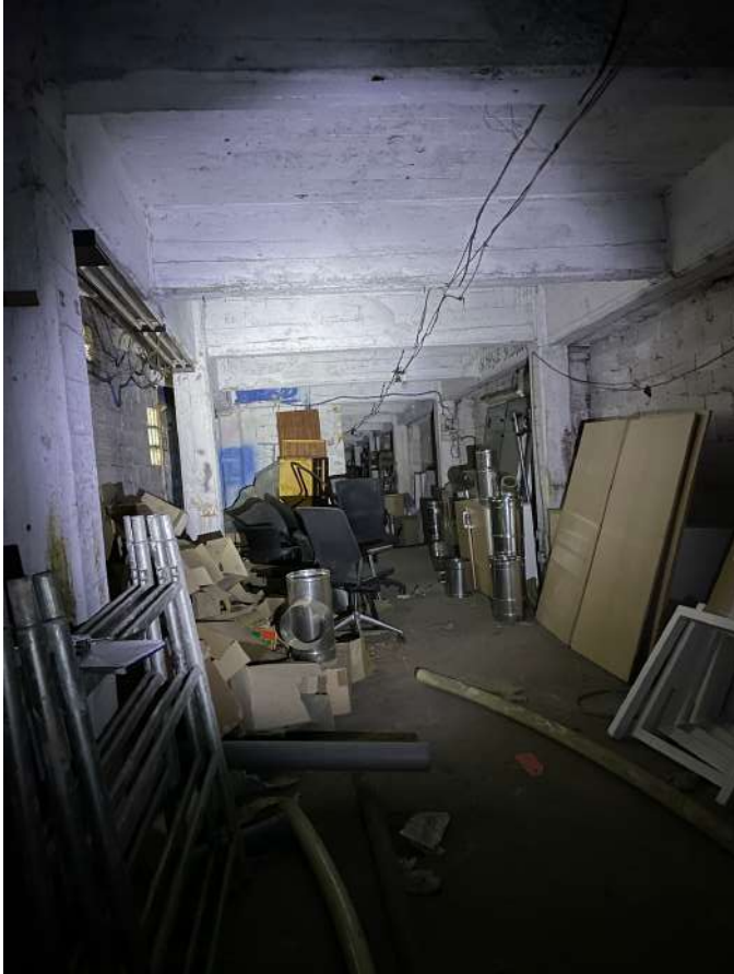
FOTO 17 – vista da nord verso sud
