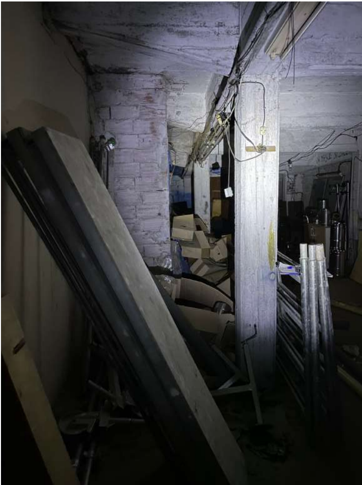
FOTO 19 – zona allargamento muro esterno lato est
