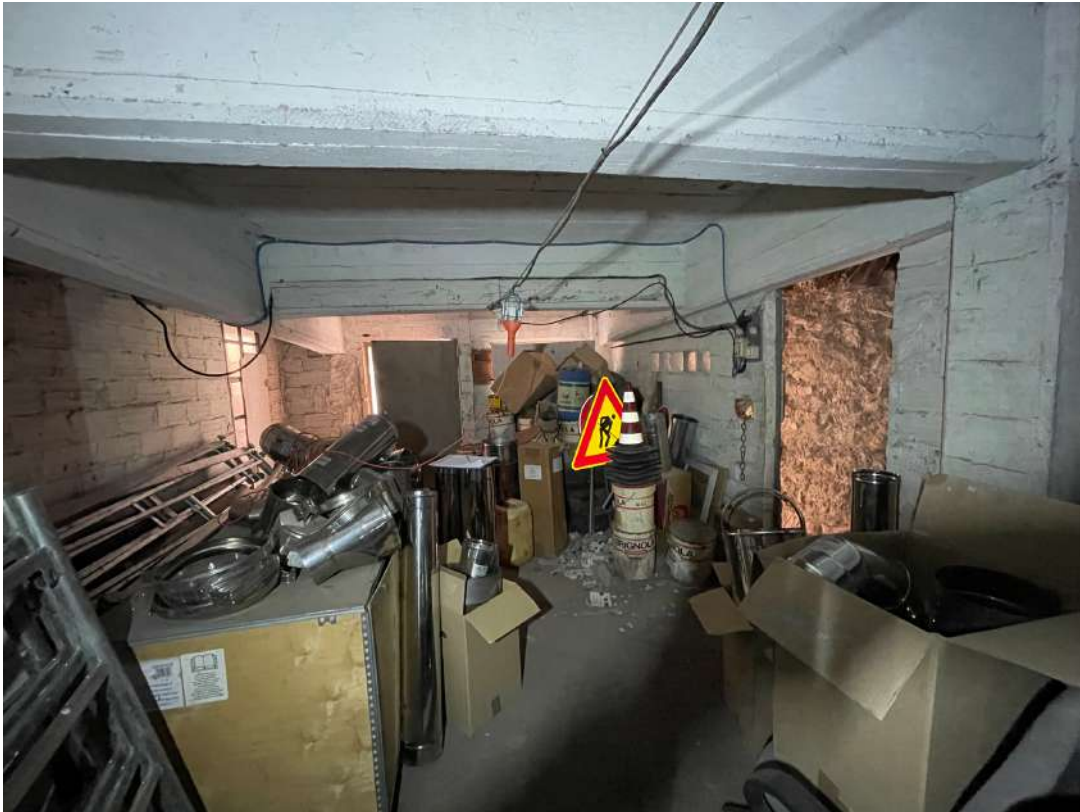
FOTO 9 – vista interna (porta di accesso laterale e porta frontale che da su area condominiale)
