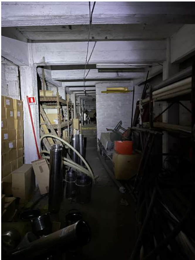
FOTO 12 – vista tramezze interne
