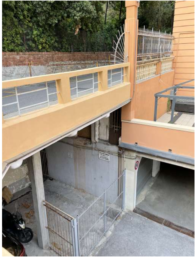
FOTO 3 – vista della superiore strada privata Lungoparco Groppallo che costituisce la copertura del magazzino
