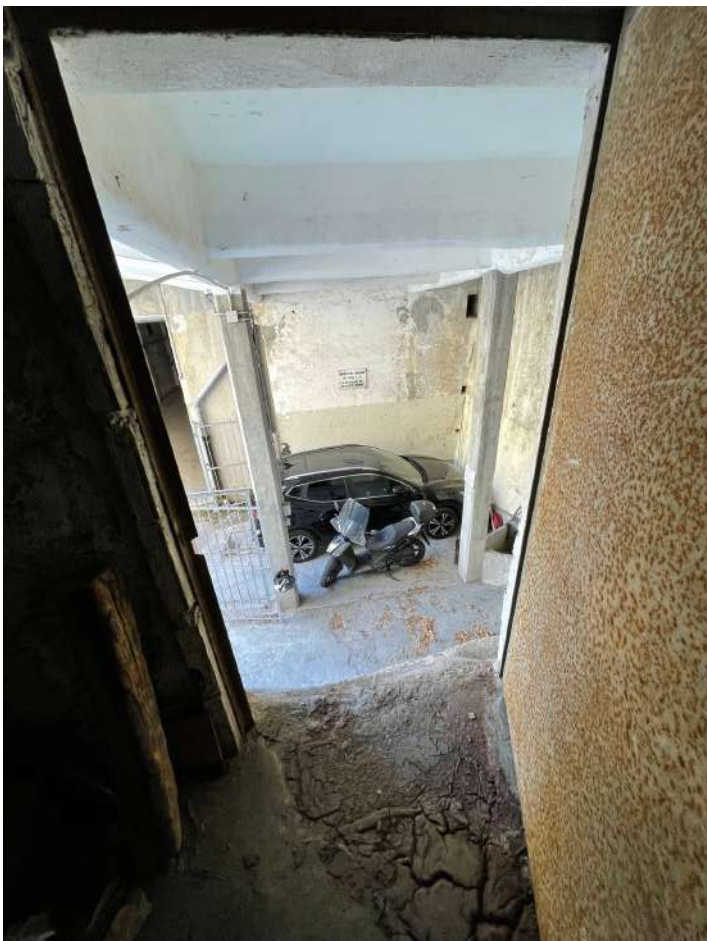
FOTO 10 – vista su area condominiale
