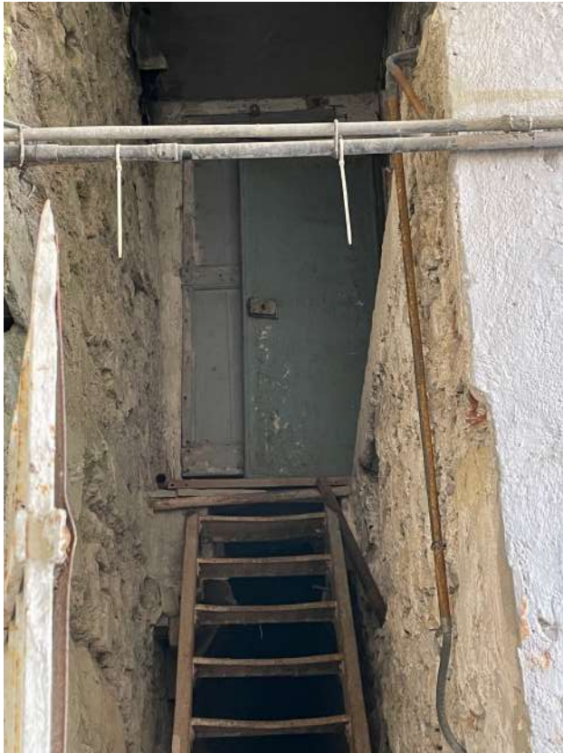
FOTO 7 – vista porta laterale di accesso al magazzino e vista porta frontale accesso intercapedine
