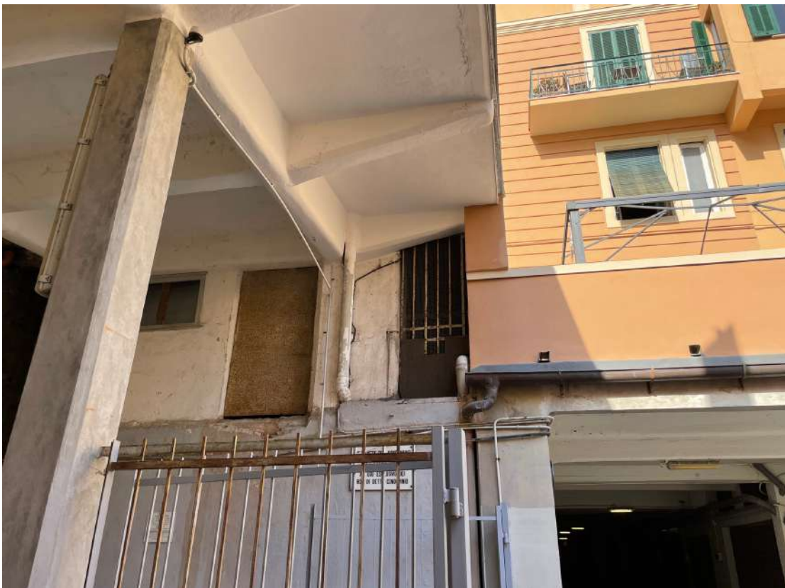
FOTO 8 – vista dal basso (zona condominiale) di porta accesso intercapedine e magazzino
