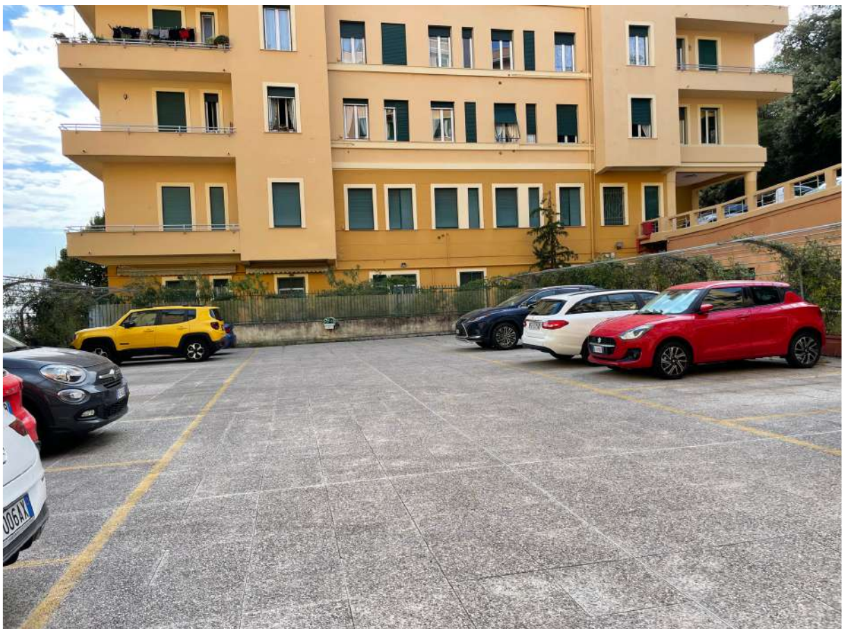
FOTO 6 – vista dell'area parcheggio
