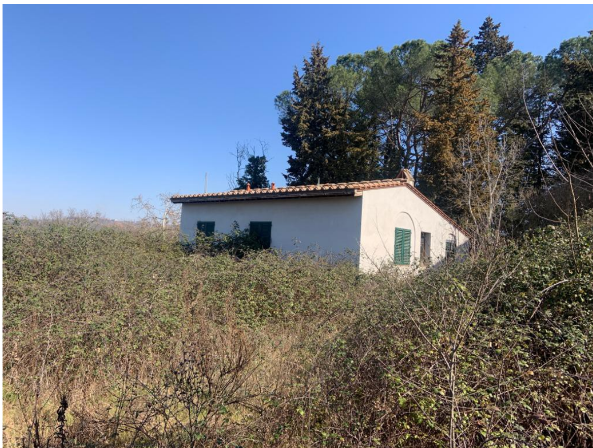
Foto n. 1 – “Immobile 1 parte a”
