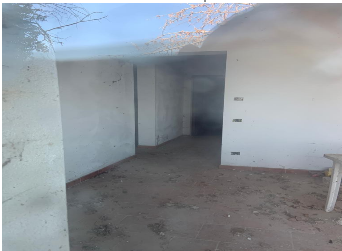
Foto 3 – “Immobile 1 parte a” interno
