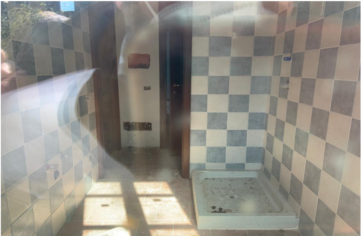
Foto 4 – “Immobile 1 parte a” interno
