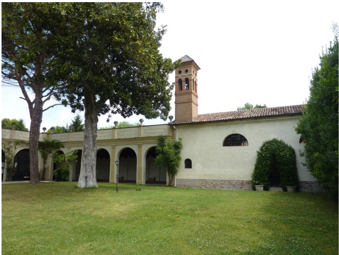
Foto n. 7 Portico e prospetto ovest dell'oratorio
