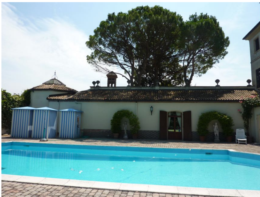
Foto n. 9 Area piscina e prospetto nord ala est
