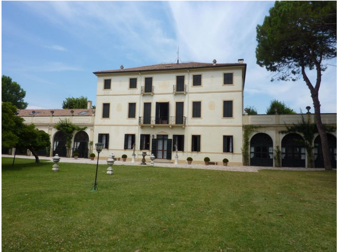
Foto n. 5 Prospetto sud corpo centrale e ali porticate adiacenti
