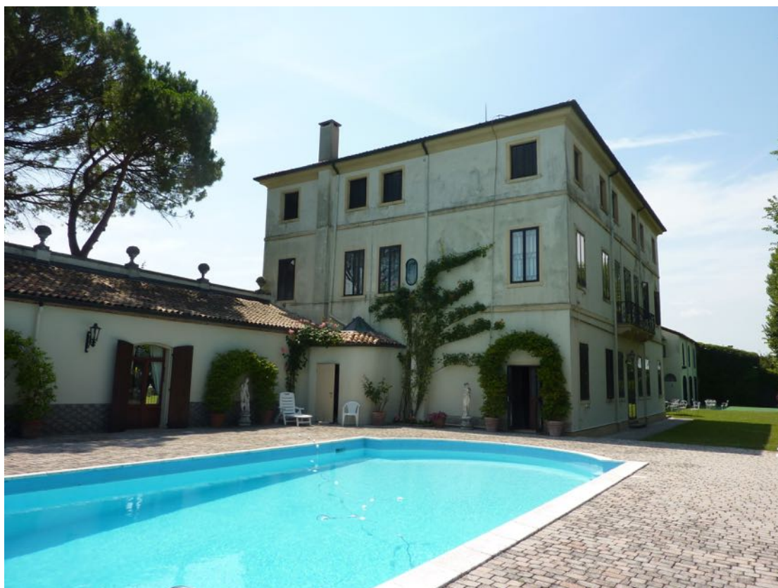
Foto n. 10 Prospetti est e nord del corpo centrale e locale tecnico abusivo
