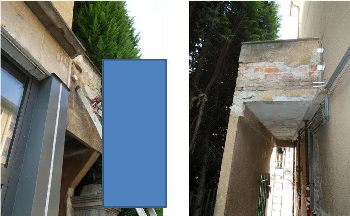
Interventi di messa in sicurezza: demolizioni intonaci deteriorati
