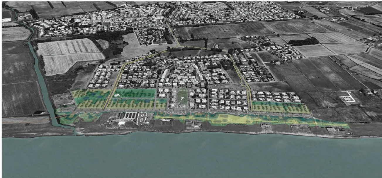
VISTA DALL'ALTO DEL PROGETTO NEL SUO INSIEME - FASE UNO E FASE DUE
