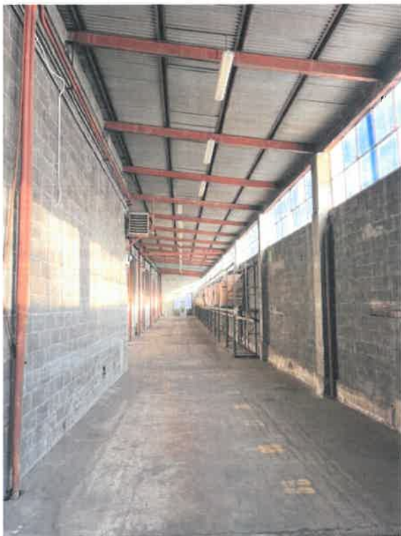
TETTOIE COPERTE LATERALI (INTERNO)
