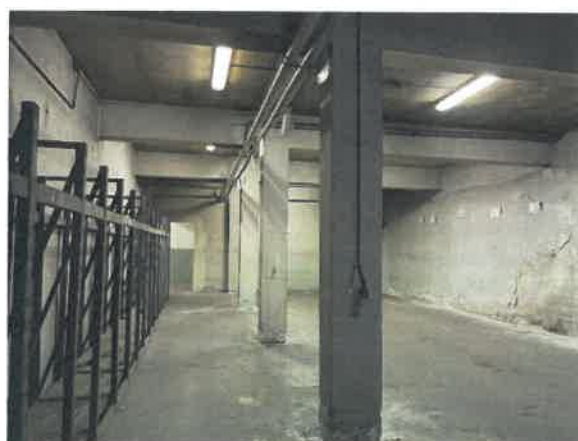
PALAZZINA UFFICI – DEPOSITO PIANO INTERRATO
