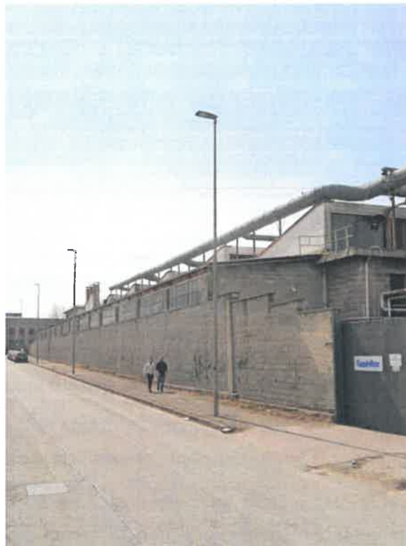
TETTOIE COPERTE LATERALI (VISTA DA VIA FERMI)
