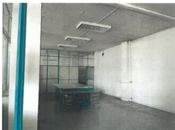
PALAZZINA UFFICI – LABORATORIO PIANO TERRENO
