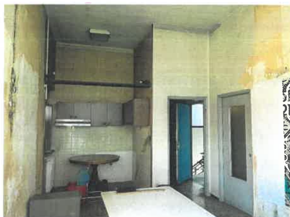
PALAZZINA UFFICI – ALLOGGIO CUSTOD
