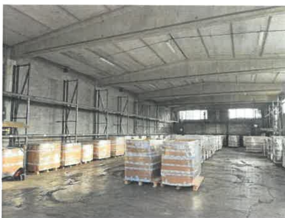
MAGAZZINO INTERNO CORTILE (VISTA INTERNO)
