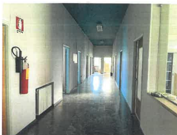
PALAZZINA UFFICI – LOCALI PIANO PRIMO
