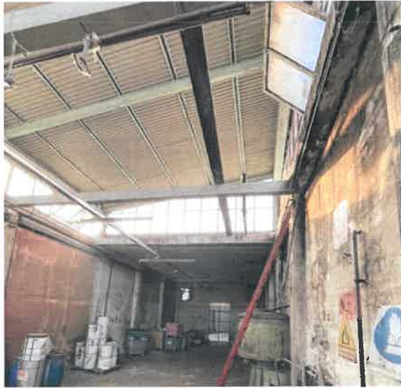
TETTOIE E DEPOSITI (VISTA INTERNO)
