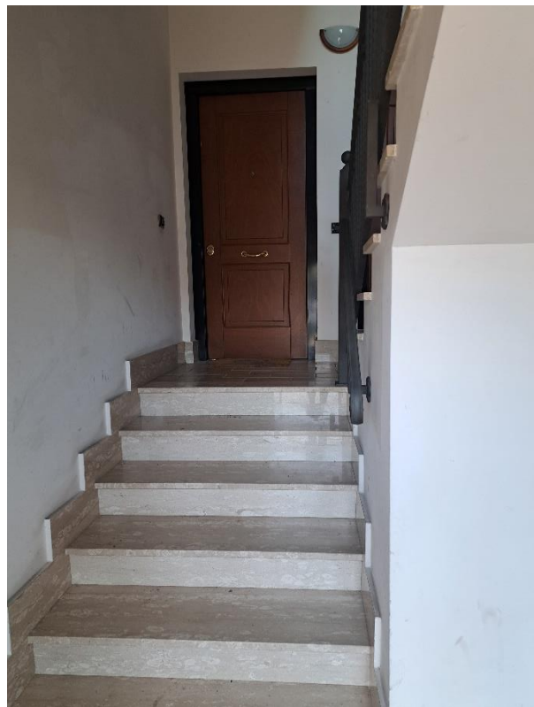
ANDRONE SCALE FABBRICATO
