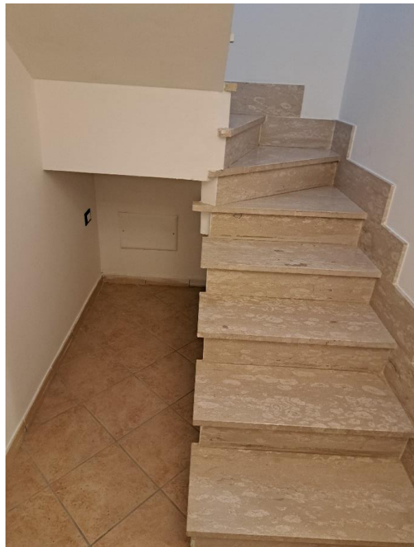
SCALA COLLEGAMENTO INTERNA
