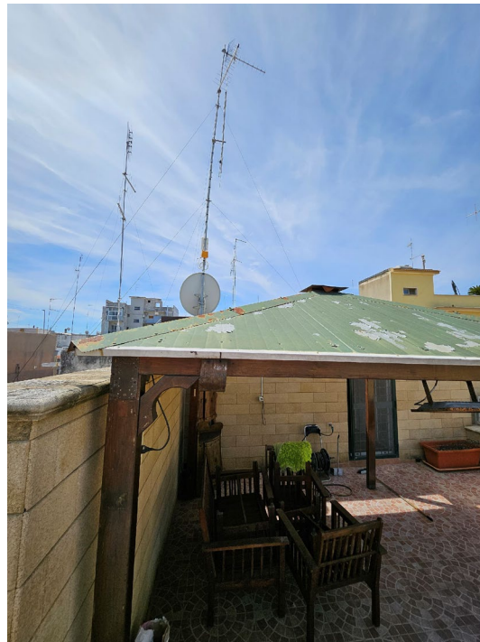
Vista del gazebo in legno ancorato a pavimento e copertura in pannelli coibentati e lamiera-opera illegittima
